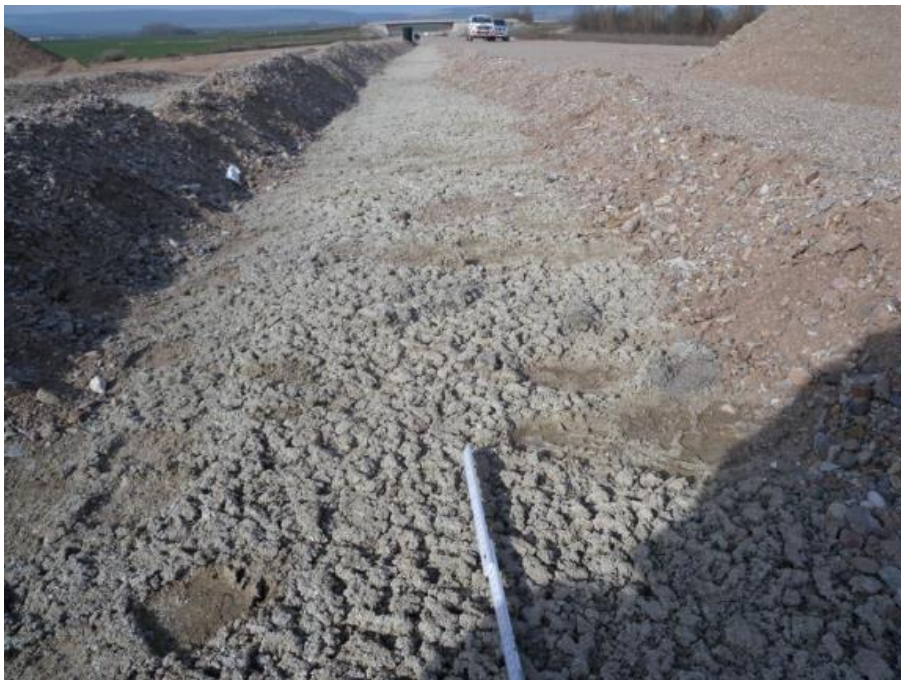
Abbildung 2.13: Aufgequollenes Planum durch Treibmineralien. A71 AS Sömmerda Ost [20]
