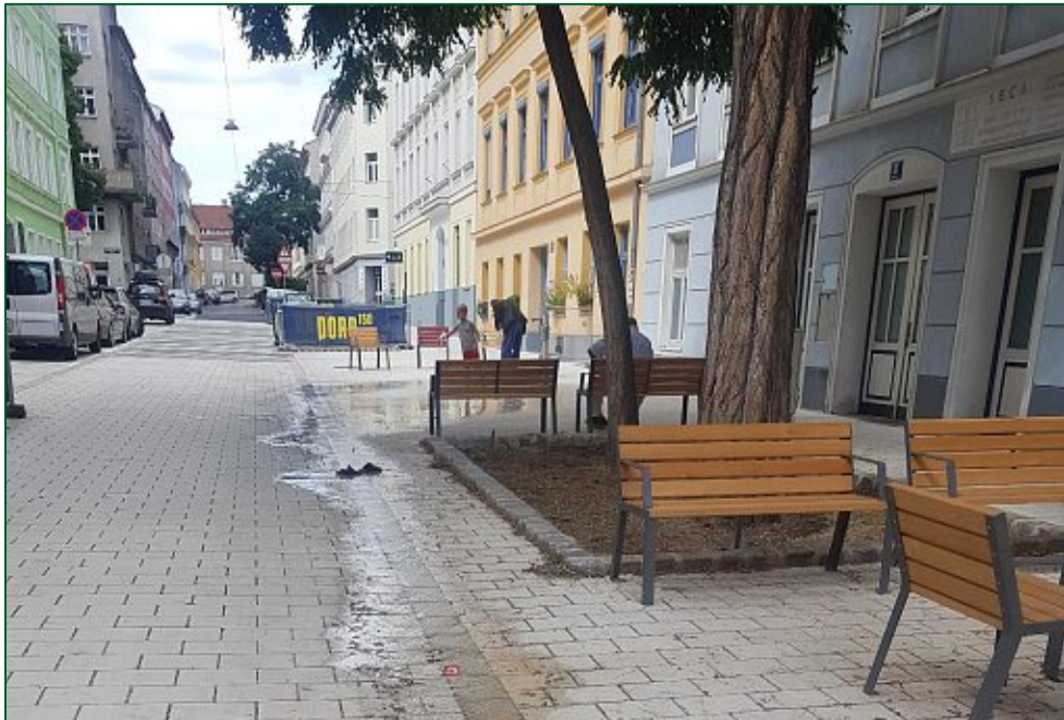
Abbildung 27: Nach dem Schwammstadt-Prinzip umgebaute Pelzgasse; Quelle: eigenes Foto, 23.08.2020
