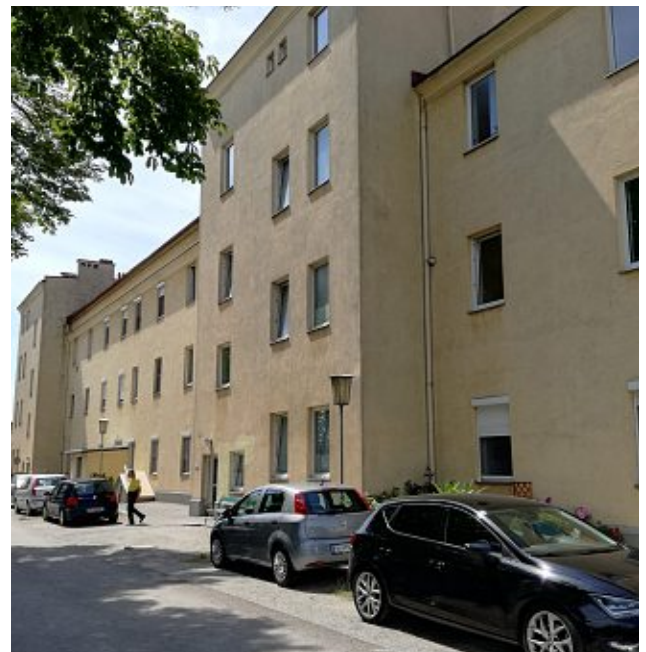
Abb. 33: Wohnbau in Baublock 301. Eigenes Foto.
