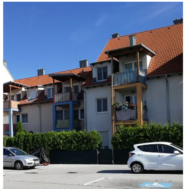
Abb. 27: Wohnbau in Baublock 105. Eigenes Foto.
