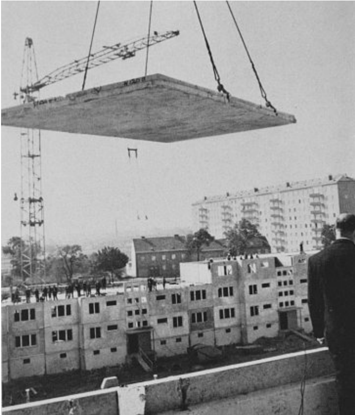
Foto auf der Baustelle der Wohnhausanlage Siebenbürgerstraße
