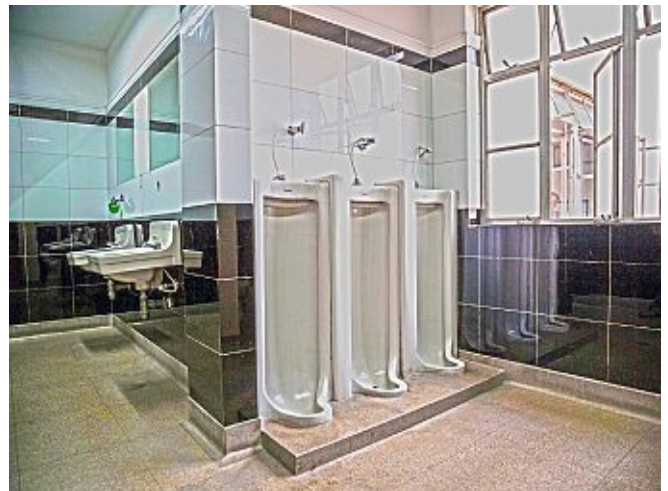
Abb. 39 Toiletten ausgekleidet mit englischem Vitrolite
