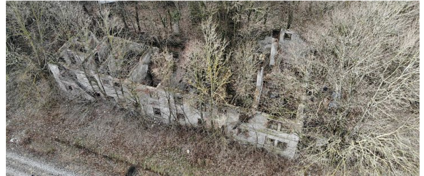
Abb. 24 Ruine von der Mühle am Hof №4/ Drohneaufnahme
