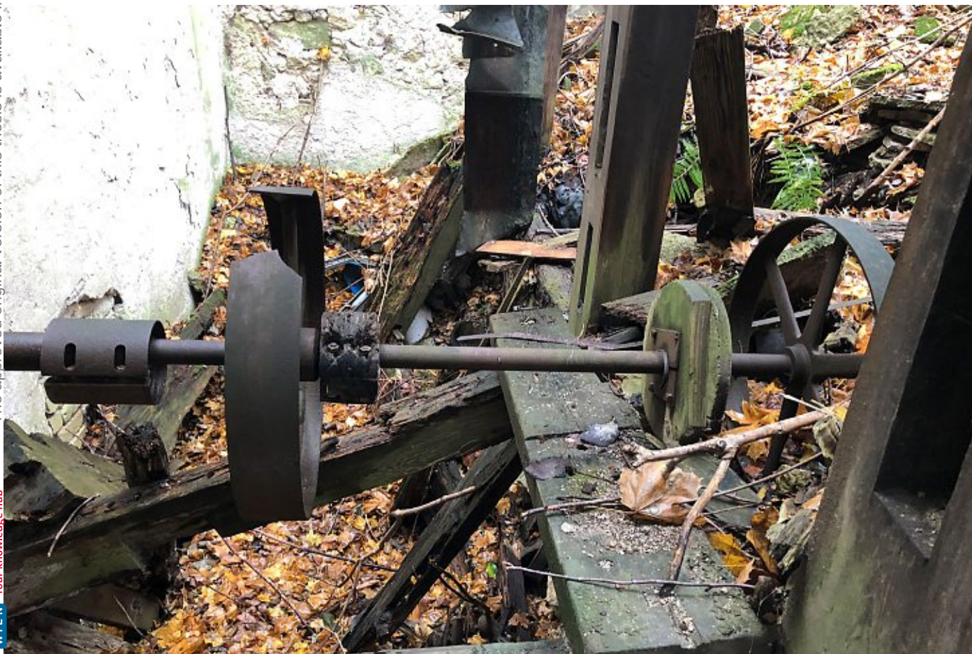
Abb. 30 Ruine von der Mühle am Hof №4 / Wasserrad/2019
