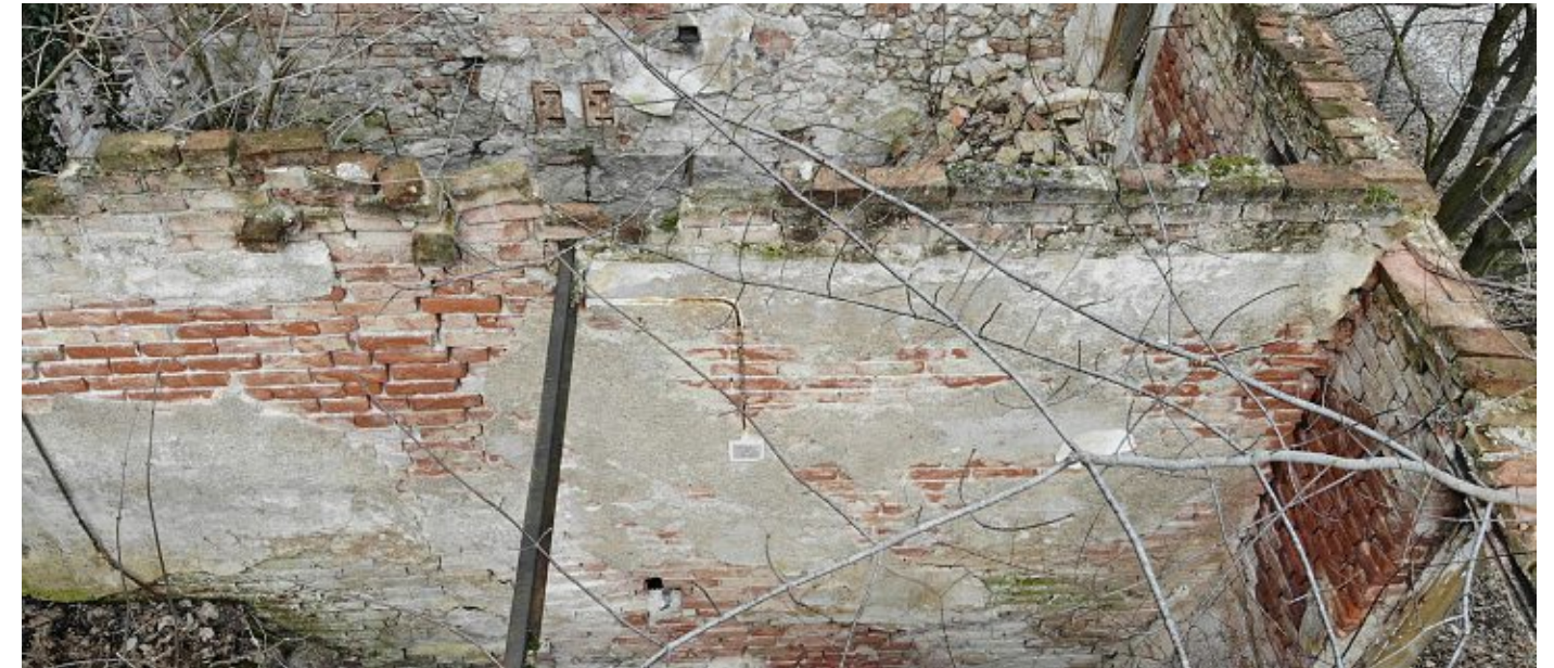
Abb. 25 Ruine von der Mühle am Hof №4, Details/ Drohneaufnahme
