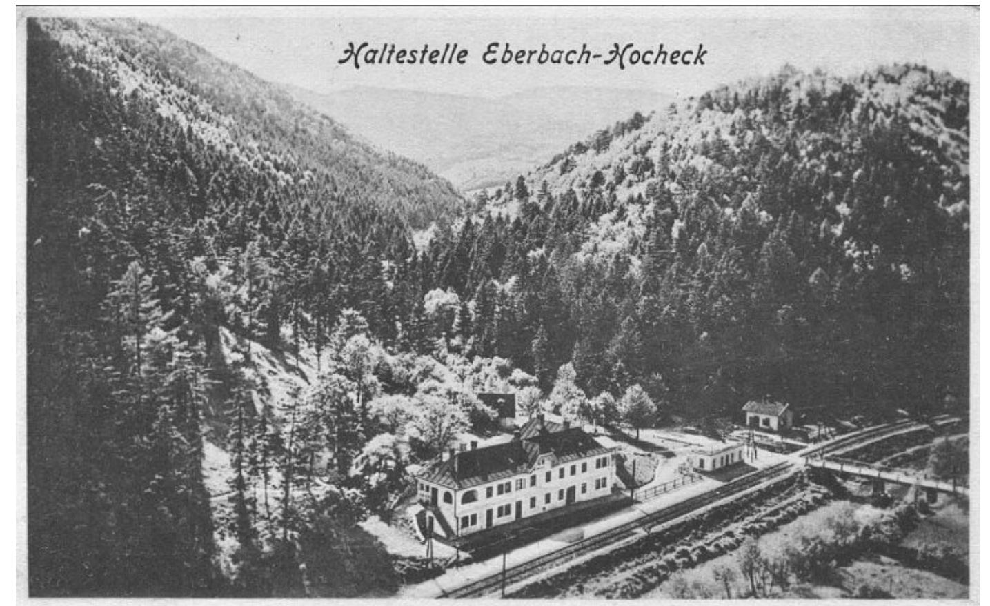
Abb. 12 Mühle am Hof und Haltestelle Eberbach-Hocheck zwischen 1911-1920. https://www.meinbezirk.at/triestingtal/c-lokales/es-war-einmal-muehle-am-hof-und-haltestelle-eberbach_a1642245 (letzter Zugriff am 06.03.2020)
