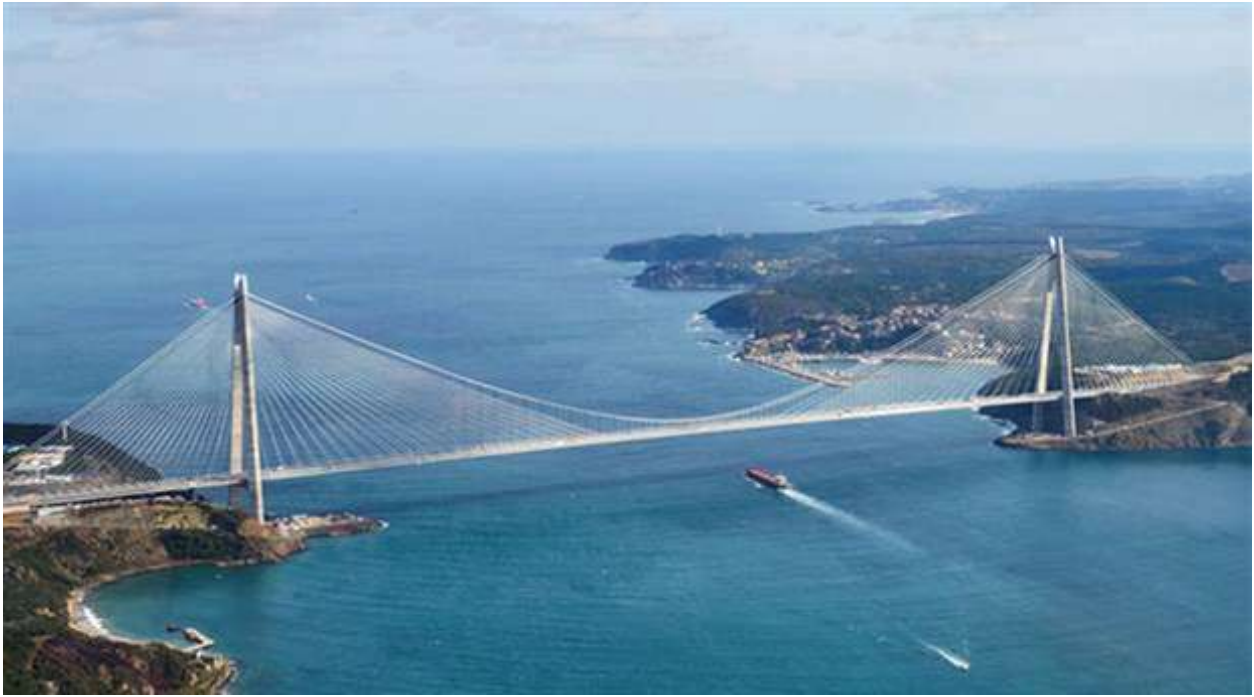
Abb. 6: Dritte Brücke – Yavuz-Sultan-Selim-Brücke
