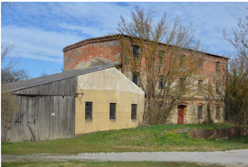
Abb. 80: Das ehemalige Magazingebäude, Süd- und Westfassade, März 2020
