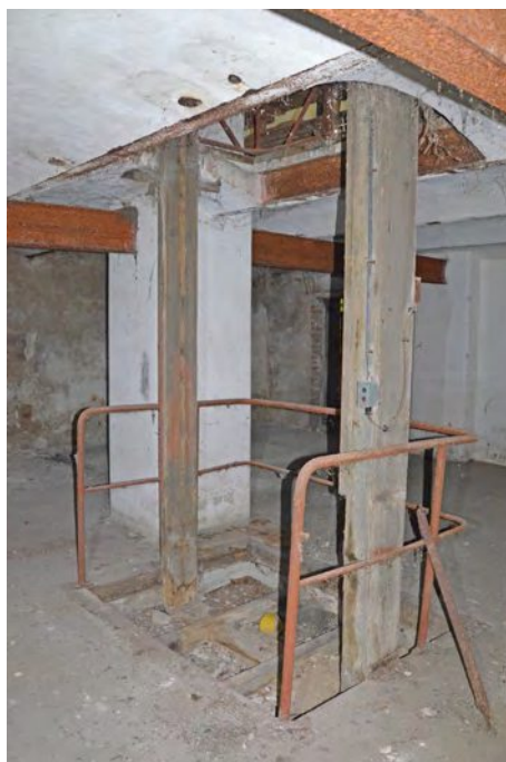
Abb. 111: Aufzug, Seitenansicht, Mai 2020
