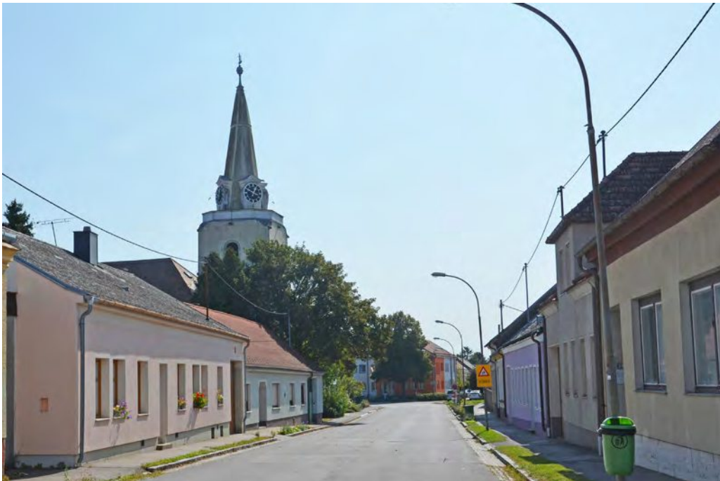
Abb. 24: Drösinger Hauptstraße, Blick Richtung Süden, September 2020
