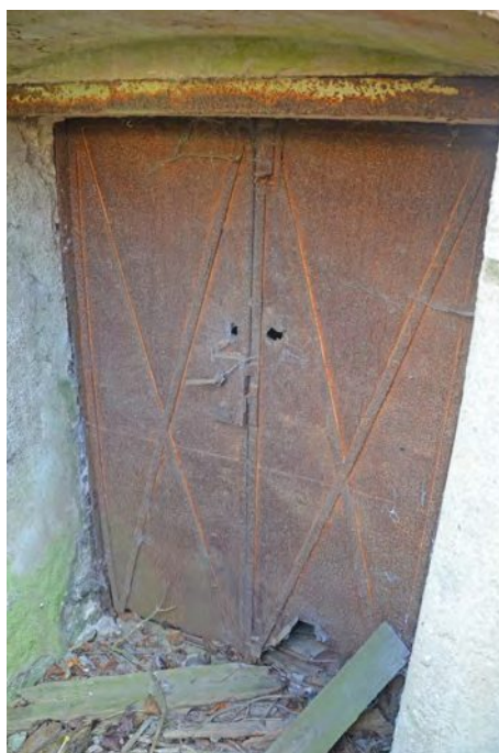
Abb. 109: Tür T-K1.1, Außenansicht, Mai 2020
