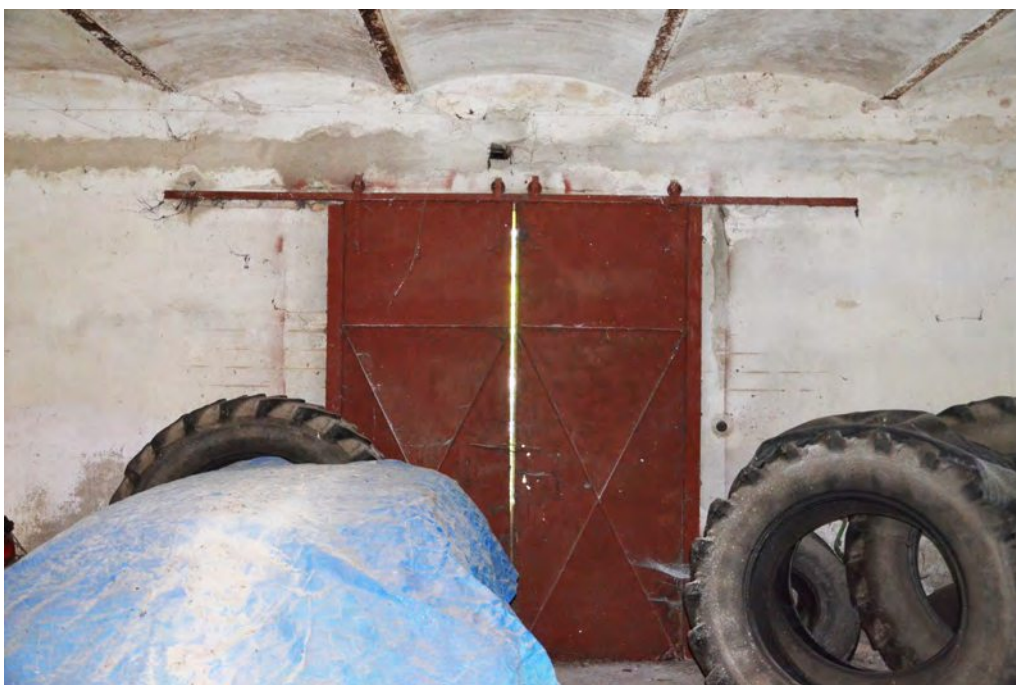
Abb. 127: Wand W-E1.A und Tür T-E1.1, Mai 2020
