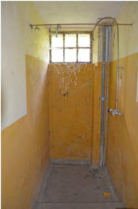
Abb. 140: Blick Richtung Wand W-E3.B, Mai 2020
