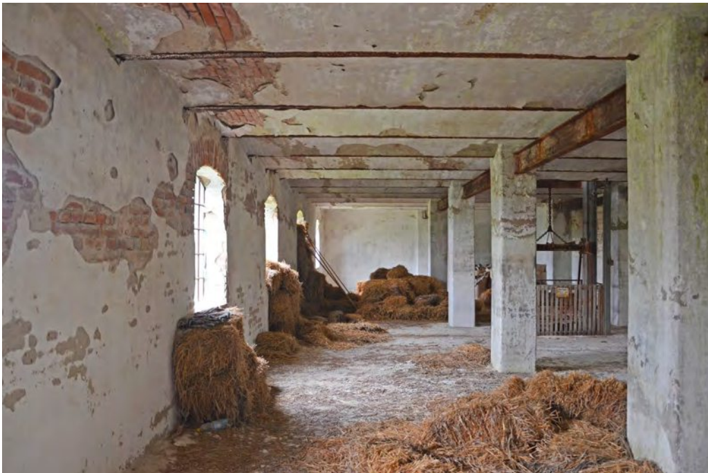
Abb. 154: Blick Richtung Wand W-01.B, links: Wand W-01.A, Mai 2020
