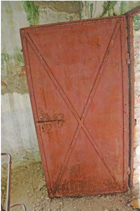
Abb. 172: Tür T-D2.1 in Raum D2, Mai 2020
