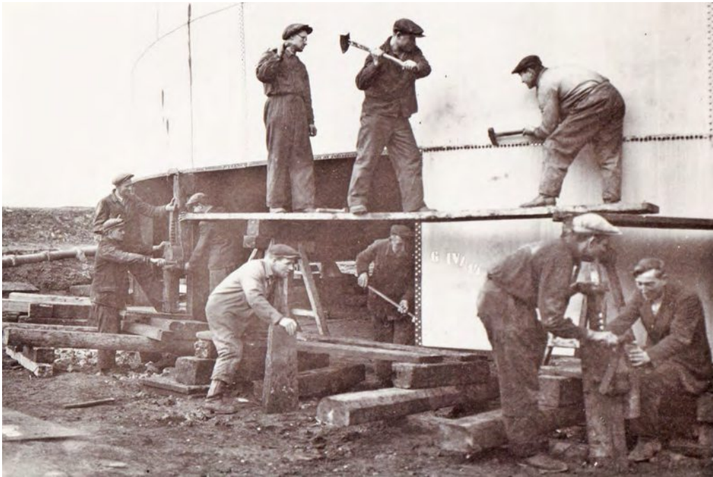
Abb. 58: Demontage eines Stahl tanks der Drösinger Petroleumraffinerie, Die Niete werden abgesprengt, um 1937
