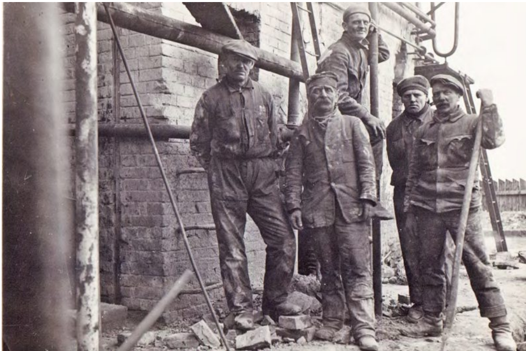
Abb. 68: Arbeiter vor einem Gebäude der Drösinger Petroleumraffinerie, o. J.
