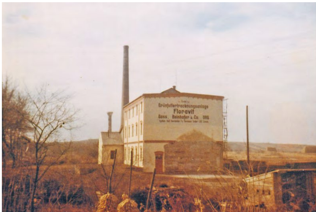
Abb. 60: Grünfutter-Trocknungsanlage „Floravit“, Blick Richtung Nordwesten auf das Gebäude, 1959
