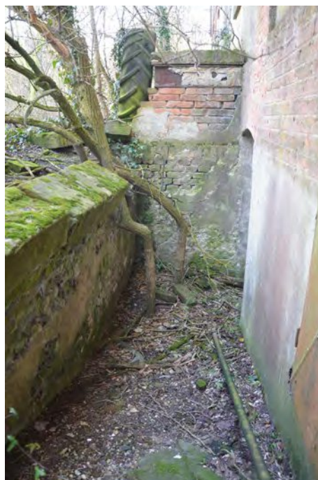
Abb. 181: Rampe Kellergeschoß, Mai 2020
