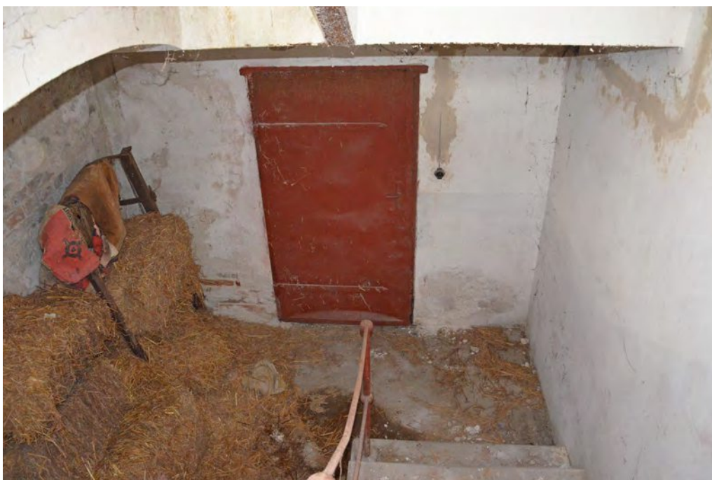
Abb. 118: Blick Richtung Wand W-K3.D und Tür T-K3.1, rechts: Wand W-K3.A, Oktober 2020
