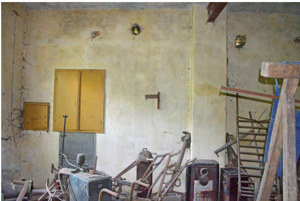
Abb. 133: Blick Richtung Wand W-E2.B, links: Wand W-E2.A, Mai 2020
