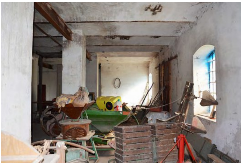
Abb. 124: Blick Richtung Wand W-E1.C, rechts: Wand W-E1.D, Oktober 2020
