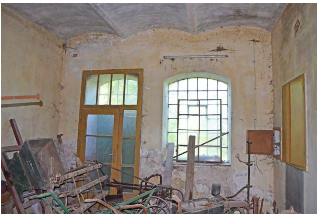
Abb. 131: Blick Richtung Wand W-E2.A, links: Wand W-E2.D, rechts: Wand W-E2.B, Mai 2020
