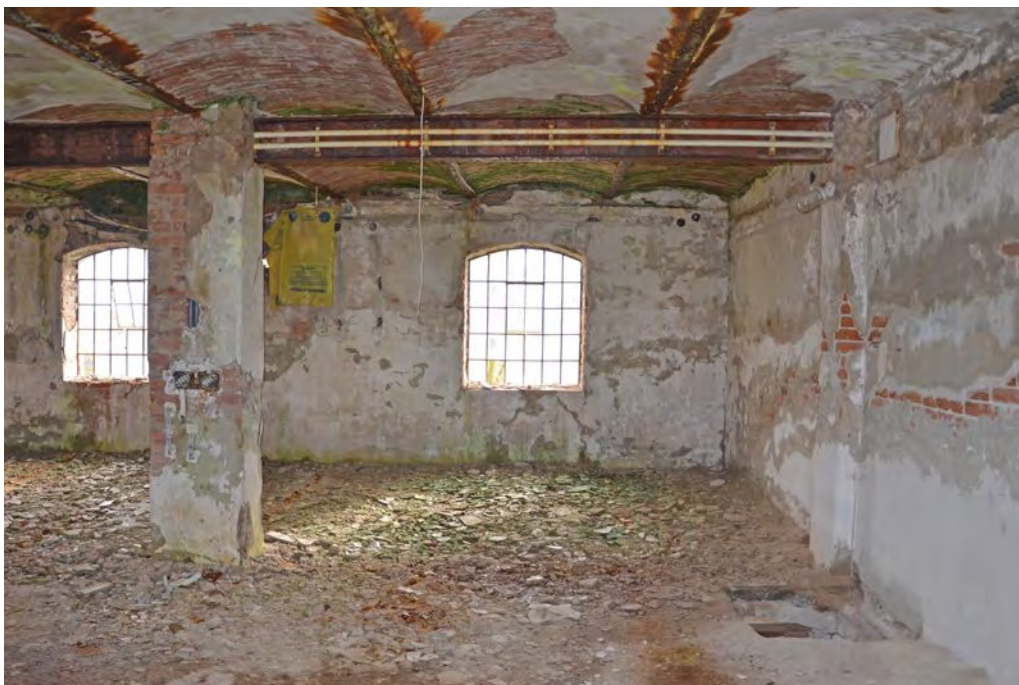
Abb. 166: Blick Richtung Wand W-D1.E, rechts: Wand W-D1.F, Oktober 2020
