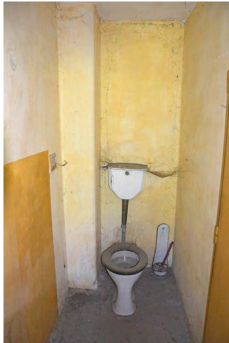
Abb. 141: Blick Richtung Wand W-E3.D, Mai 2020
