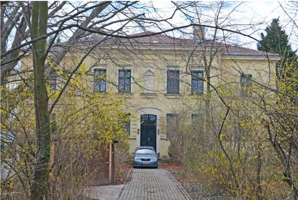
Abb. 76: Das ehemalige Verwaltungs- und Direktionsgebäude, Ostfassade, März 2020
