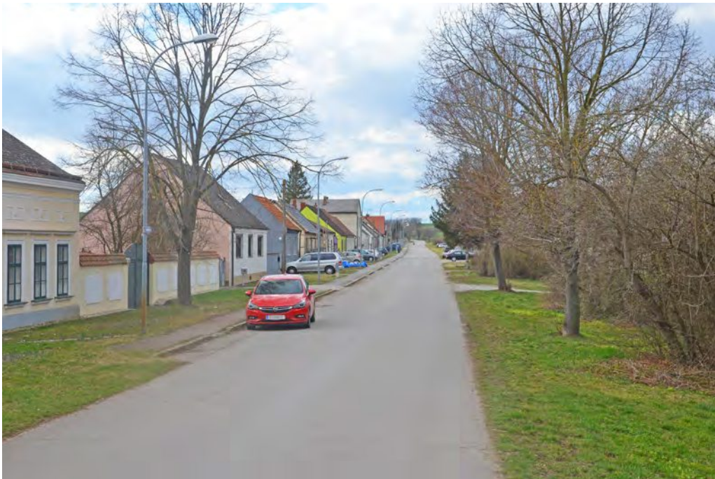
Abb. 83: Haidlstraße, Blick Richtung Westen, März 2020
