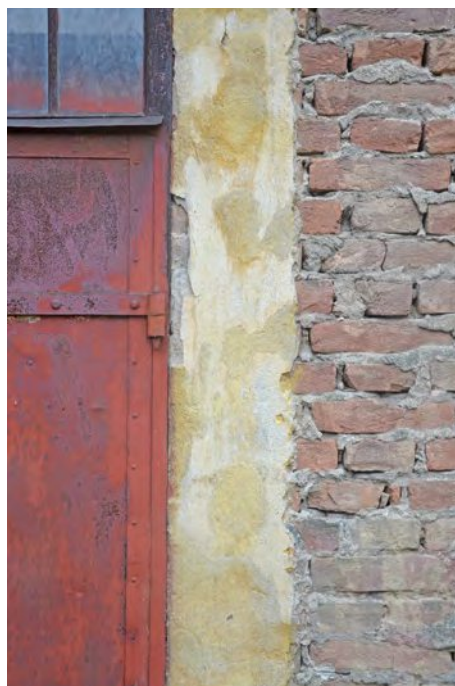
Abb. 185: Detailansicht, Tür T-E4.2, Mai 2020
