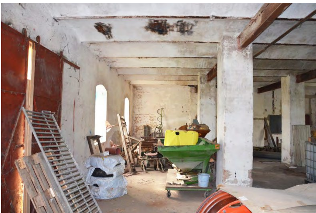
Abb. 123: Blick Richtung Wand W-E1.E, links: Wand W-E1.D, Oktober 2020
