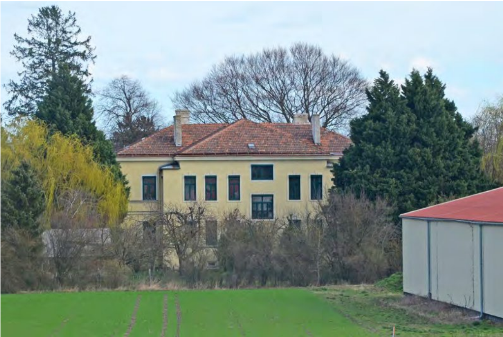
Abb. 77: Das ehemalige Verwaltungs- und Direktionsgebäude, Westfassade, März 2020
