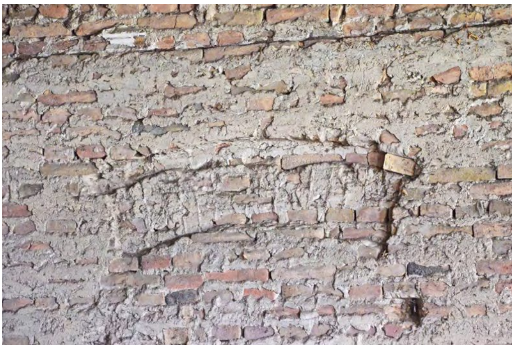
Abb. 192: Detailansicht, Umriß eines Fenstersturzes der ehemaligen Fassbinderei, Mai 2020
