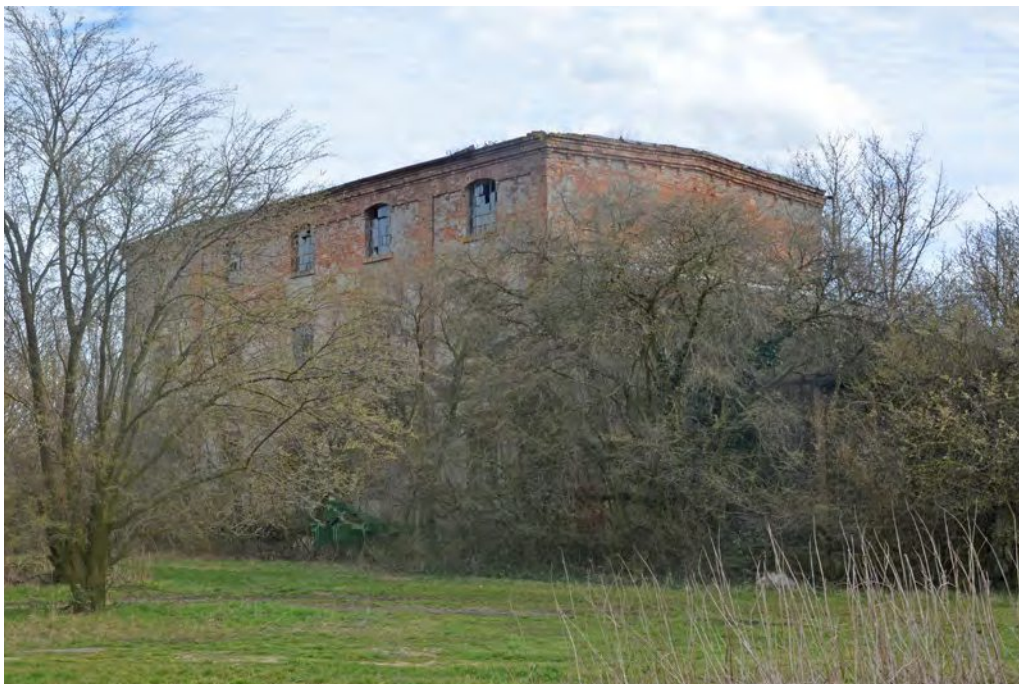
Abb. 81: Das ehemalige Magazingebäude, Nord- und Westfassade, März 2020
