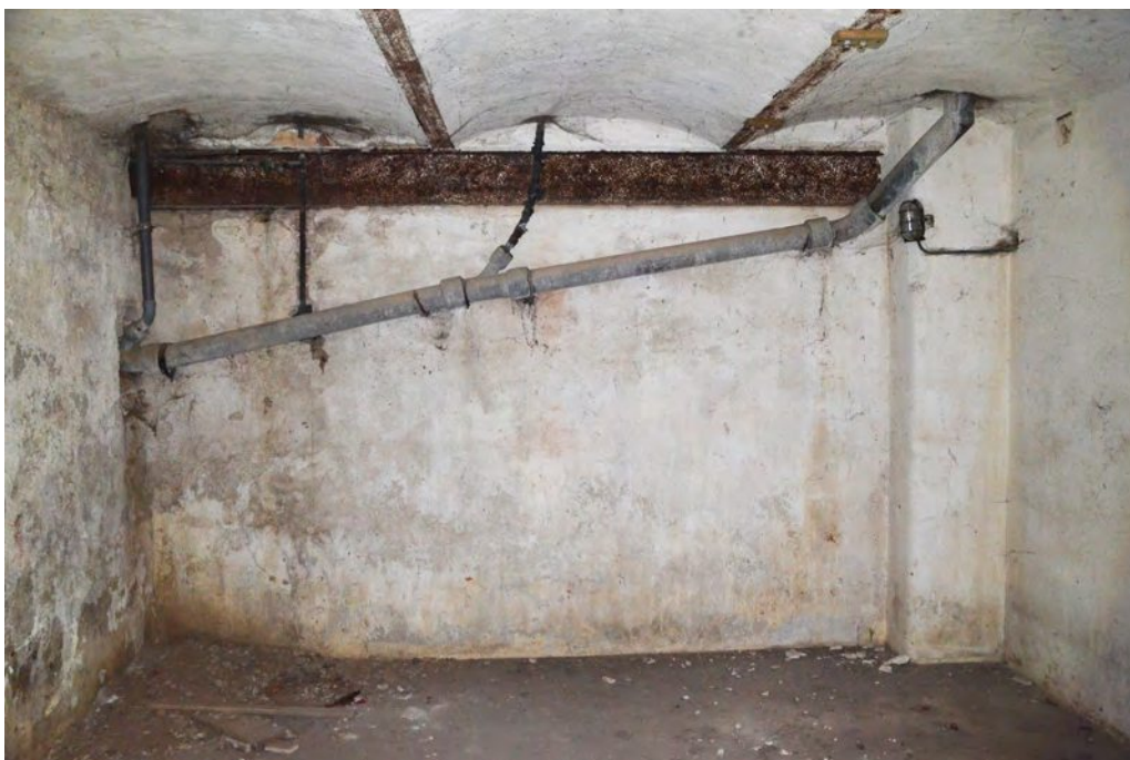
Abb. 114: Blick Richtung Wand W-K2.C, links: Wand W-K2.B, rechts: Wand W-K2.D, Oktober 2020
