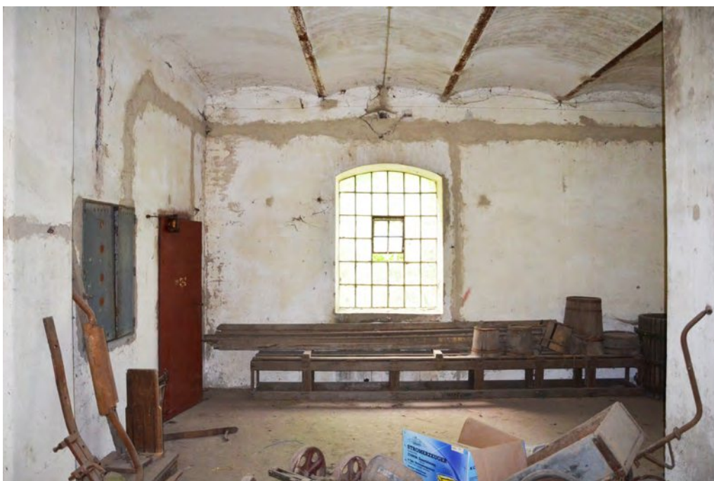
Abb. 125: Blick Richtung Wand W-E1.A und Fenster F-E1.1, links: Wand W-E1.E mit Tür T-E1.3, Mai 2020
