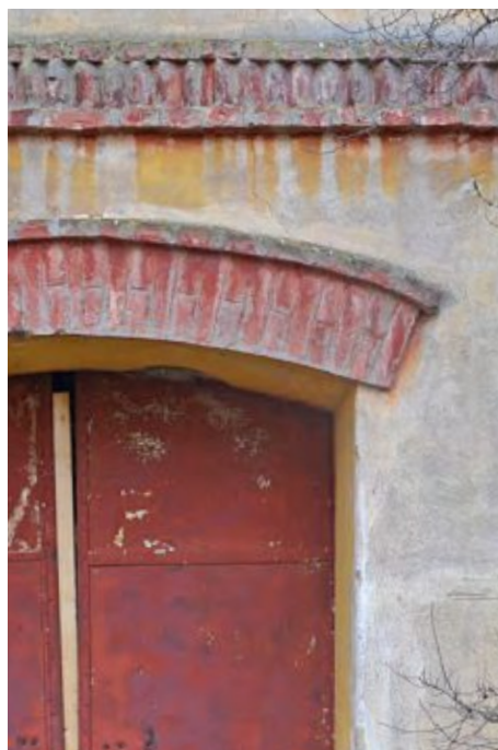
Abb. 189: Detailansicht, Tür T-E1.2, Mai 2020
