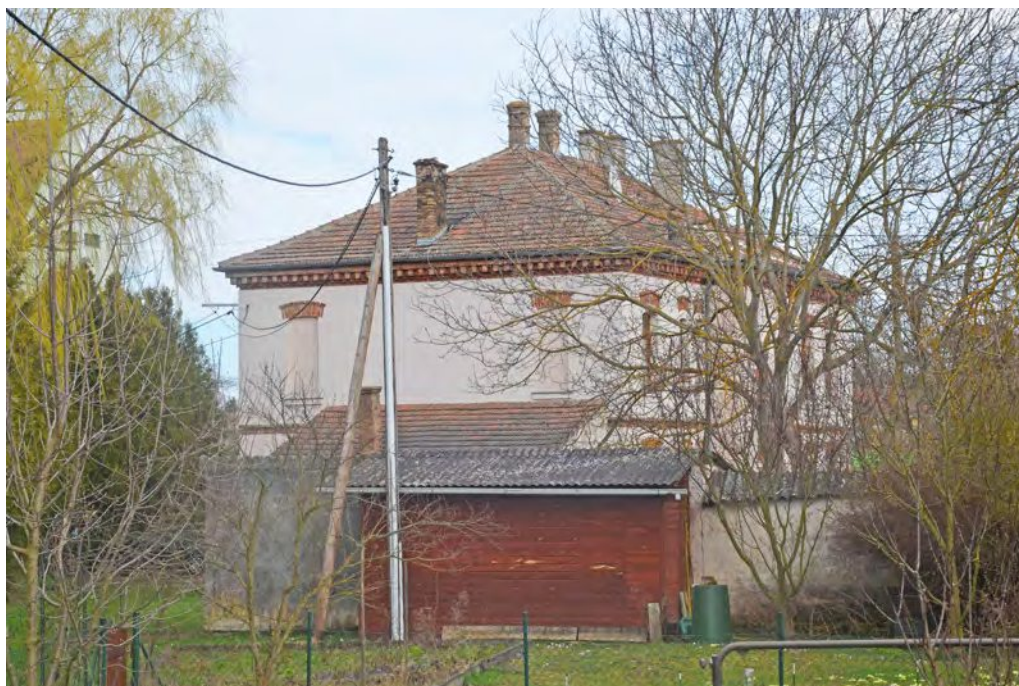
Abb. 79: Das ehemalige Wohnhaus der Fabriksarbeiter, Süd- und Westfassade, März 2020
