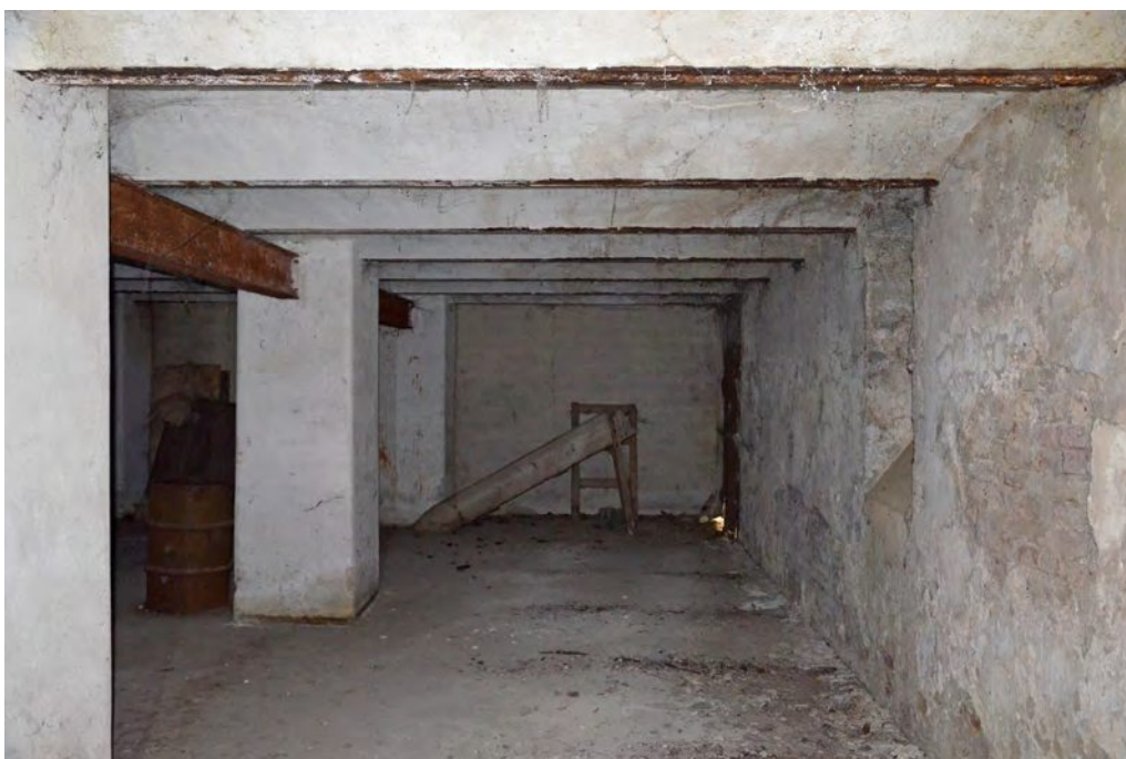
Abb. 106: Blick Richtung Wand W-K1.E, rechts: Wand W-K1.A, Mai 2020
