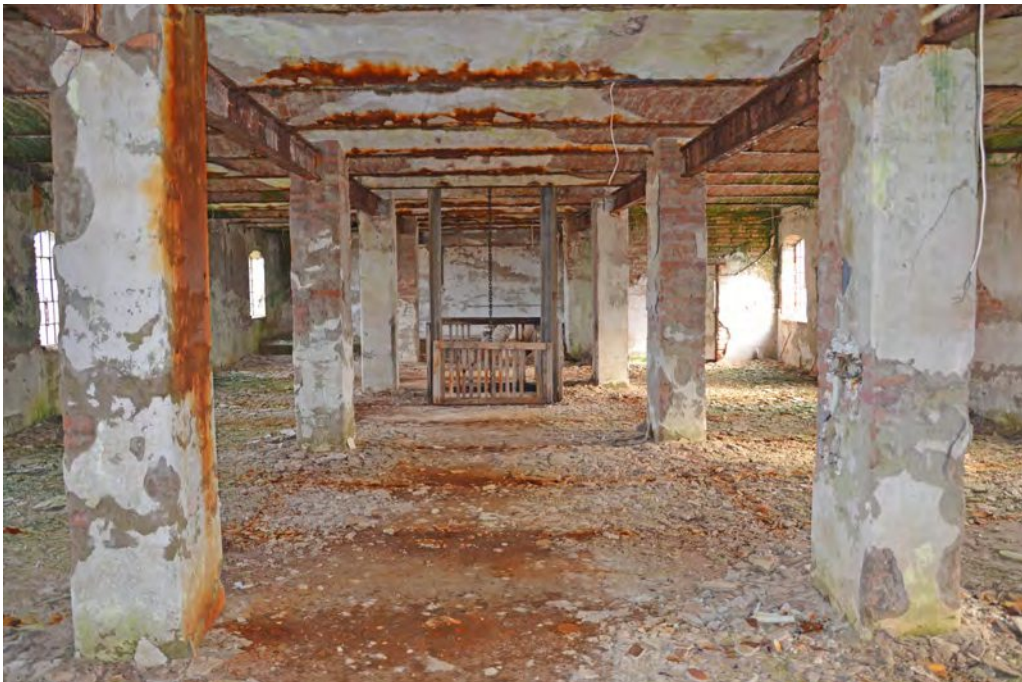
Abb. 168: Blick Richtung Wand W-D1.B, Oktober 2020
