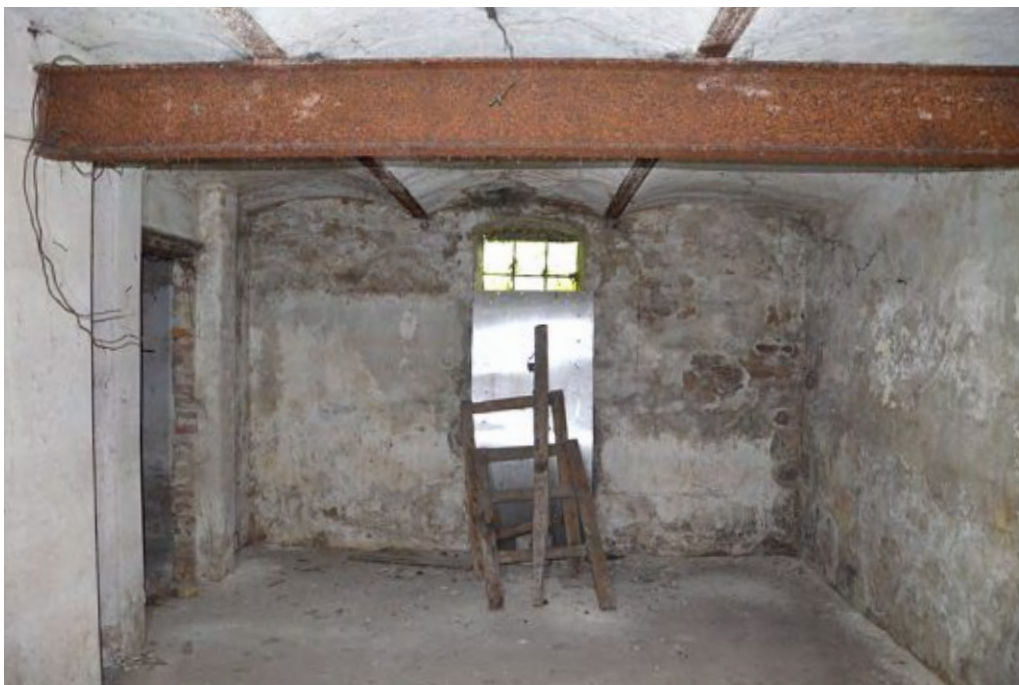
Abb. 113: Blick Richtung Wand W-K2.A, links: Wand W-K2.D, rechts: Wand W-K2.B, Mai 2020
