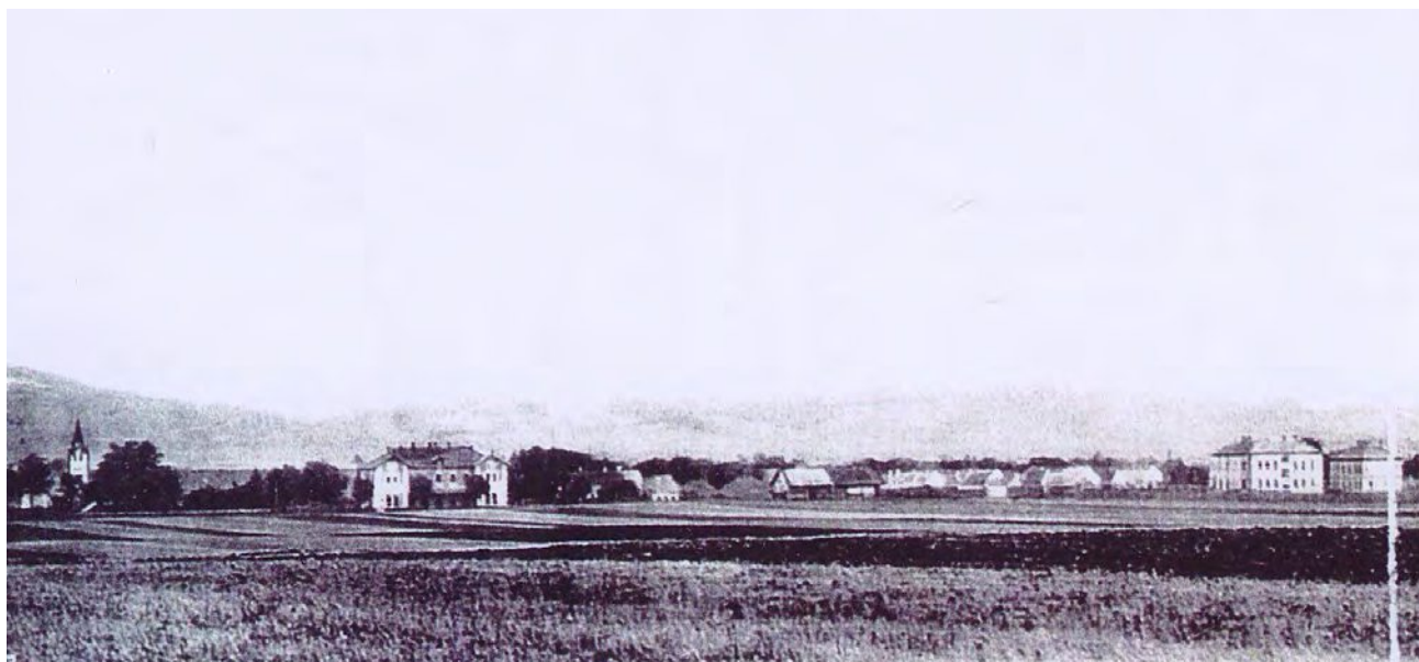
Abb. 73: Panorama der Drösinger Petroleumraffinerie mit Umgebung, Blick Richtung Südosten, vor 1924
