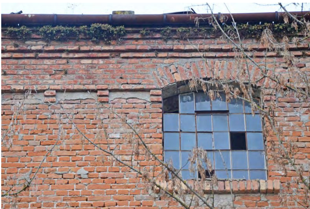
Abb. 187: Detailansicht, Fenster F-D1.6 und Traufgesims, Mai 2020
