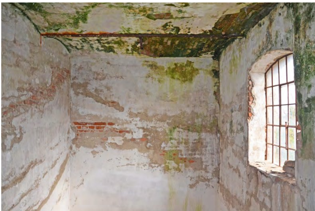
Abb. 171: Blick Richtung Wand W-D2.B, Oktober 2020
