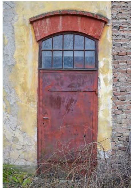
Abb. 149: Tür T-E4.2, Außenansicht, Mai 2020
