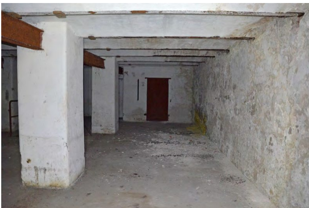
Abb. 105: Blick Richtung Wand W-K1.C, rechts: Wand W-K1.D, Mai 2020
