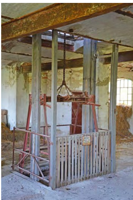
Abb. 156: Aufzug, Seitenansicht, Mai 2020
