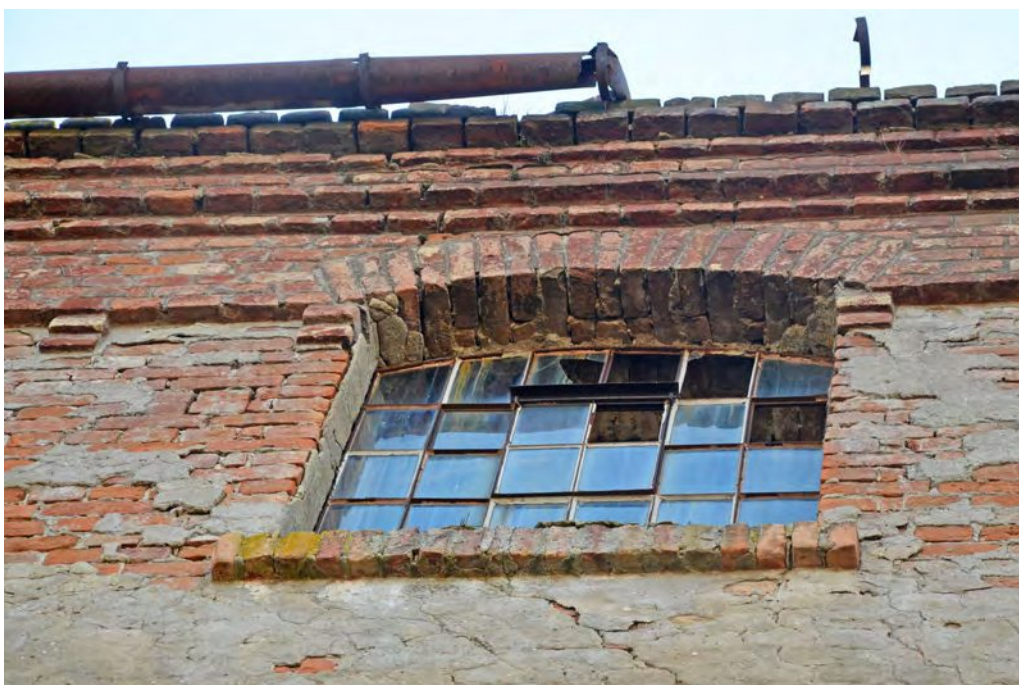
Abb. 179: Detailansicht, Fenster F-D1.1 und Traufgesims, Mai 2020
