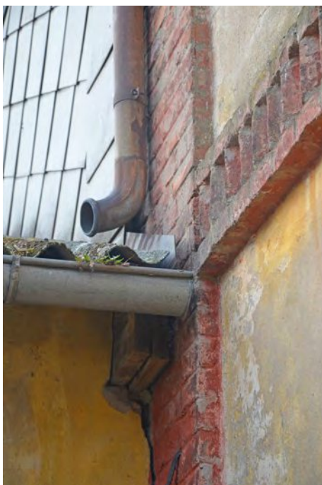
Abb. 188: Detailansicht, Bauteilfuge, Mai 2020
