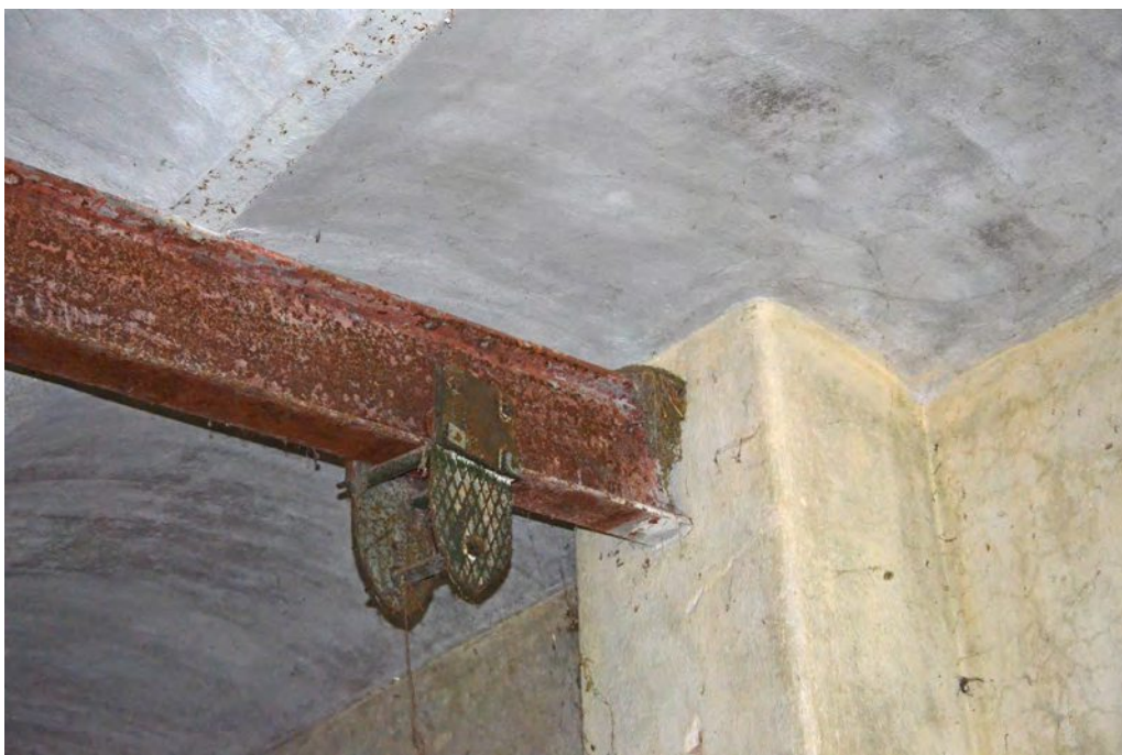
Abb. 134: Decke im Bereich der Wand W-E2.D, altes Rollfahrwerk auf Hauptträger, Mai 2020
