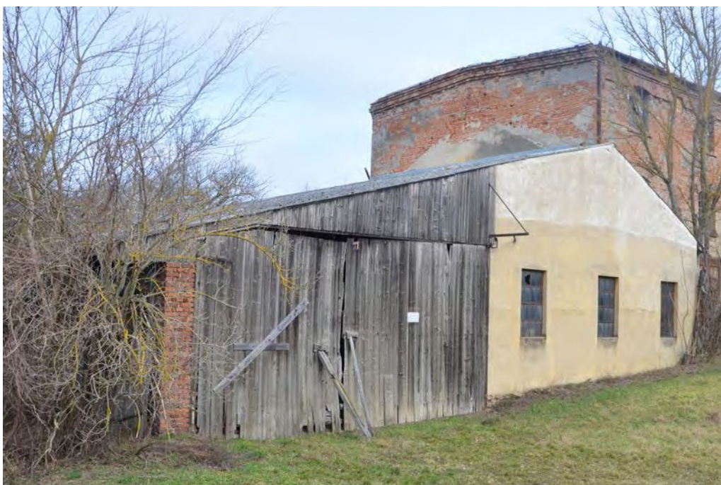
Abb. 194: Südfassade des Zubaus, Mai 2020
