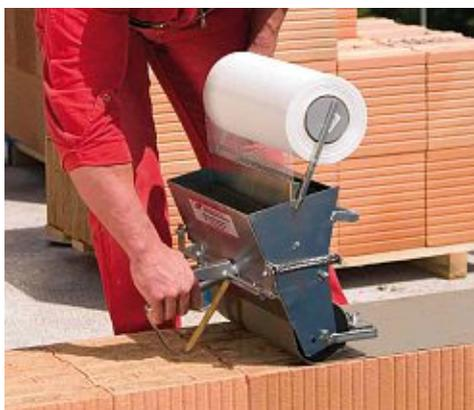
(a) Einbringen des Glasfasergewebes mit einer speziellen Mörtelwalze
