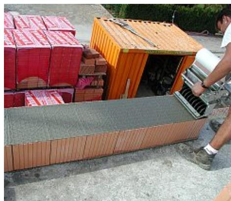
(b) Durchgehende Mörtelschicht durch das eingelegte Glasfasergewebe
