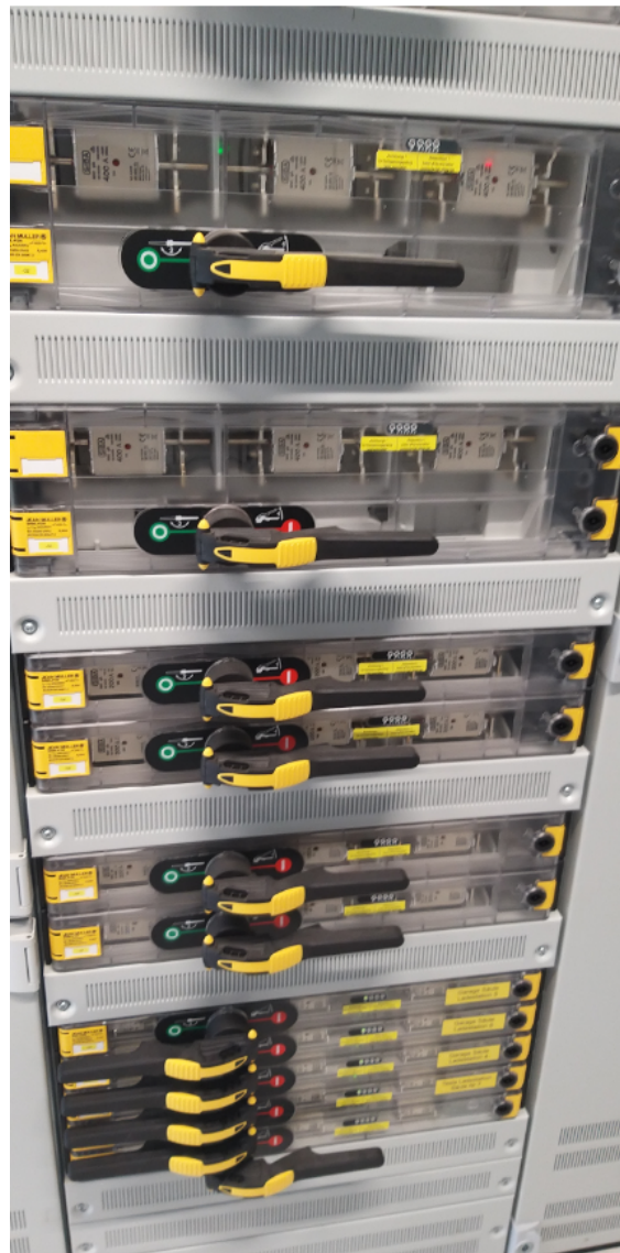
Abbildung 3.3: Abgänge Schaltschrank
