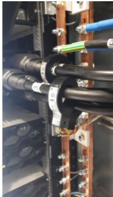
Abbildung 3.5: Stromwandler Abgang
