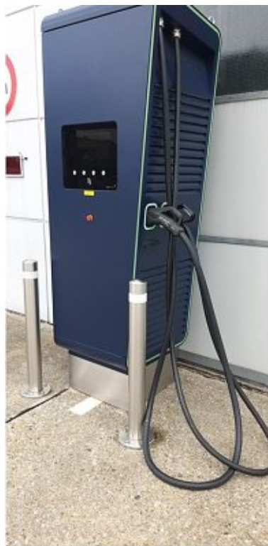
Abbildung 3.13: Schnellladesäule
