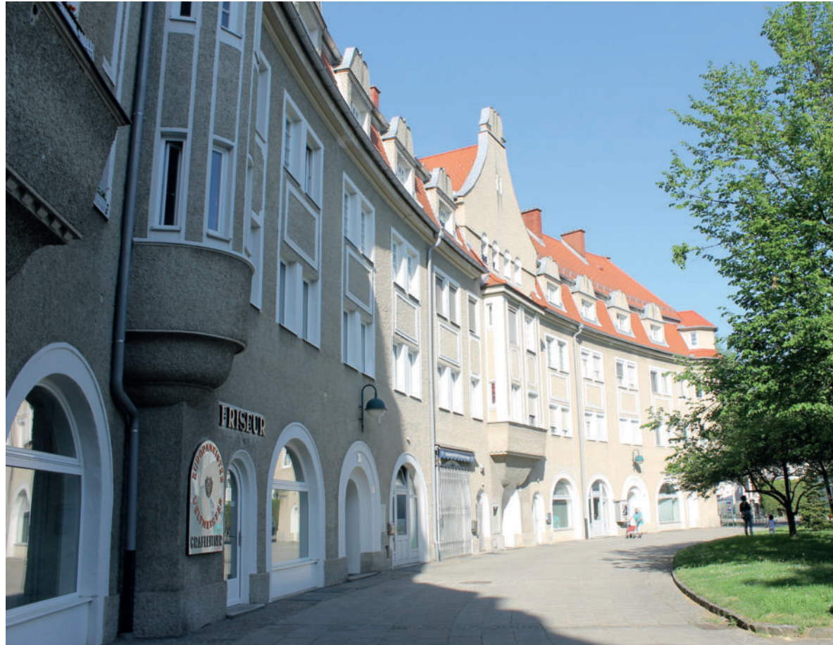
Abb. 28 Durchfahrt ins Hinterland aktuel- ler Zustand
