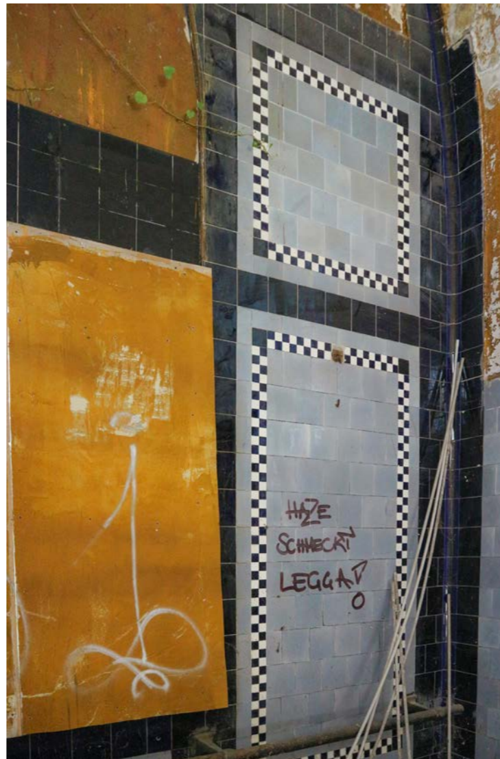
Abb. 6.35 Wandfliesen im Teigverarbeitungstrakt
