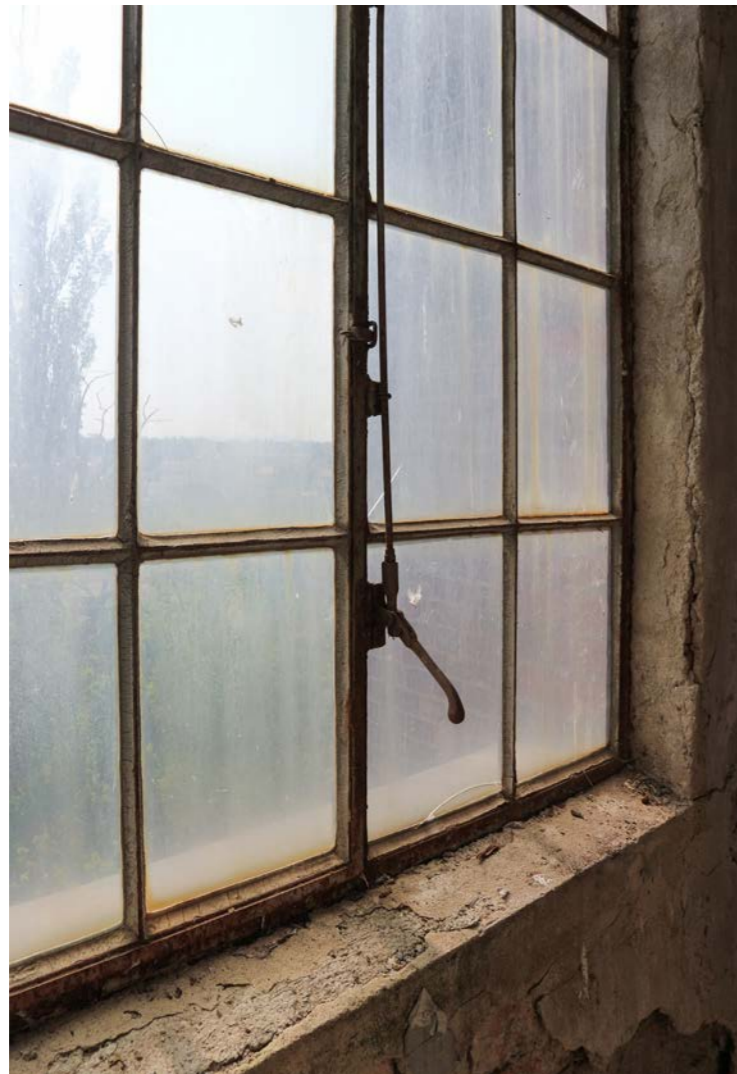
Abb. 6.5 Fensterdetail im Mehlspeicher, Öffnungsmechanismus
