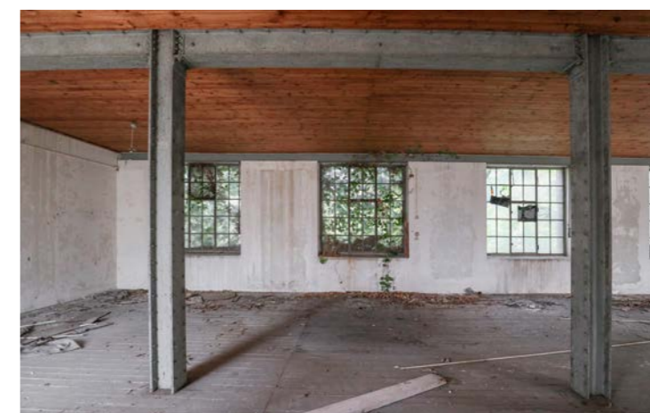
Abb. 6.20 Stahlträger und -stützen im Mehlspeicher 1.OG
