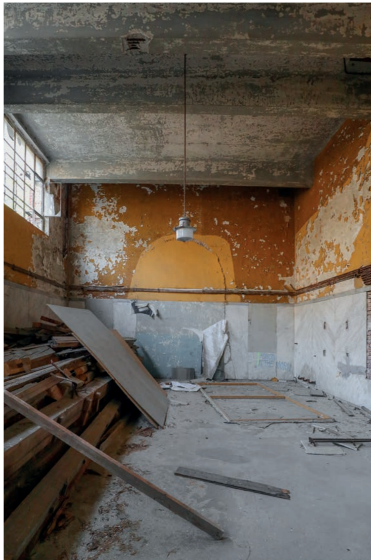
Abb. 7.14 Innenansicht des Sozialgebäudes
