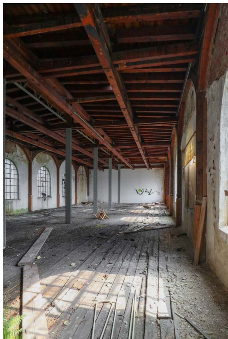
Abb. 6.18 Sichtbare Deckenkonstruktion im obersten Geschoß des Mehlspeichers
