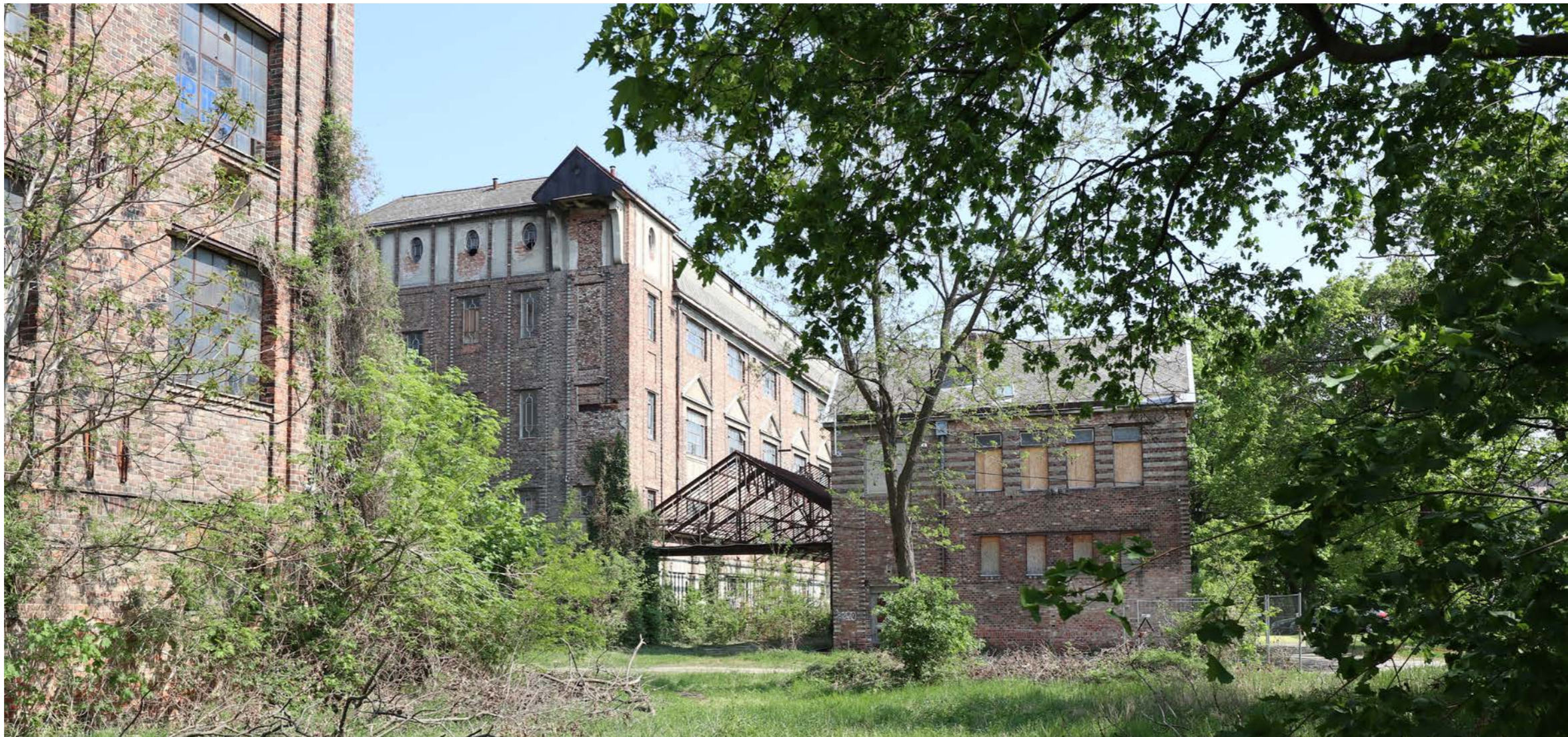
Abb. 0.1 Außenansicht der Hammermühlwerke von Westfalen. Links das Sozialgebäude und rechts das Direktionsgebäude mit dazwischen liegenden Glashof
