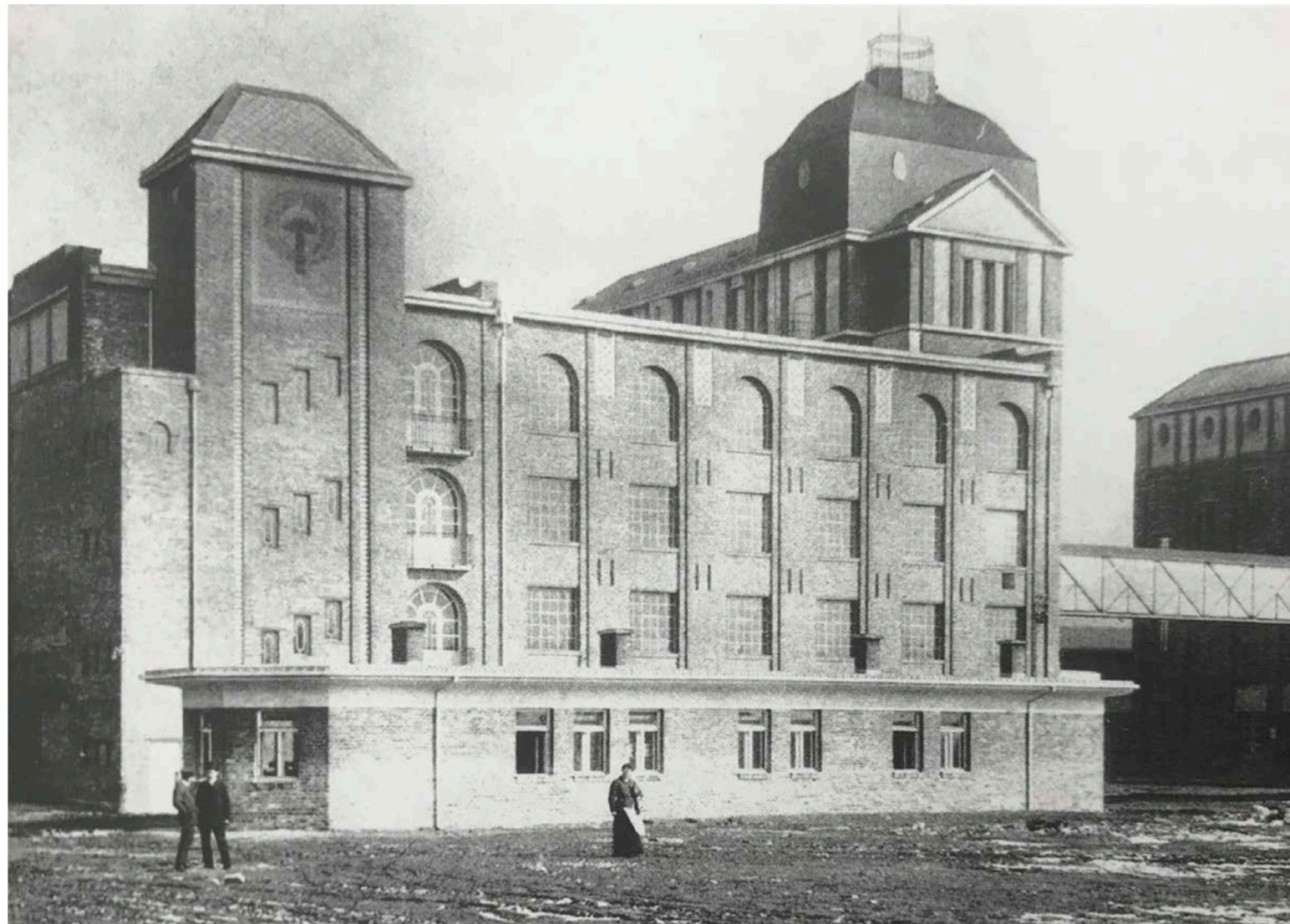
Abb. 4.8 Historische Ansicht der Mühle und des Mehlspeichers 1910
