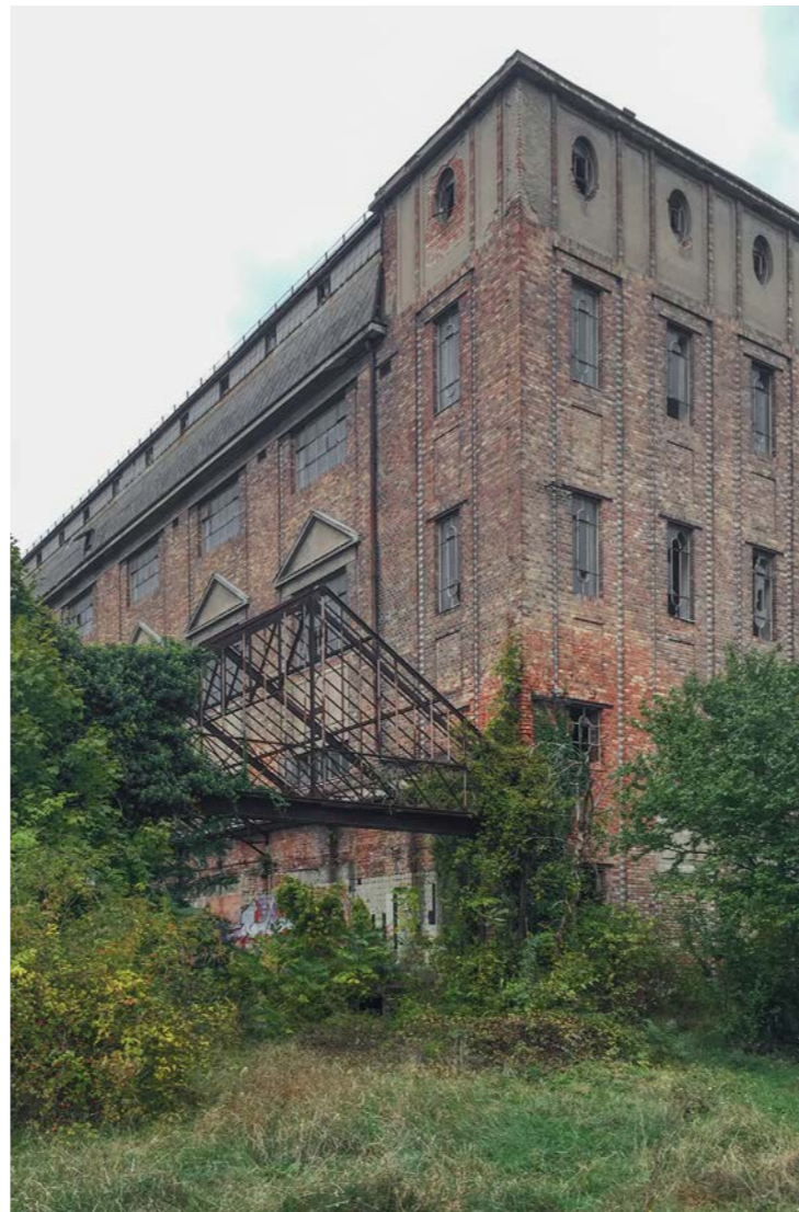
Abb. 6.30 Südostansicht des Sozialgebäudes
