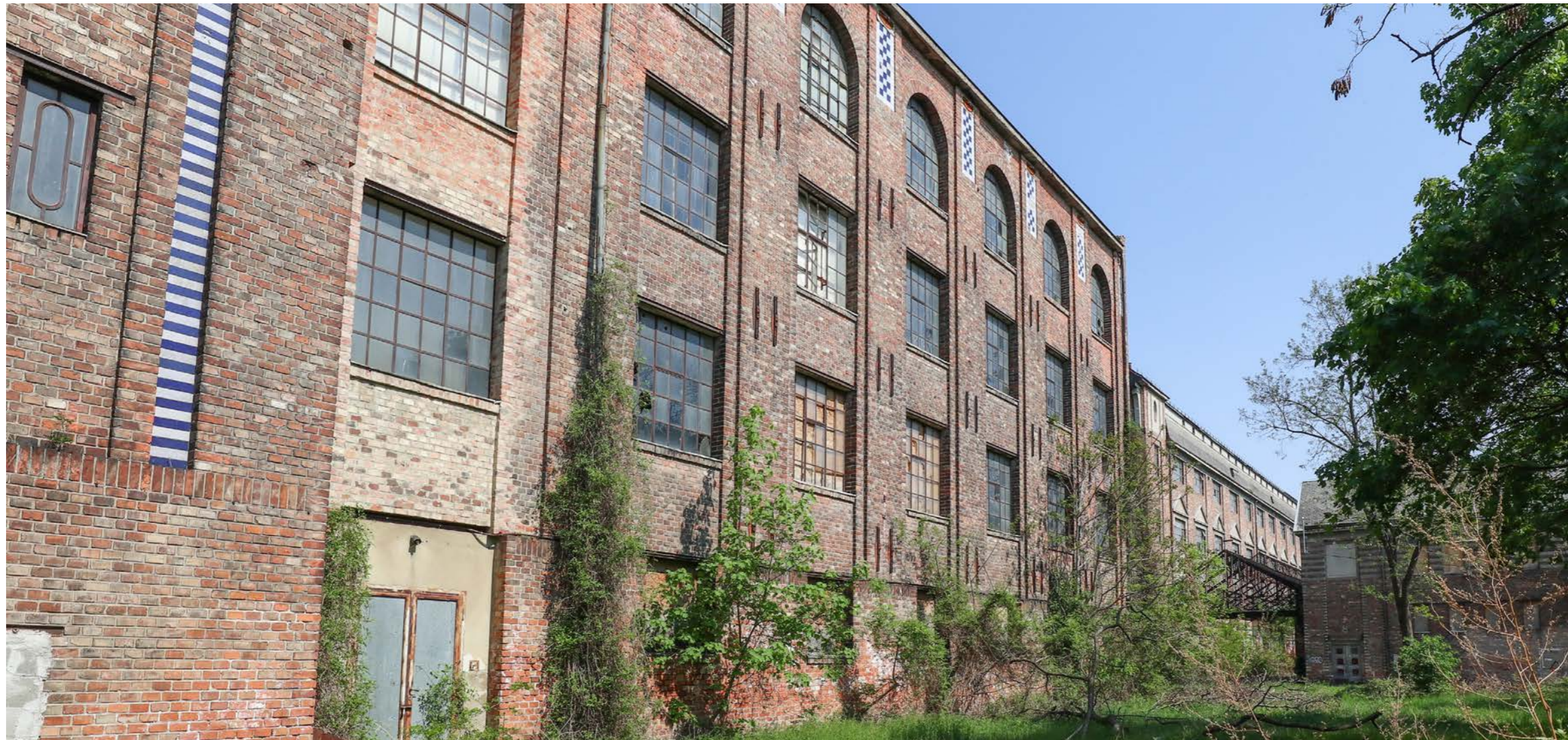
Abb. 6.1 Südansicht des Mehlspeichers
