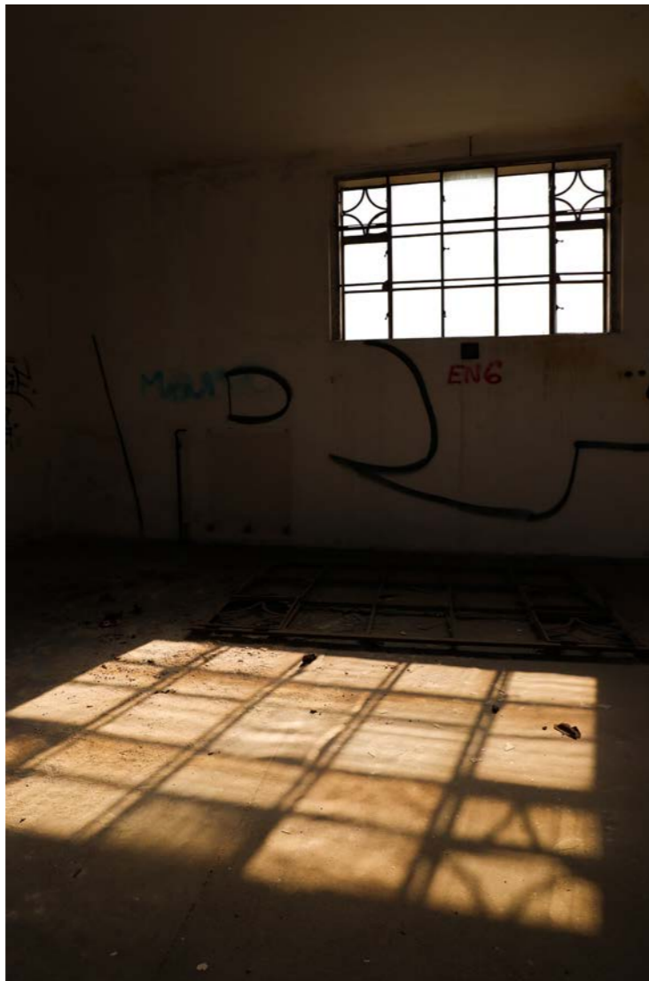
Abb. 6.14 Jugendstil-Fenster im Sozialgebäude
