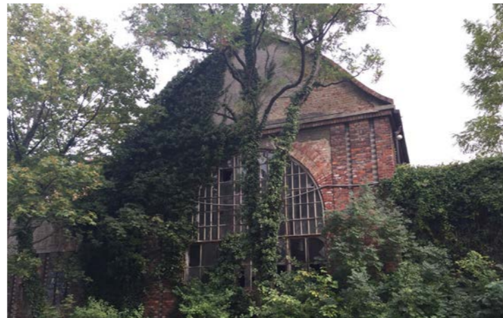
Abb. 6.10 Außenansicht des Rundbogenfensters im Teigverarbeitungstrakt
