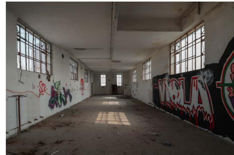
Abb. 6.31 Raum im 3.OG des Sozialgebäudes
