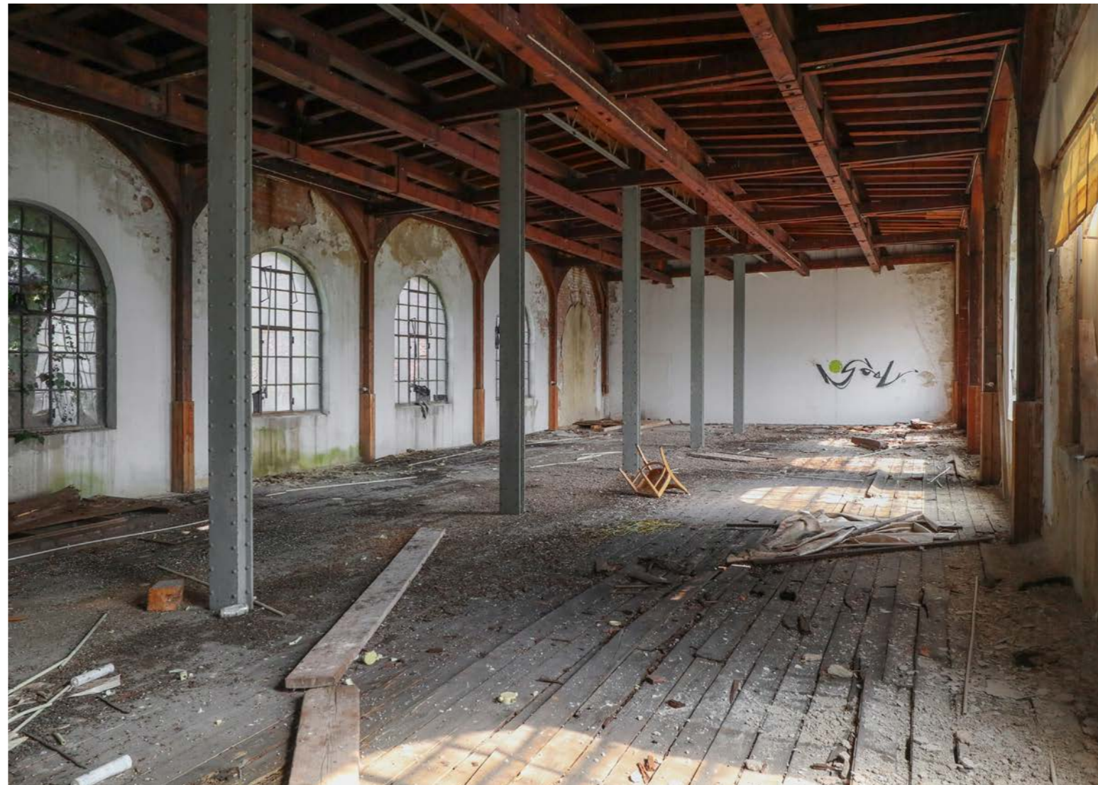
Abb. 1.2 Mehlspeicher 3.OG. Sichtbare Holzkonstruktion der Decke und Betonung der Rundbogenfenster
