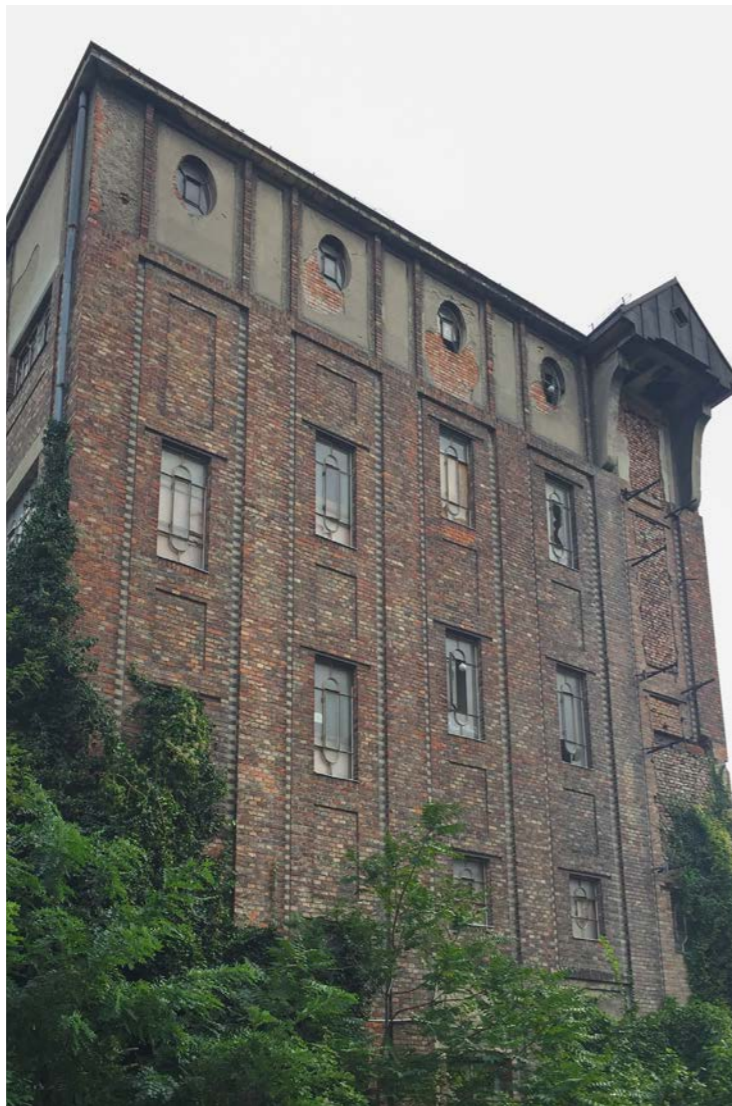
Abb. 6.29 Eckrisalit mit Stiegenhaus des Sozialgebäudes
