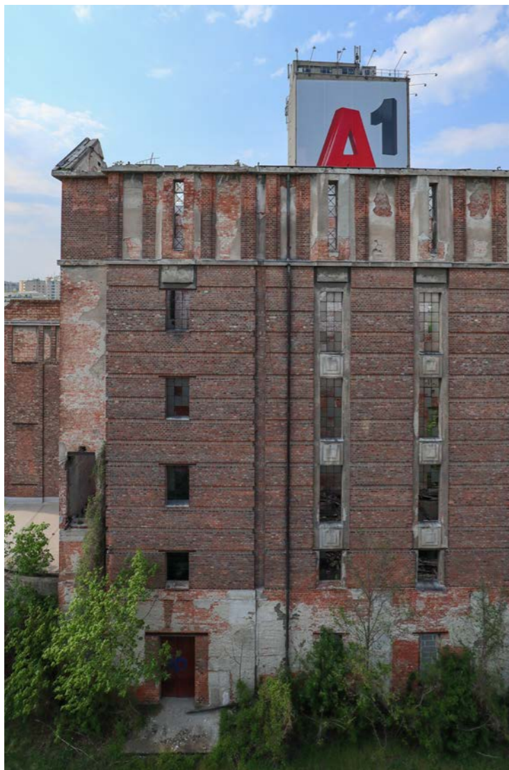
Abb. 6.21 Ansicht des Getreidesilos vom Sozialgebäude aus
