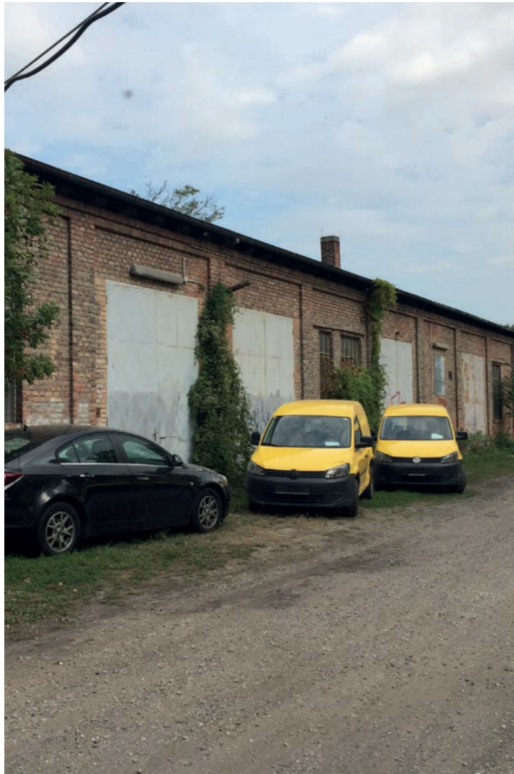
Abb. 7.16 Außenansicht des Werkstattgebäudes
