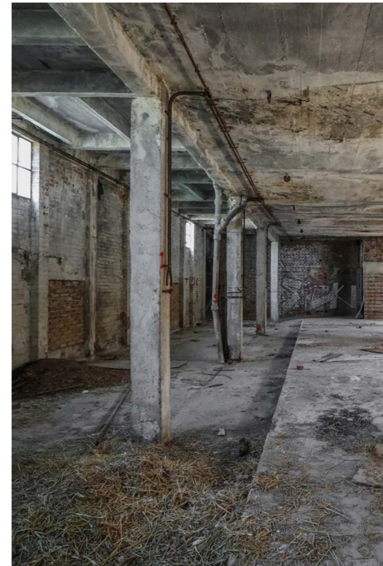
Abb. 6.28 Stahlbetonkonstruktion im Bäckereigebäude
