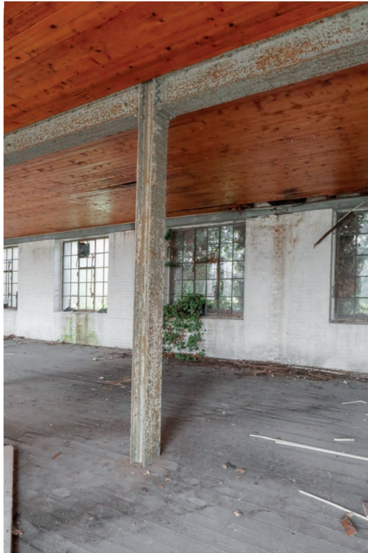
Abb. 7.8 Innenansicht des Mehlspeichers
