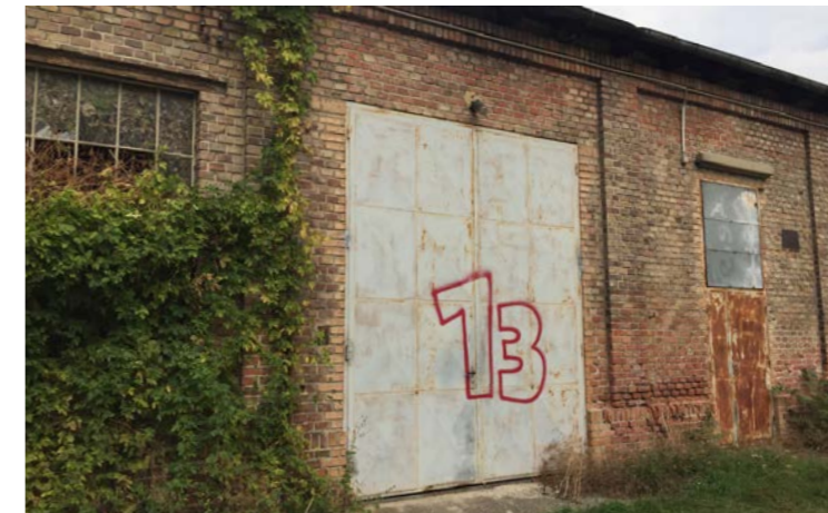
Abb. 6.37 Sichtziegelfassade und Tor der Werkstatt
