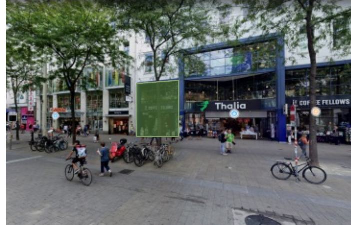
Abb. 89: Straßenansicht Mariahilfer Straße 99
