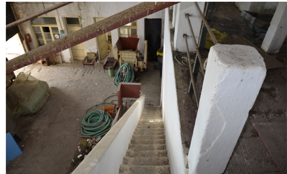
..... Abb.40, Abb.41: Eingangsbereich, Treppe zur obersten Ebene
