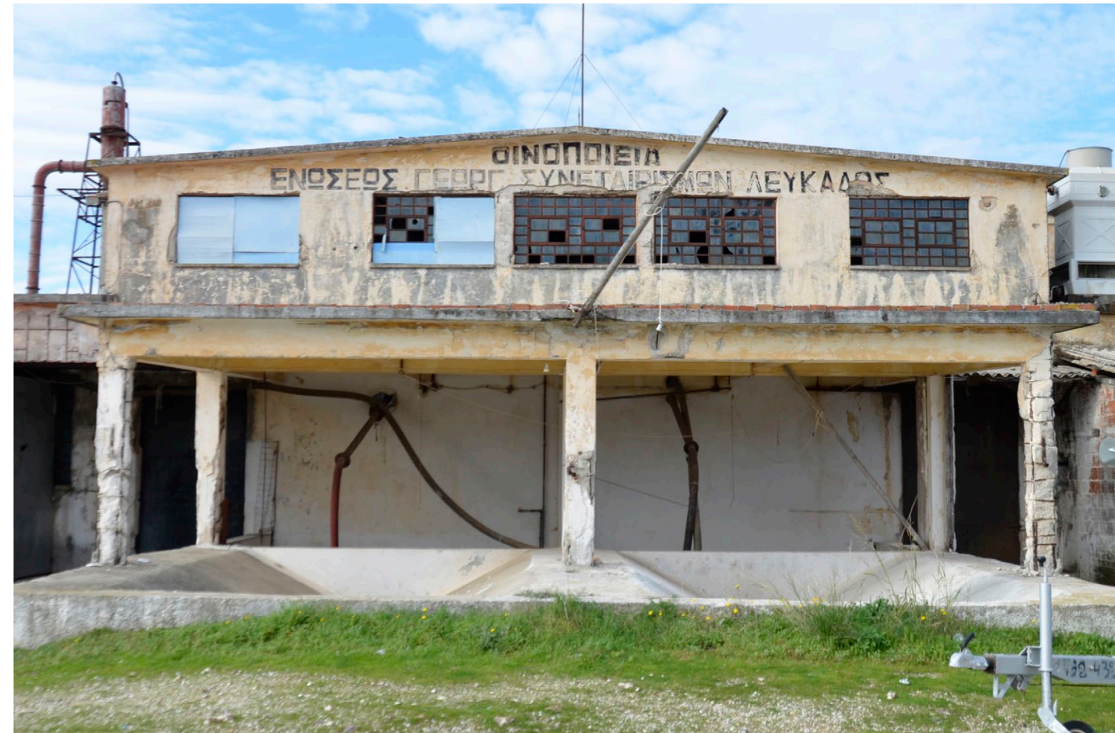
Abb.31: Haupteingänge und Traubenannahmestelle
