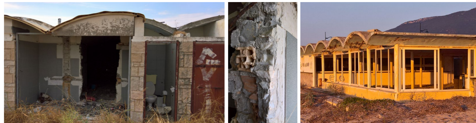
^ Abb.149, Abb.150: Zubauten und Wanddurchbruch, Abb.151: neuer Gastraumbereich
