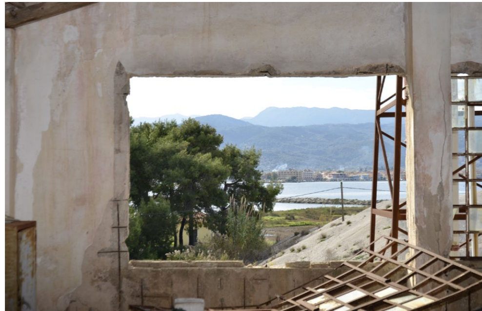
..... Abb.42: Empore über den Betontanks Abb.43: Blick von der Empore in Richtung Lagune und Stadt
