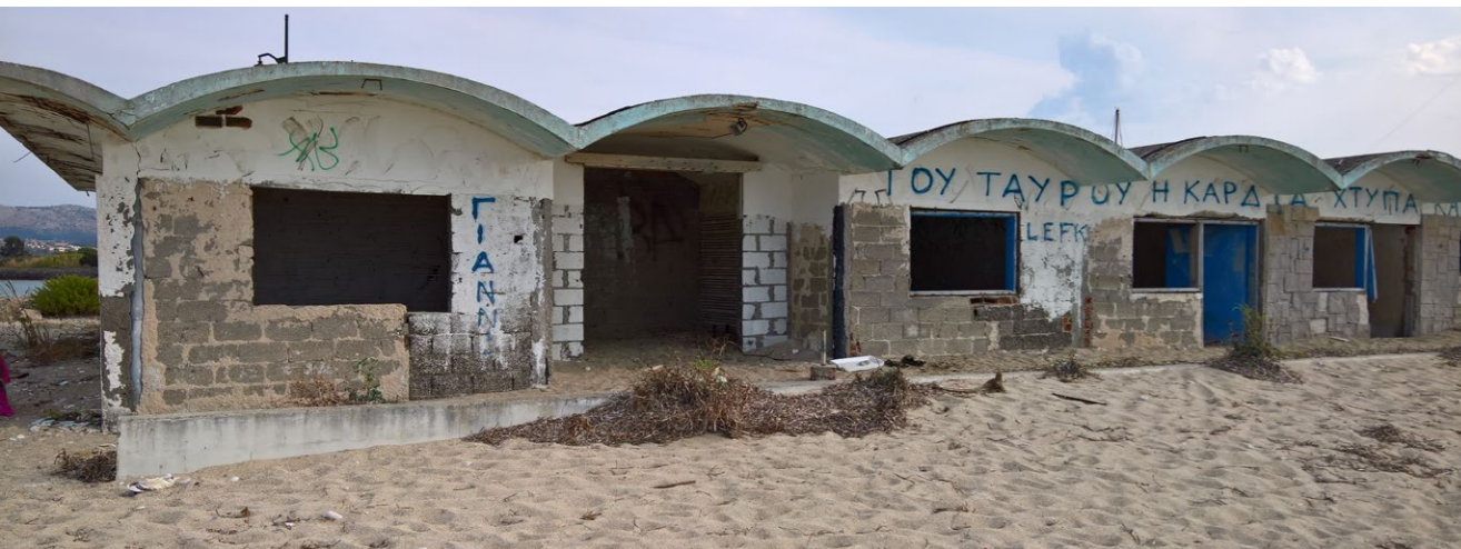
Abb.138: Strandseitige, zugebaute Fassade
