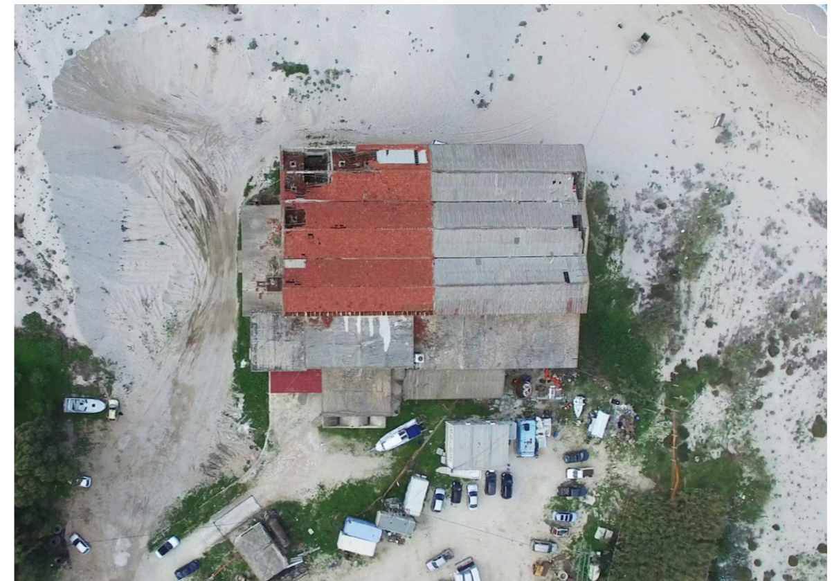
Abb.53: Dachkonstruktion, Betontankbereich Abb.54: Dachkonstruktion, neue Halle Abb.55: Aufsicht Weinkelerei
