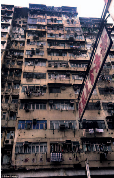
[26] Wohngebäude in Hongkong: Hinter fast jedem der Fensterbänder finden sich KIT Wohnformen.
