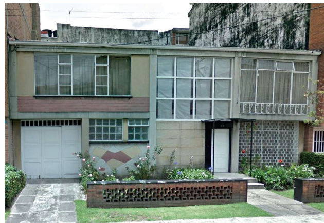
[83] Einfamilienhaus aus den 60er Jahren
