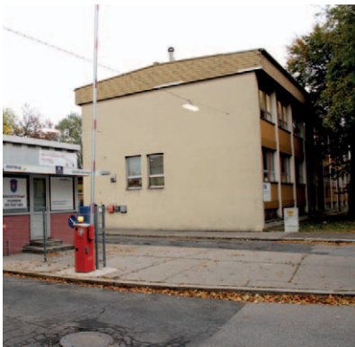
[24] Außenansicht des Notquartiers Nordwestbahn, 2017
