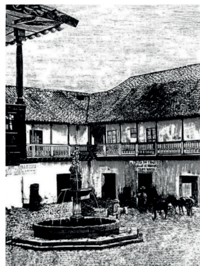
[98] Ansicht Innenhof eines kolonialen Wohnhaus: Der zweite Stock ist über einen Laubengang erschossen, 19. Jhd
