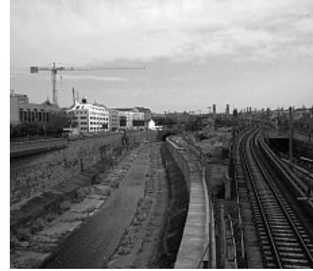
Abb. 87: Ertel (2017): Wienfluss und U-Bahngleise
