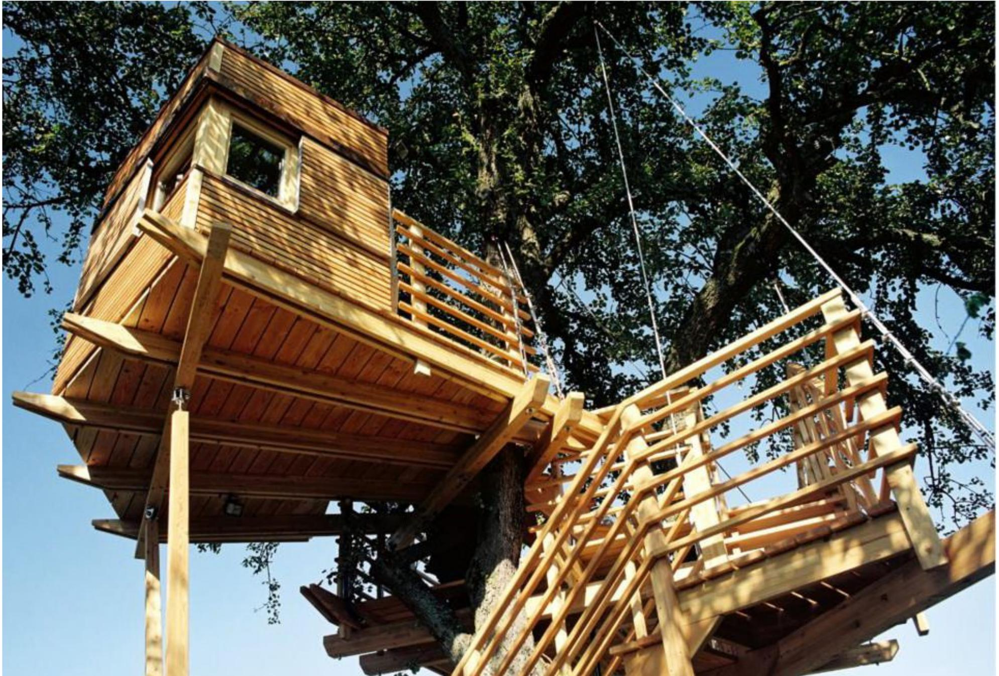
Abb.4.82 Baumhaus „Am Ackerle“- Aufgehängte Konstruktion
