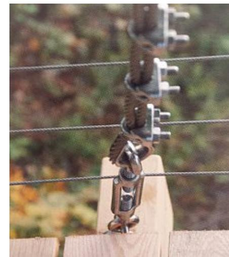
Abb.4.74 Seilbefestigung am Träger des Baumhauses
