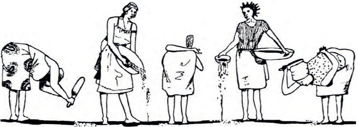
Abb.: 35 - Schlagen und Stampfen von Lehmfußböden von Frauen in Nordghana
