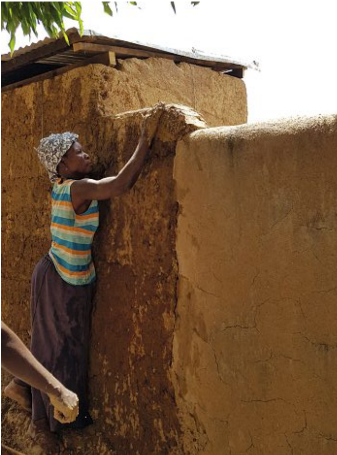
Abb.: 33 - Frau verputzt Wände mit traditionellem Lehmputz
