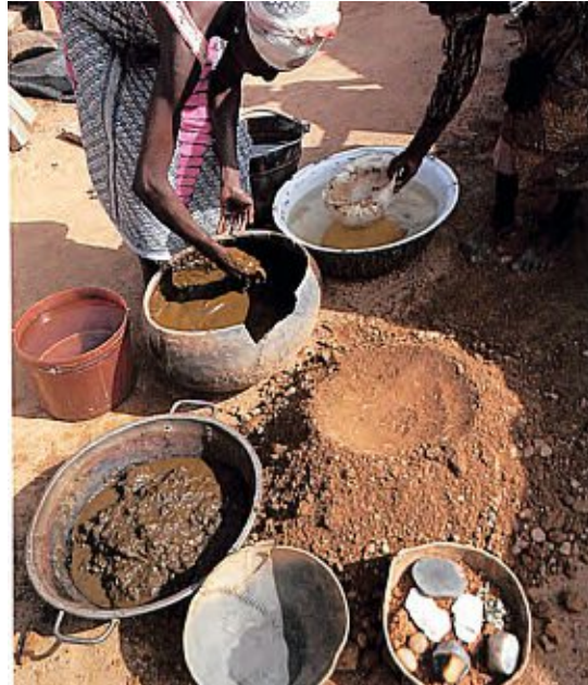
Abb.: 39 - Kuhdung und Urin dienen nicht nur als Bindemittel für den Lehmputz sondern auch für die Malfarben.
