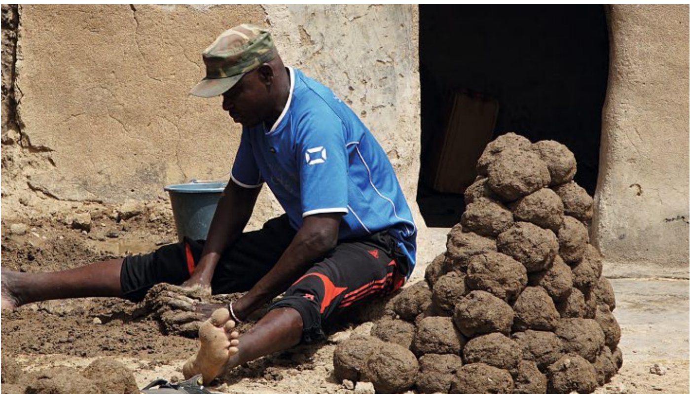
Abb.: 55 - Kneten der Lehmkuugeln für traditionellen Lehmhausbau
