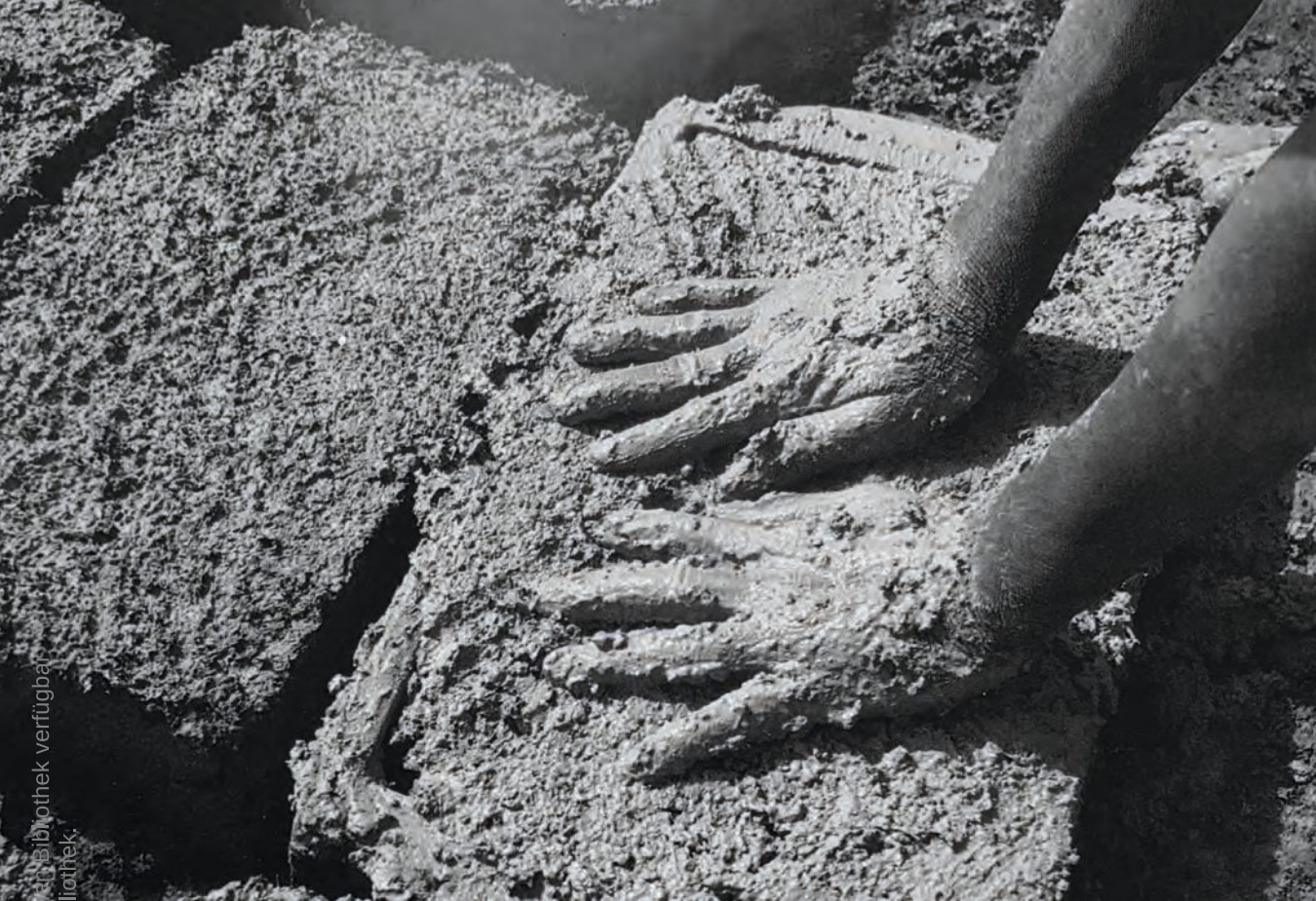
Abb. 56 - Lehm wird mit Händen und Füßen bearbeitet. Das Erfahren des Baustoffes ist ein wichtiger Bestandteil der traditionellen Bauweise.
