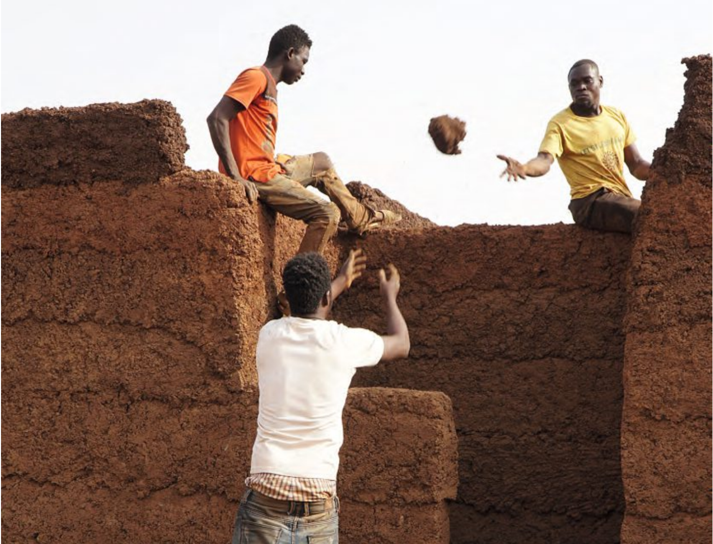
Abb.: 54 - Herstellung einer traditionellen Lehmwand in der Puddle-Mud Technik
