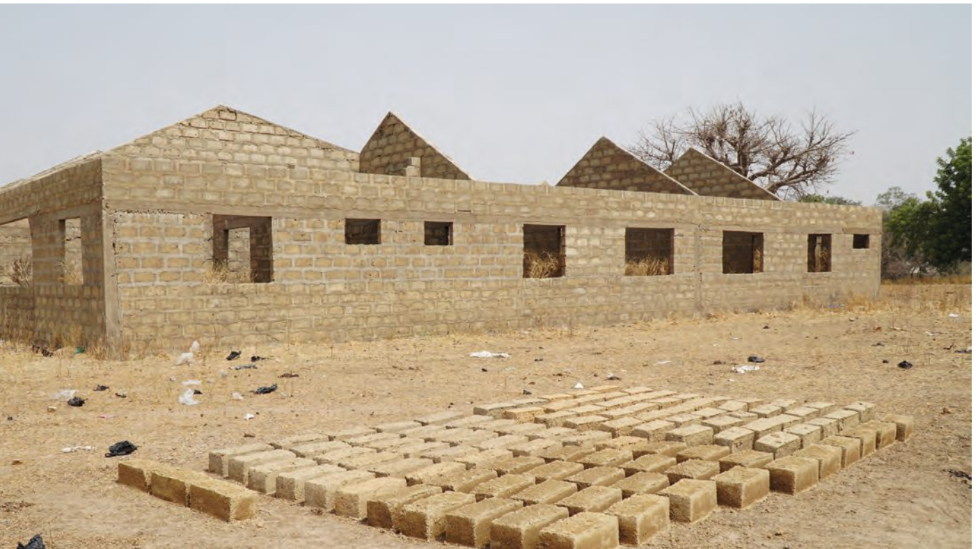
Abb.: 53 - Lehmziegel trocknen in der Sonne vor der Baustelle
