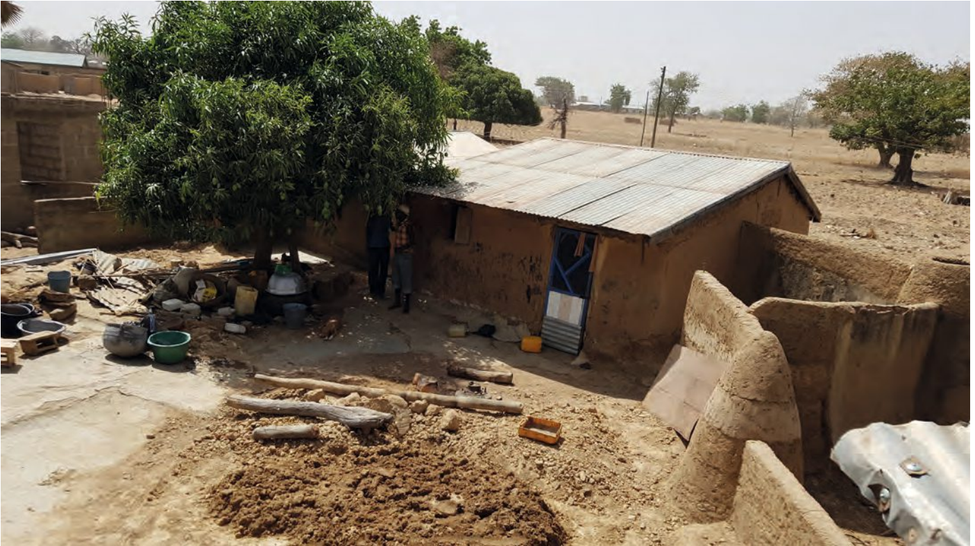
Abb.: 52 - Sanierungsarbeiten eines Gehöfts, Lehm wird im Innenhof verarbeitet, Bolgatanga
