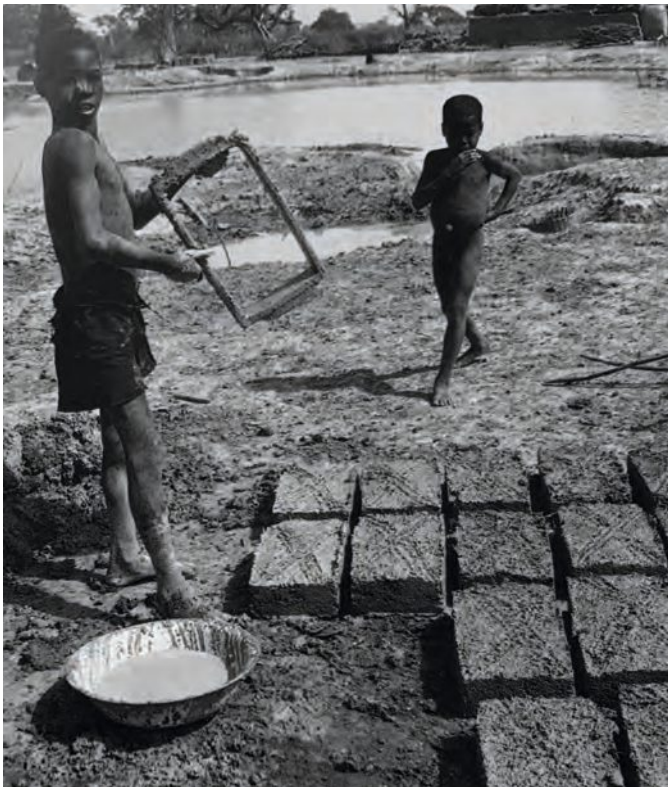
Abb.: 31 - Herstellung sonnengetrockneter Lehmziegel
