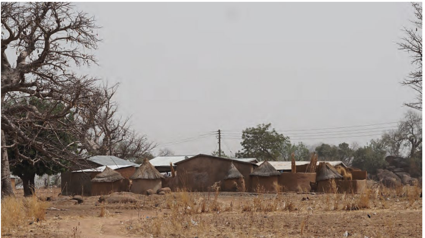
Abb.: 27 - Gehöft an neue Bauweise angepasst, rechteckige Bauten mit Wellblechdach kombiniert mit traditionellen Rundbauten mit Strohdach, umschlossen von traditioneller Rundmauer
