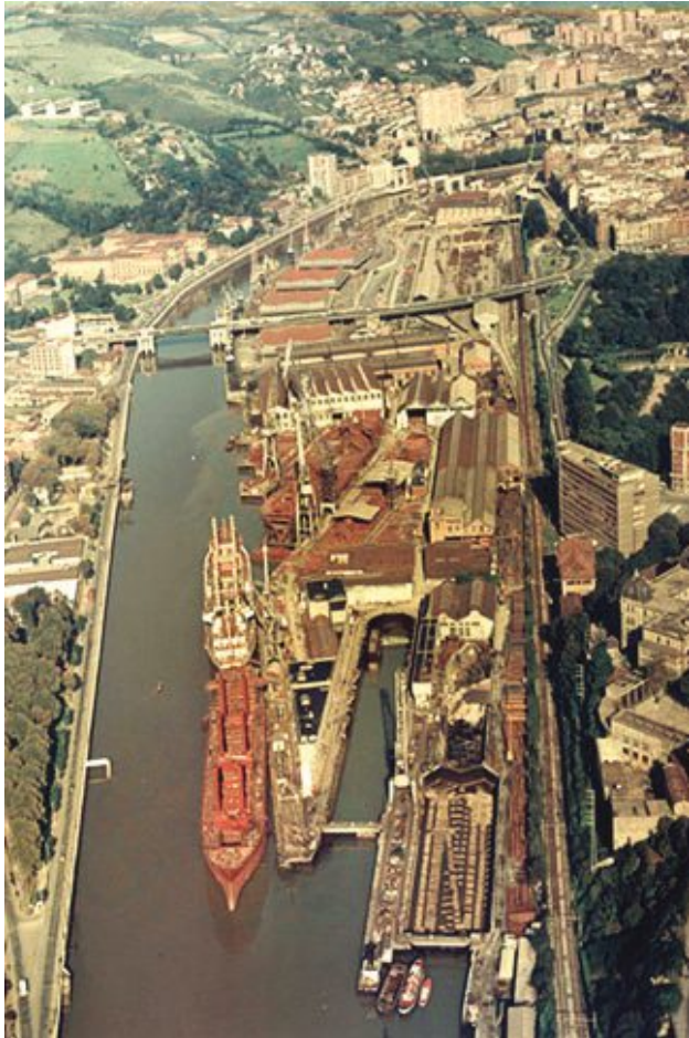
Fig. 25. Bilbao port before
