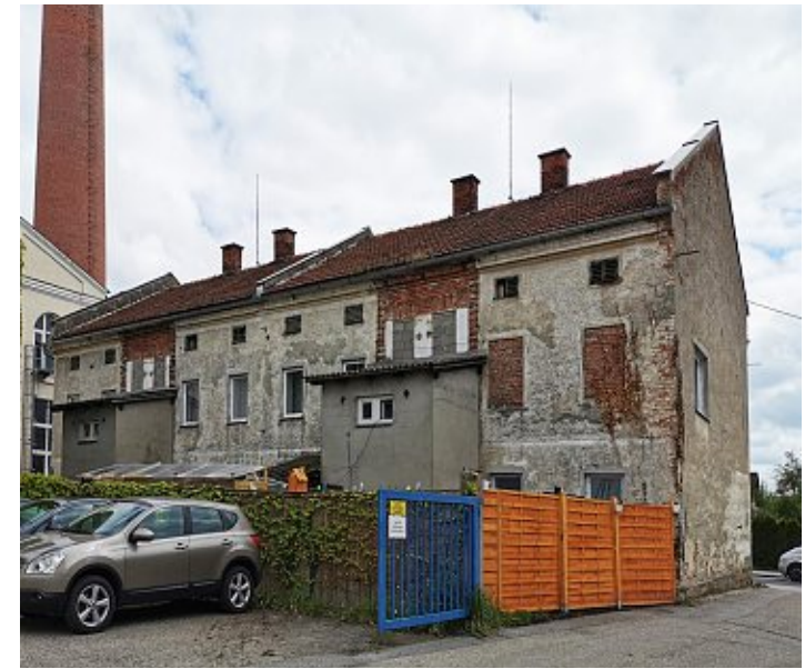
Abb.39: Hofseite des Wohnhauses
