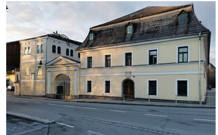
Abb.32: Eingangsfassade des Lirkhauses.
