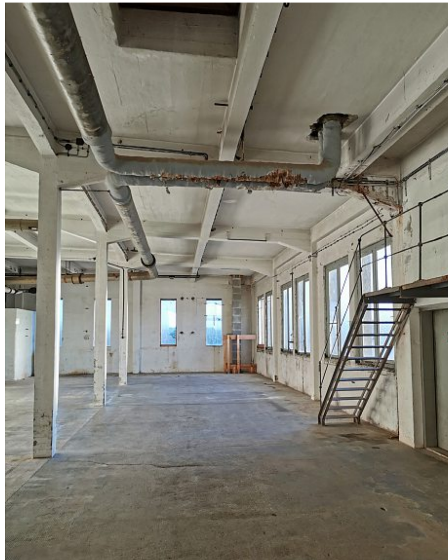
Abb.43: Im 4. Obergeschoss der Zurichte I
