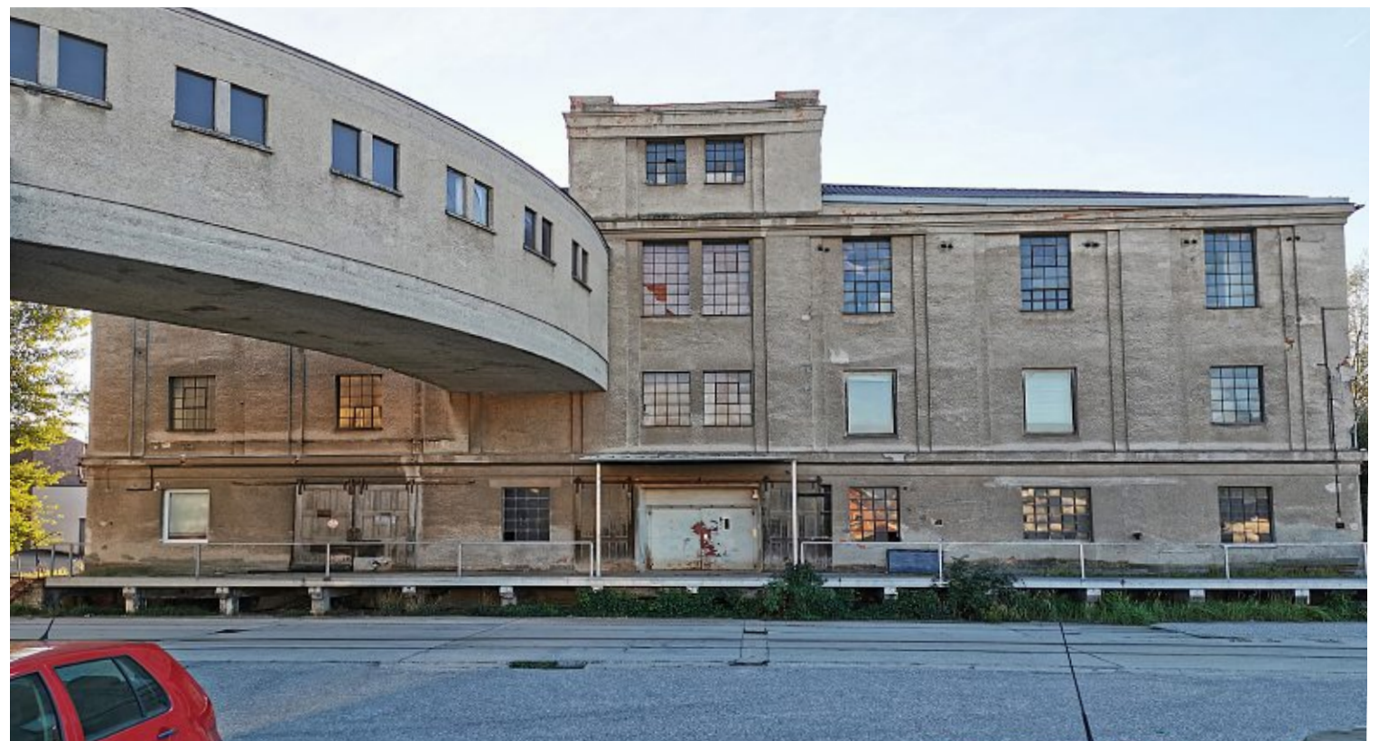
Abb.46: Ostfassade und Verbindungsgang zur Zurichte III
