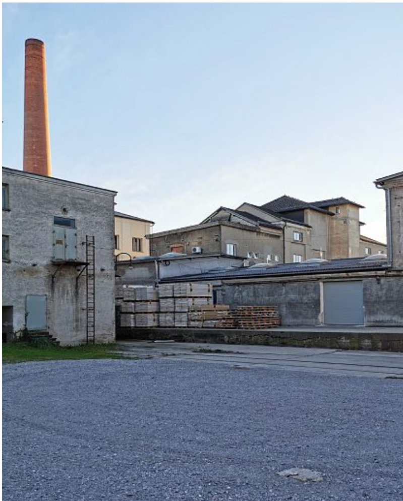
Abb.55: Ostfassade der Grubenhäuser – Extraktion
