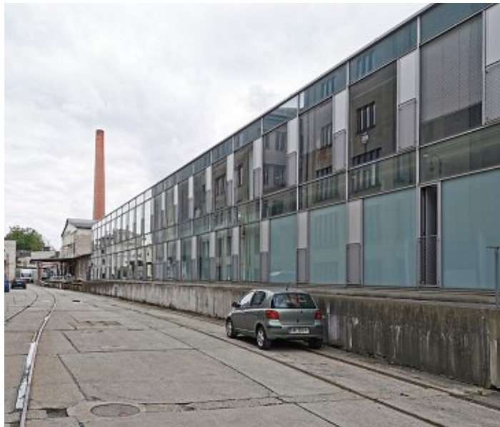
Abb.49: Ostfassade des Forschungs- und Entwicklungszentrum
