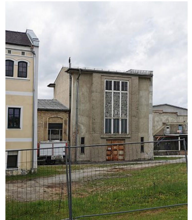
Abb.38: Etwa sechs Meter hohes Fenster am Turbinenhaus.
