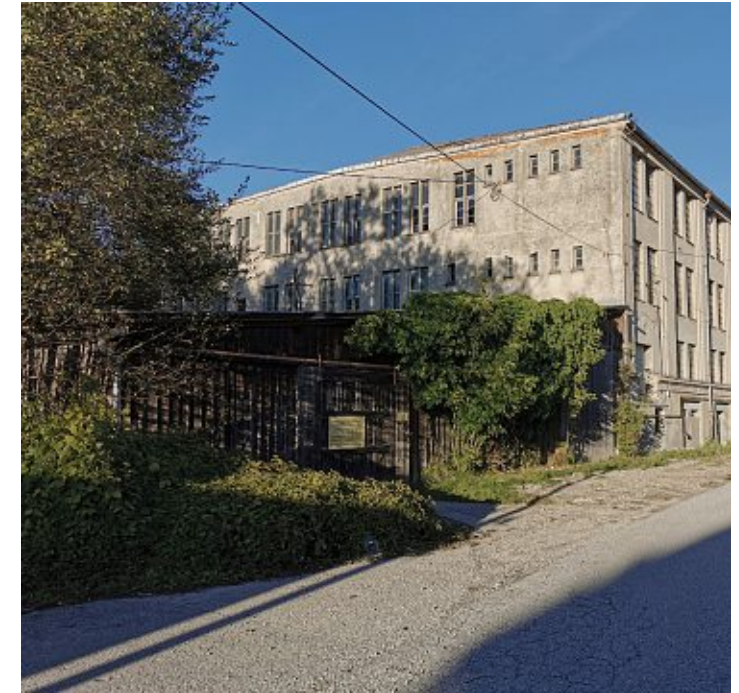
Abb.45: Westfassade und Häuteschuppen.
