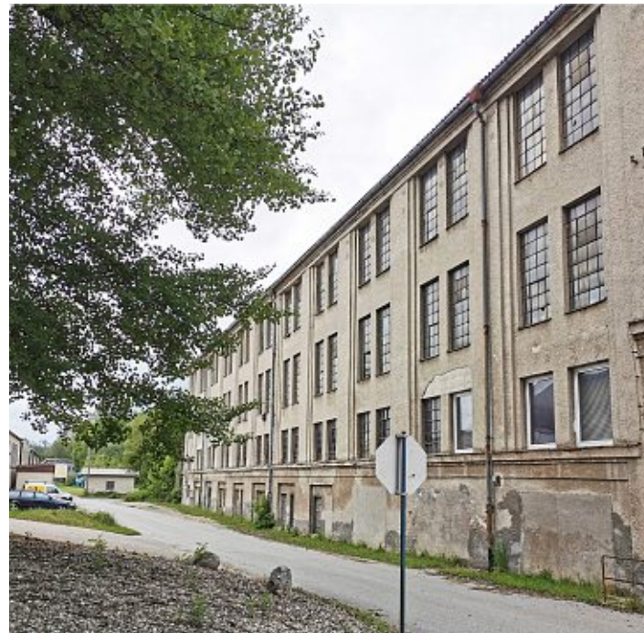
Abb.44: Südfassade der Zurichte II
