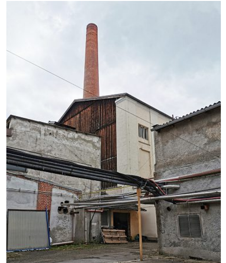
Abb.37: Blick aus Norden auf das Kesselhaus. Im Hintergrund der Schlot.
