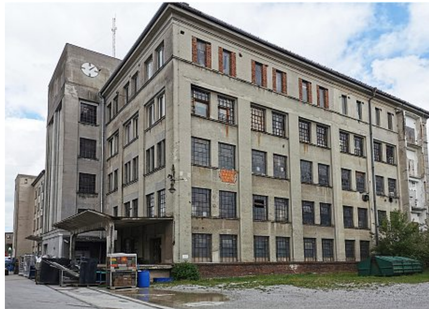
Abb.42: Fassade und Anschluss zum alten Trockengebäude.
