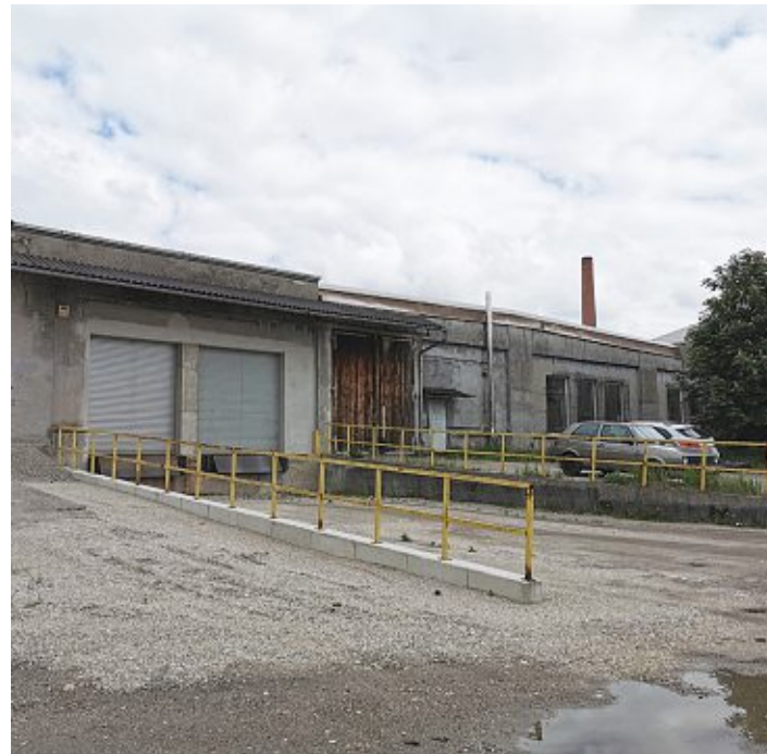
Abb.51: LKW Anlieferungsrampe der Wasserwerkstatt
