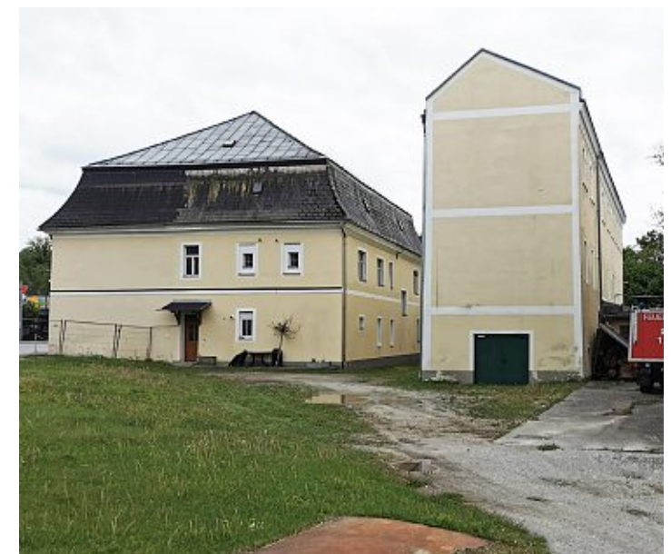
Abb.33: An der Norfassade wird die Symmetrie gebrochen, da an der linken Seite das Manufakturegebäude und das alte Trockenhaus anschlossen waren.
