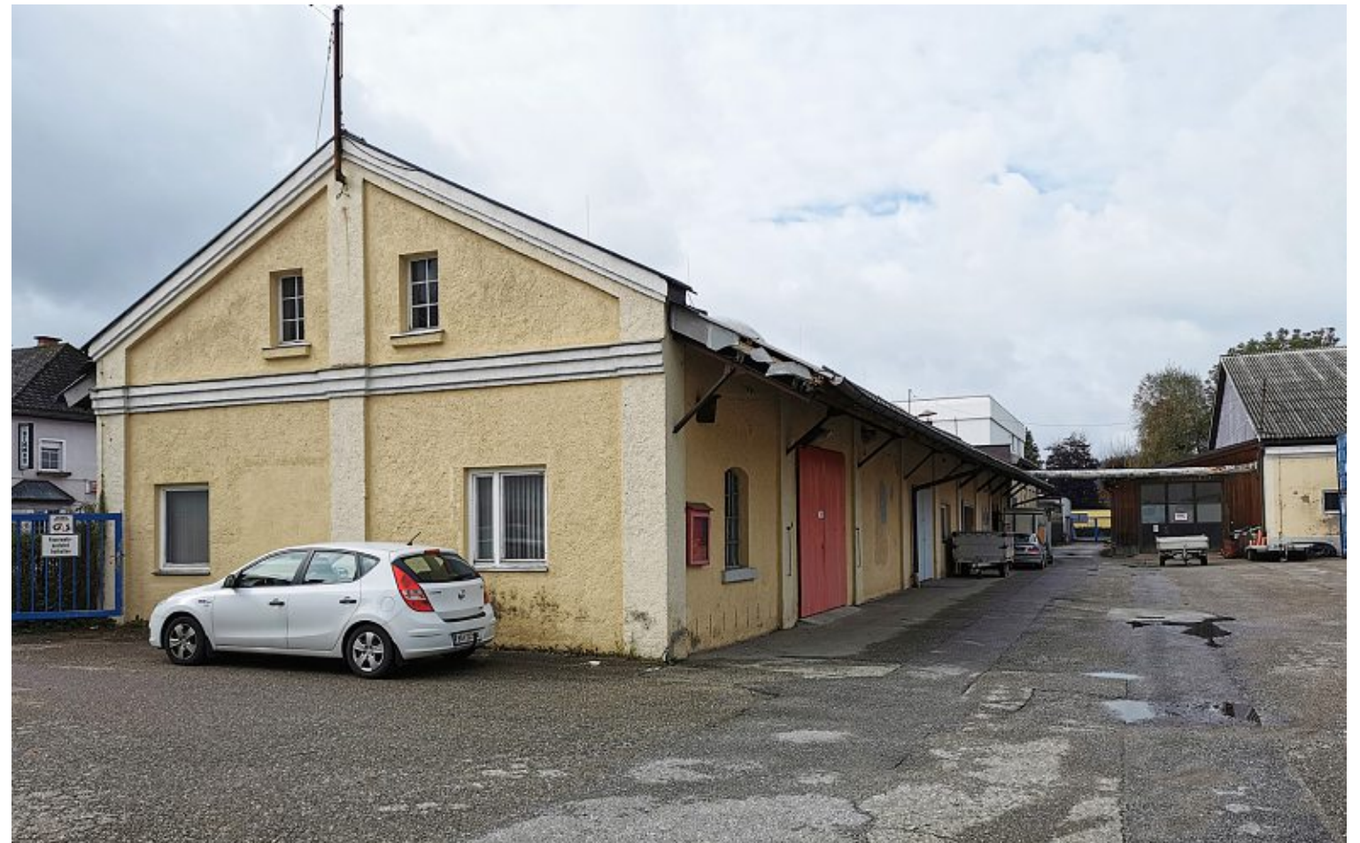
Abb.41: Blick in den Werkstättenhof
