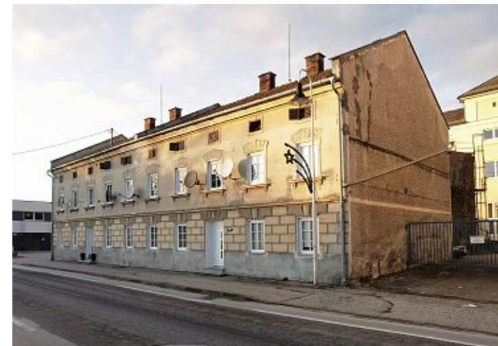
Abb.40: Straßenseite des Wohnhauses
