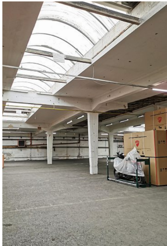
Abb.53: Innenraum der Wasserwerkstatt mit Oberlicht.
