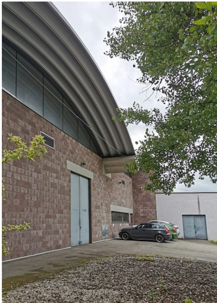
Abb.50: Nordfassade des Forschungs- und Entwicklungszentrum
