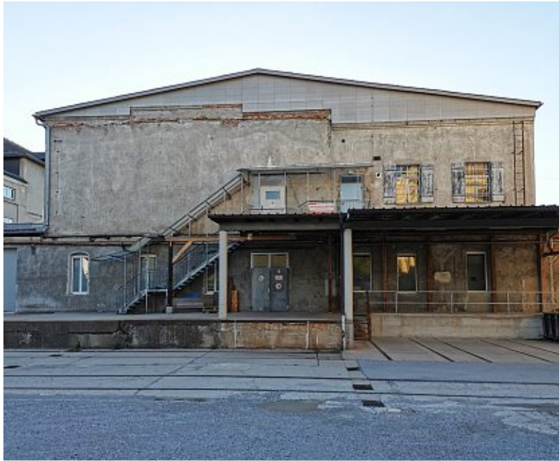
Abb.54: Ostfassade der Grubenhäuser – Laboratorium
