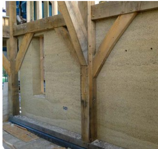
Abb.39. Fachwerk mit Hanfkalk ausgefacht
