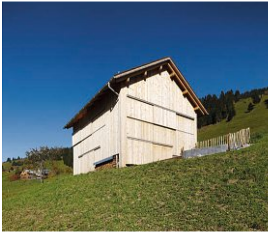
Ferienhaus Marul, architektur terminal hackl & klammer, 2012
