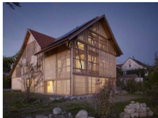
Abb.35. Holzfassade Scheune Dingenhard
