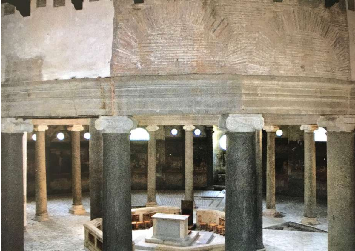
Abb. 25: Detailfoto des Architraven
