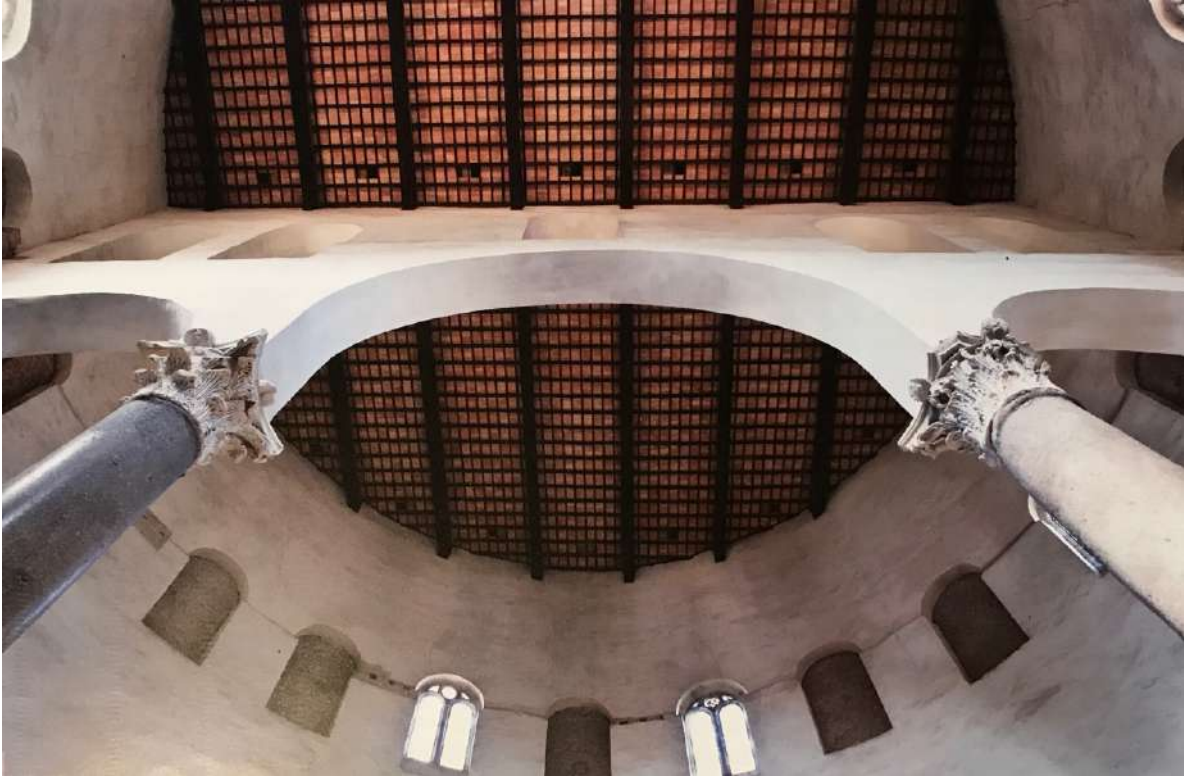
Abb. 30: Arkadenbogen (Serlio-Motiv) zur statischen Unterstützung, unter Papst Innozenz II. (1130-1143)
