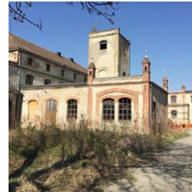
Abb. 37: Mitteltrakt mit Wasser- turm
