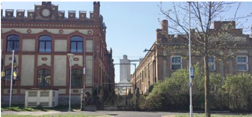
Abb. 54: Blick auf die Silos entlang des Gleisanschlusses
