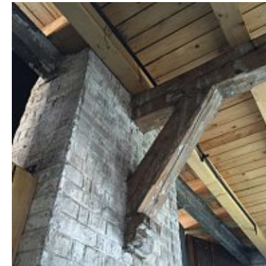
Abb. 48: Detail Dachkonstruktion Südtrakt
