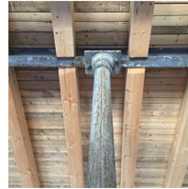
Abb. 45: Detail Dachkonstruktion Südtrakt
