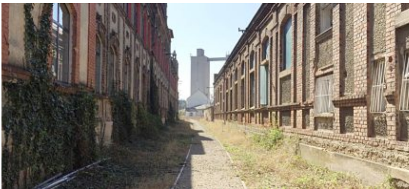
Abb. 55: Blick auf die Silos entlang des Gleisanschlusses
