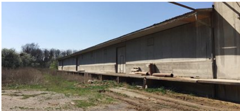
Abb. 72: Lagergebäude neben dem Südturm
