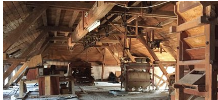
Abb. 49: Dachraum des Mitteltrakts
