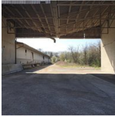
Abb. 62: Blick zwischen den Silos hindurch in Richtung Westen
