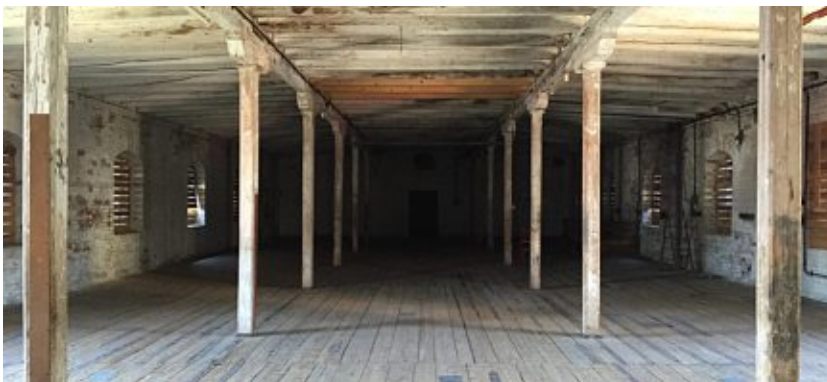
Abb. 42: Obergeschoss des Südtrakts
