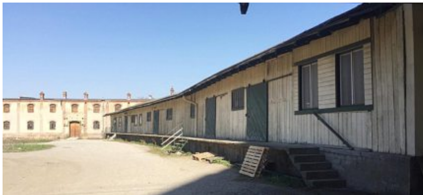
Abb. 70: Lagergebäude neben dem Verwaltungs- gebäude
