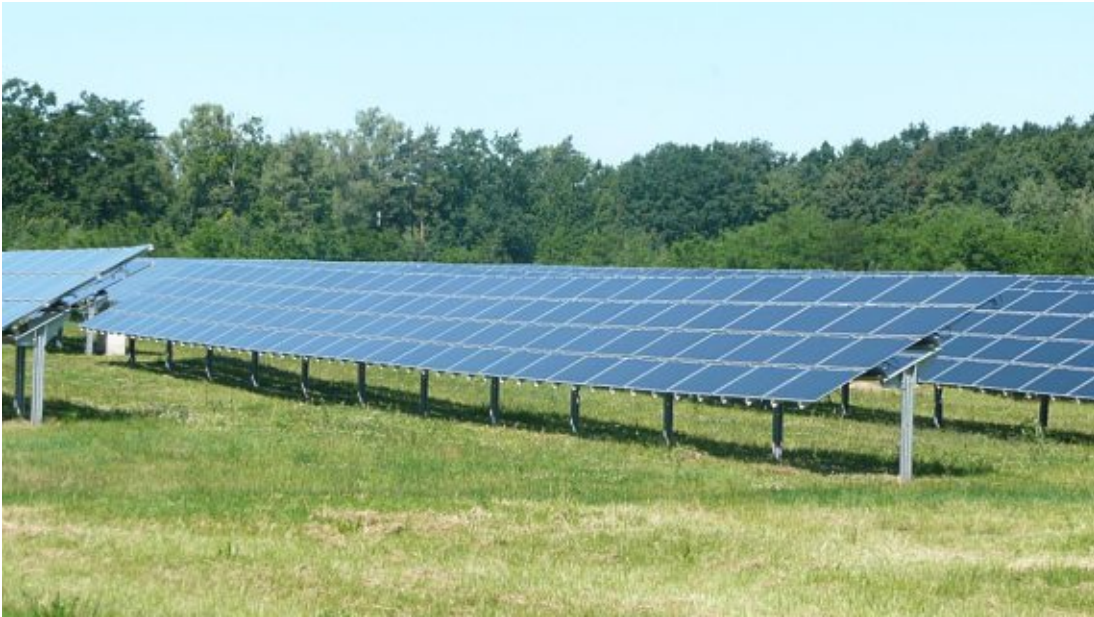
Abbildung 8: Starre PV-FFA in Süd-Ausrichtung mit 4-reihigen Modultischen
