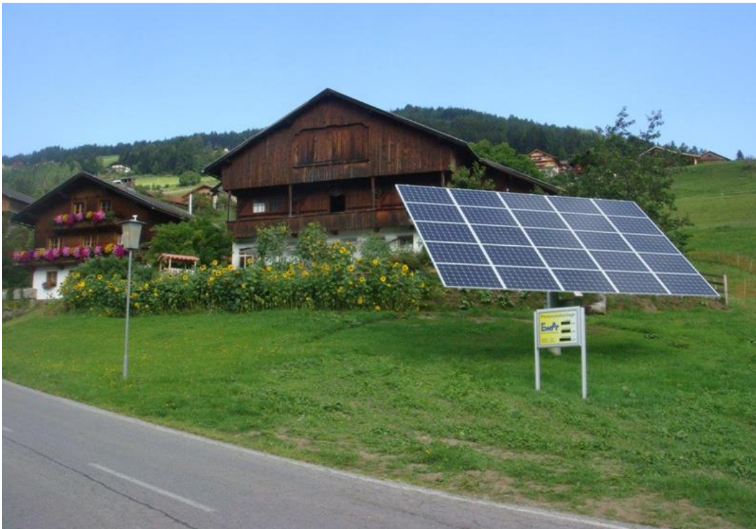
Abbildung 13: Größenklasse „sehr kleine Anlage“, 2-achsig nachgeführt, Assling, Tirol
