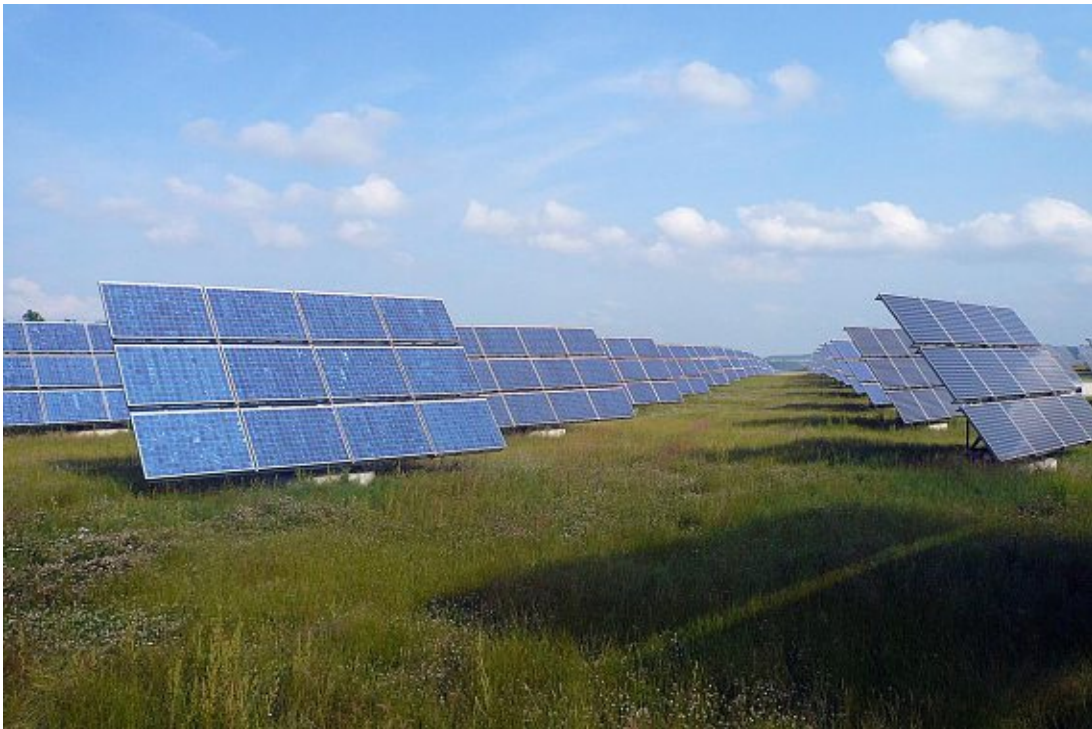
Abbildung 10: Zweiachsig nachgeführte Anlage am Solarfeld Erlasee
