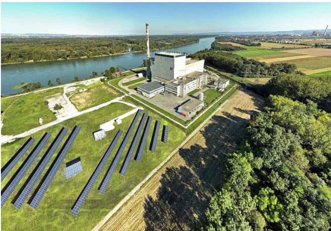
Abbildung 14: Größenklasse „kleine Anlage“, AKW Zwentendorf, Niederösterreich (165 kWp)
