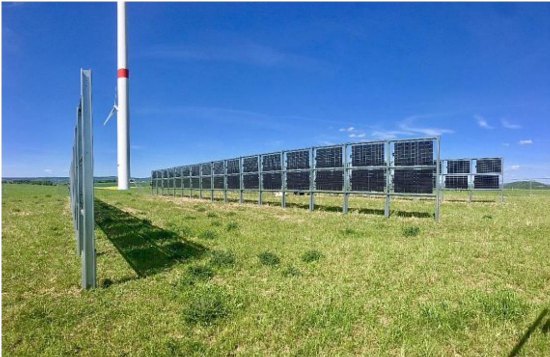
Abbildung 11: Bifaziale PV-Pilotanlage in Losheim am See (Saarland)
