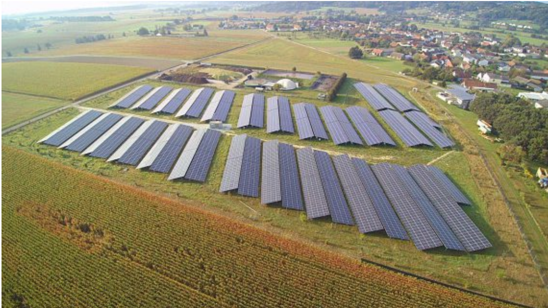
Abbildung 9: Starre PV-FFA in Ost-West-Ausrichtung
