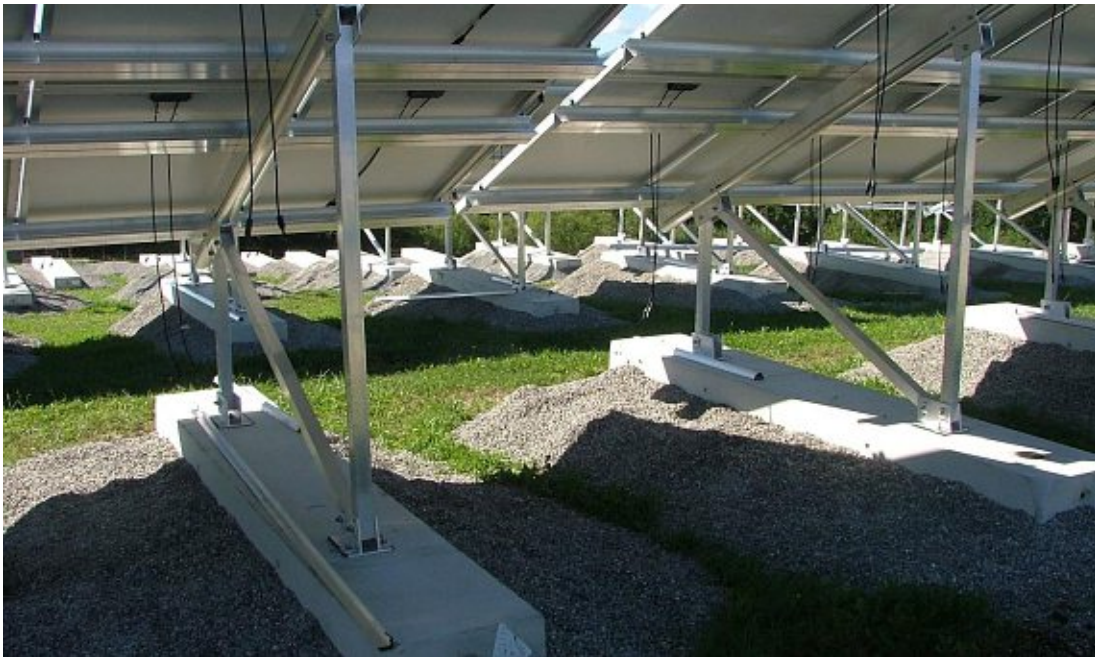
Abbildung 24: Betonstreifenfundamente
