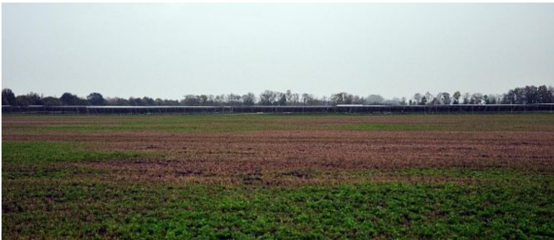
Abbildung 26: PV-Anlage in flachem Relief (Distanz ca. 190 m)
