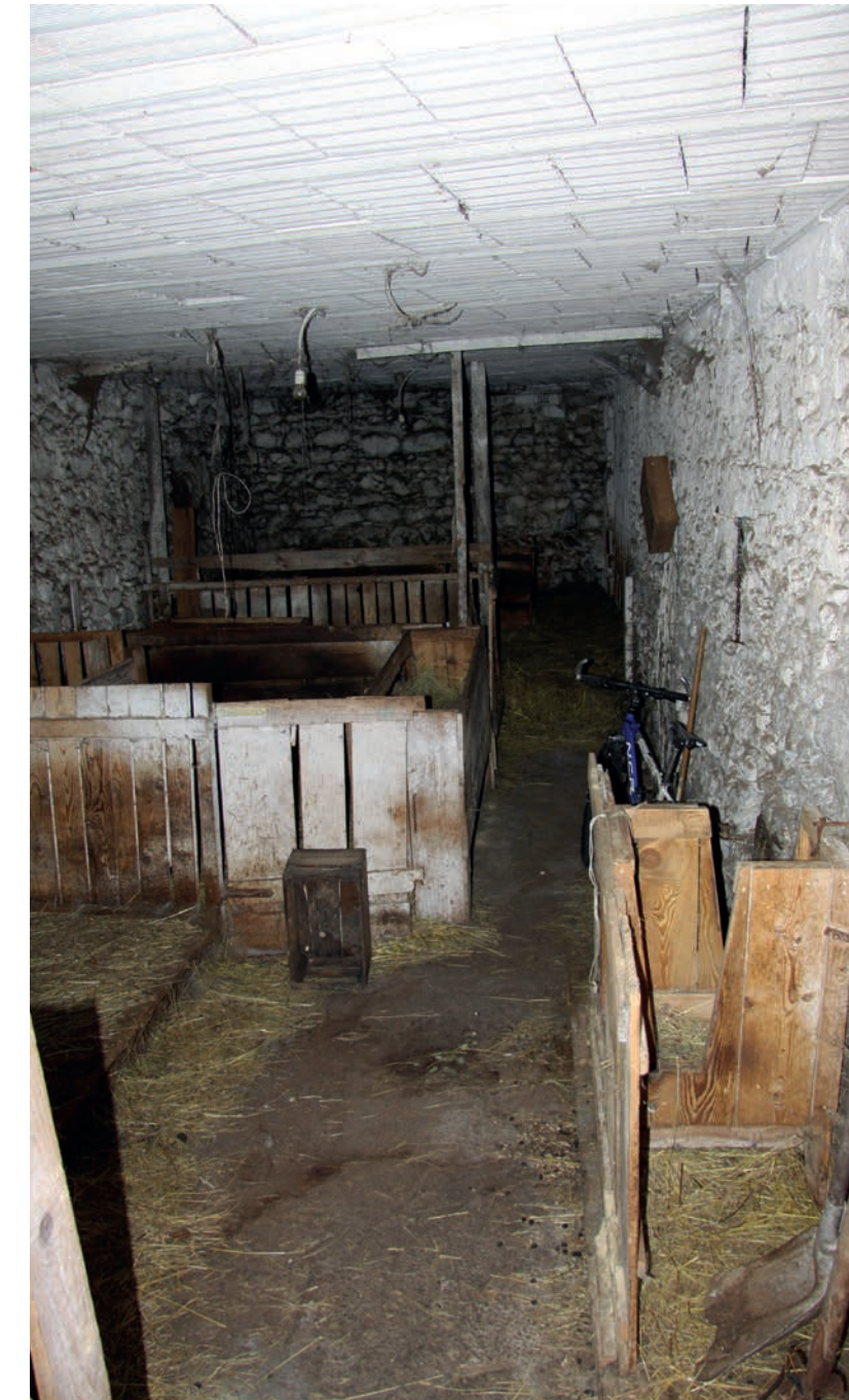
ABB. 296 ▲ Mit Kalkmilch gestrichenes Steinmauerwerk (Ostwand).
