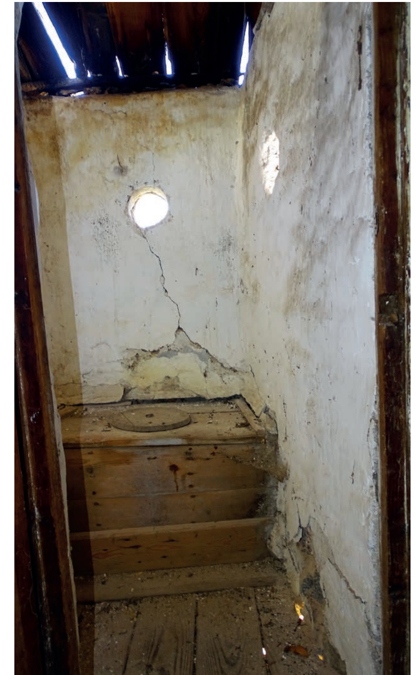
ABB. 276 ▲ Trockentoilette im 1. Ober- geschoss.
