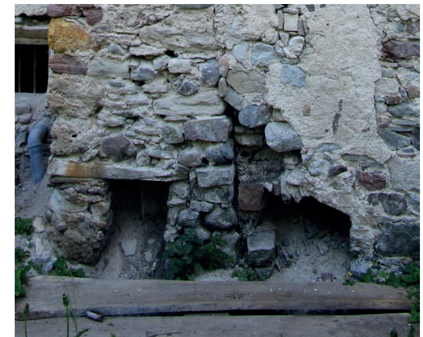
ABB. 247 ◀ Eingangstür im Freien zur Trockentoilette.
