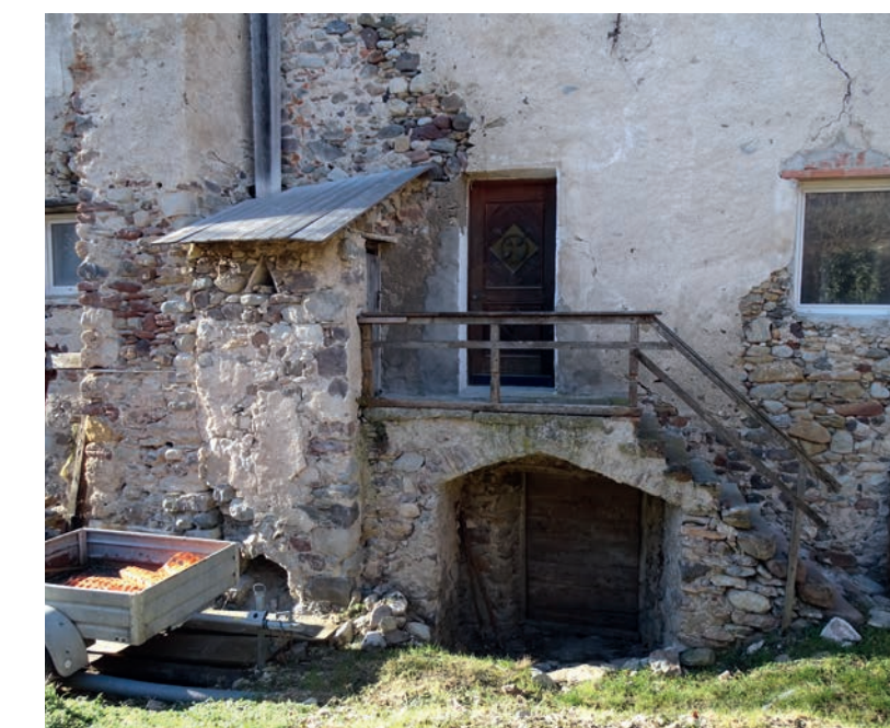
ABB. 147 ◀ Angebaute Trockentoiletten an der Ostfassade.
