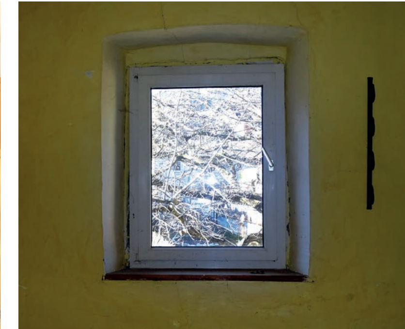
ABB. 118 ◀◀ Nachträglich eingebaute Trennwand des Badezimmers im Erdgeschoss.
