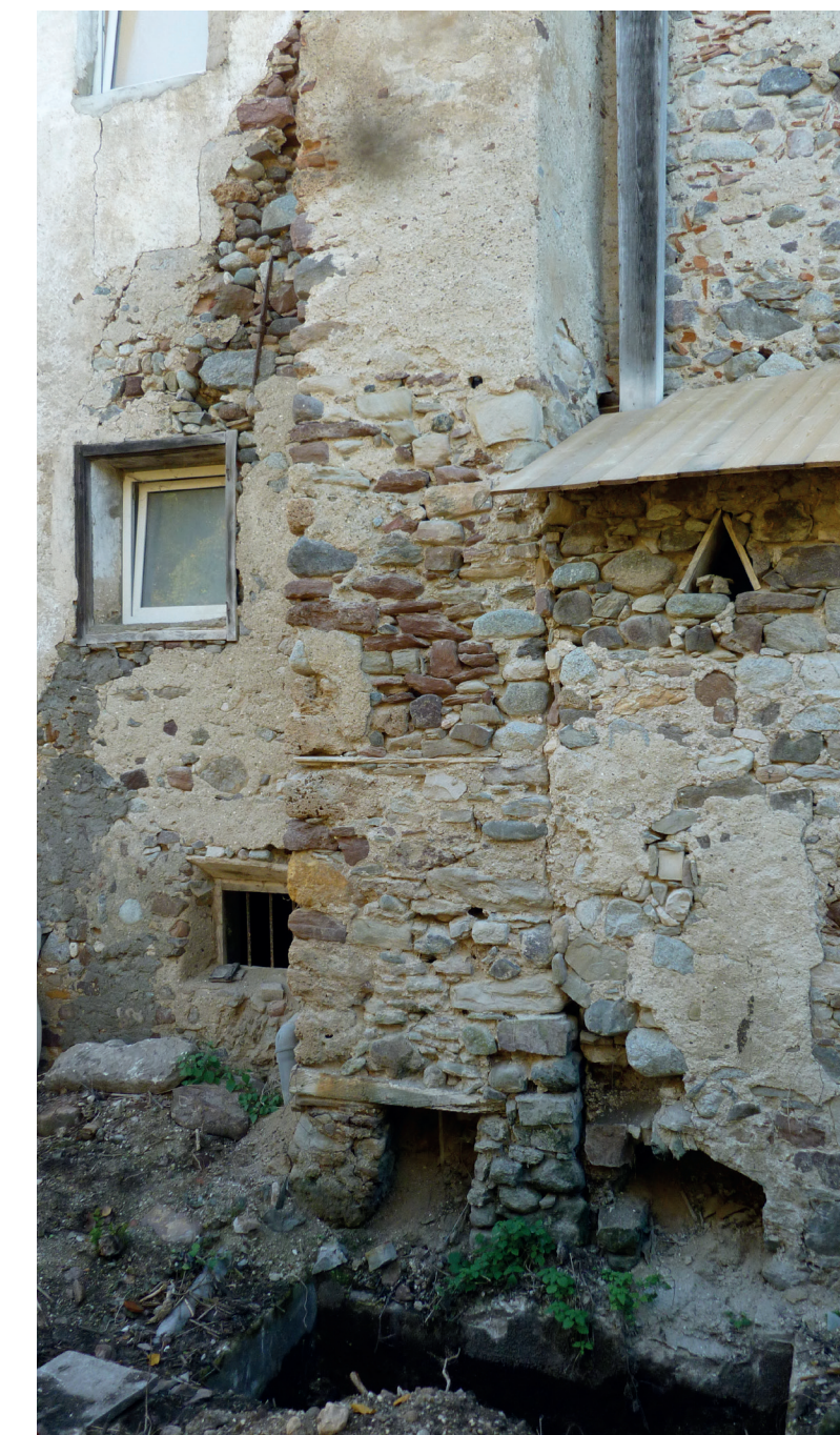
ABB. 179 ◀◀ Angebaute Trockentoiletten an der Nordfassade.
