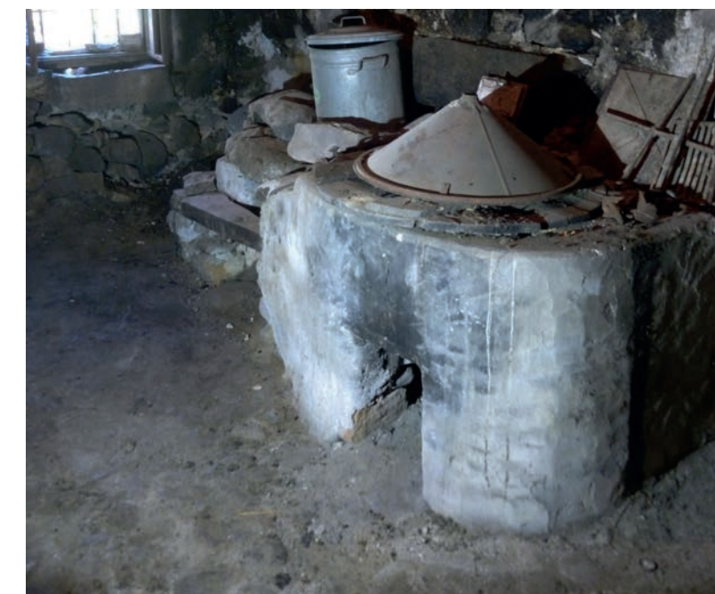
ABB. 225 ◀◀ Schüttstein unterhalb des zweiflügeligen Holzfensters.
