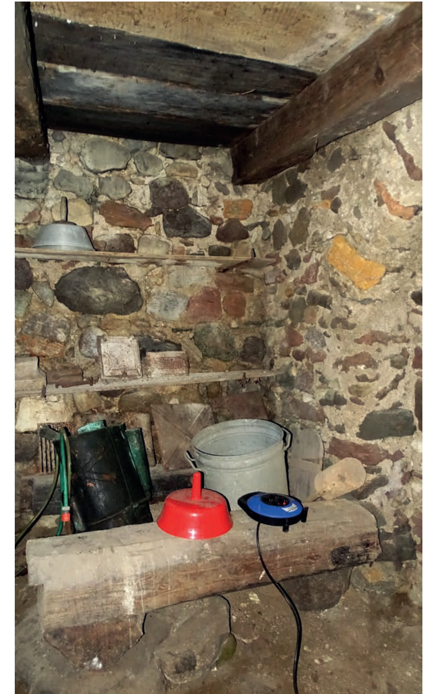
ABB. 196 ▲ Südwestliches Raumeck des Kellers KG.03.
