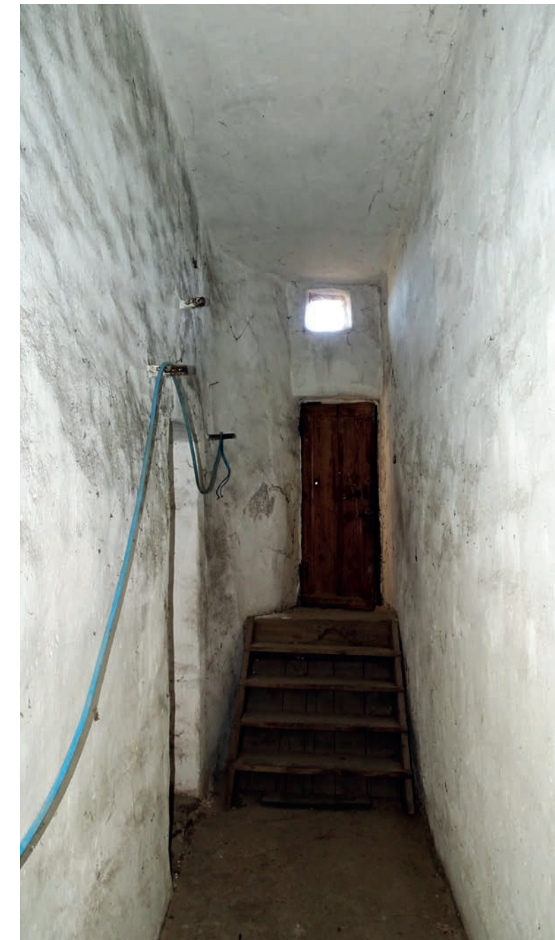
ABB. 274 ◀◀ Haugang zur Trockentoilette, Blick nach Westen.
