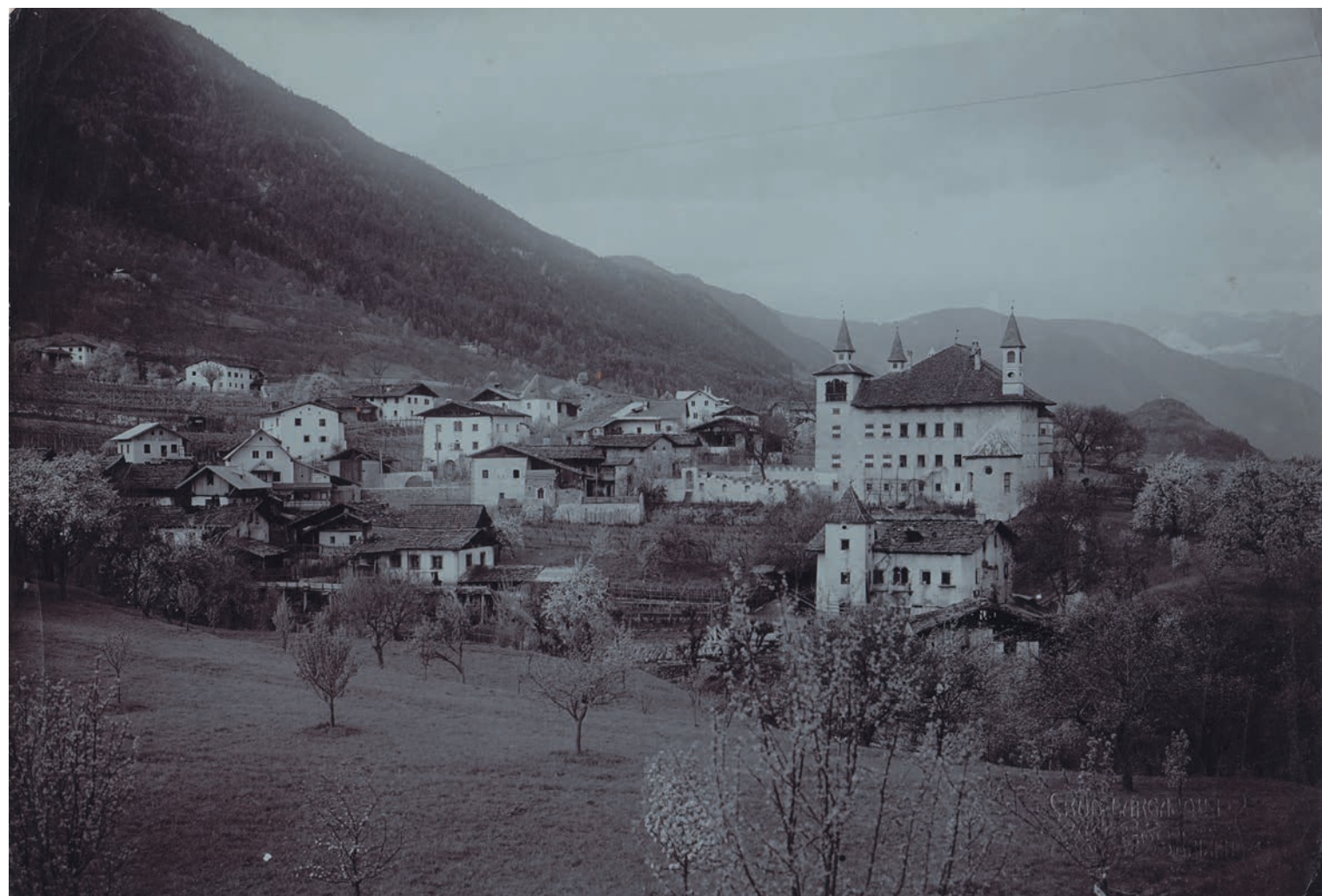
► ABB. 126 Dorf Prissian im Jahre 1914. Rechts im Bild das Wohn- haus des Unterbäcks.
