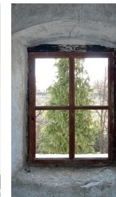
ABB. 161 ◀◀◀ Zweiflügeliges Holzfenster mit horizontaler Sprossenteilung.
