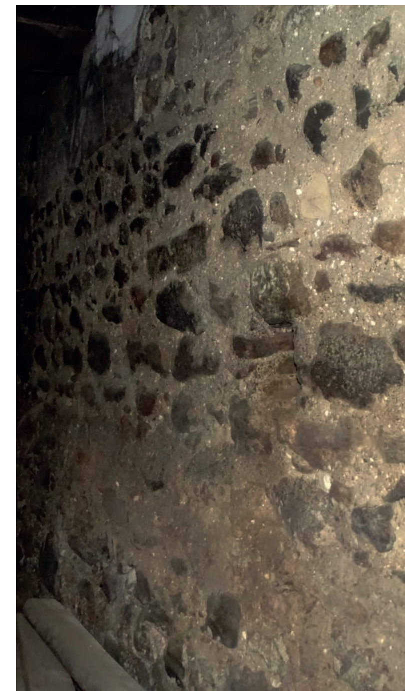
ABB. 102 ▲ Ehemaliger abgeschnittener Deckenbalken an der Nordwand des Kernbaus.
