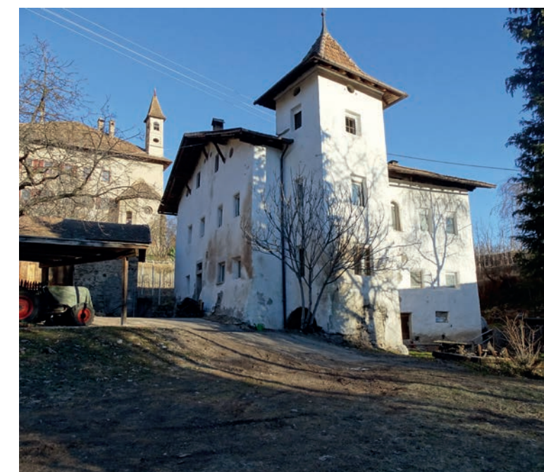
ABB. 139 ▲ Südfassade des Wohngebäudes.
