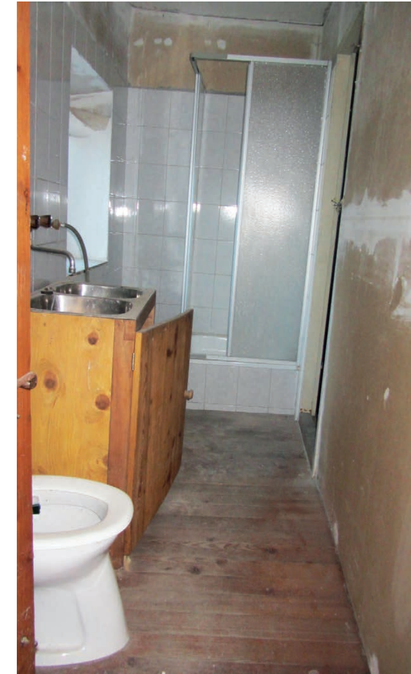
ABB. 233 ◀ Nachträglich eingebautes Badezimmer mit Wänden aus Gipskartonplatten.
