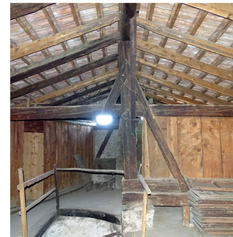
ABB. 168 ◀◀ Treppenaufgang in den Dachboden.
