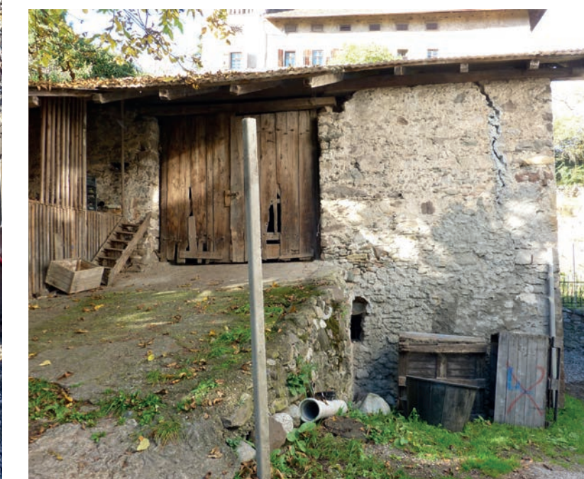
ABB. 181 ◀ Ostansicht des Wirtschaftsgebäudes.
