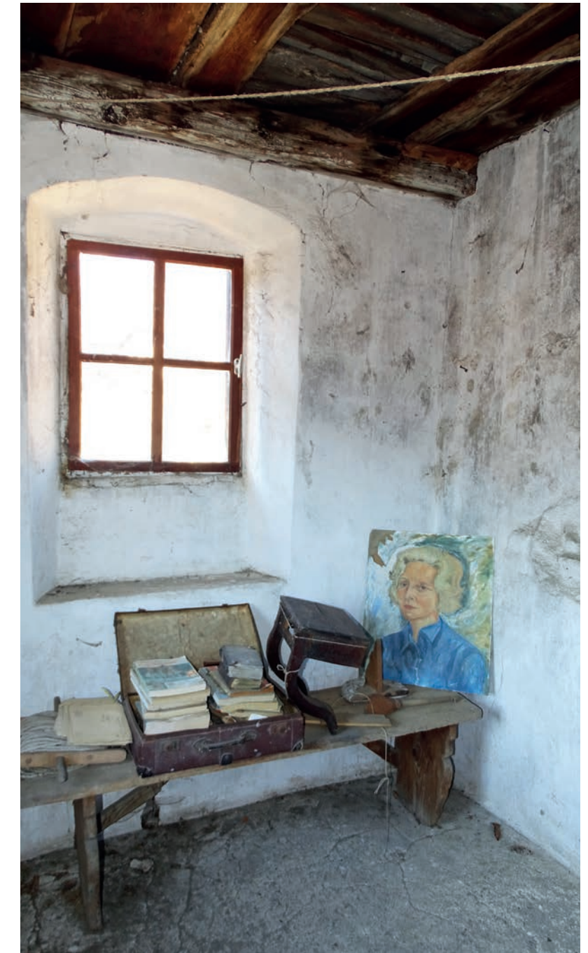
ABB. 293 ▲ Einfügeliges Holzfenster mit Kreuzprosse (Südwand).
