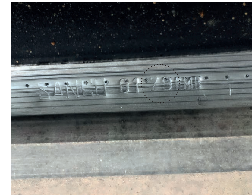
ABB. 120 ◀◀ Nachträglich eingebaute Trennwand im zentralen Mittelgang des 1. Obergeschosses.
