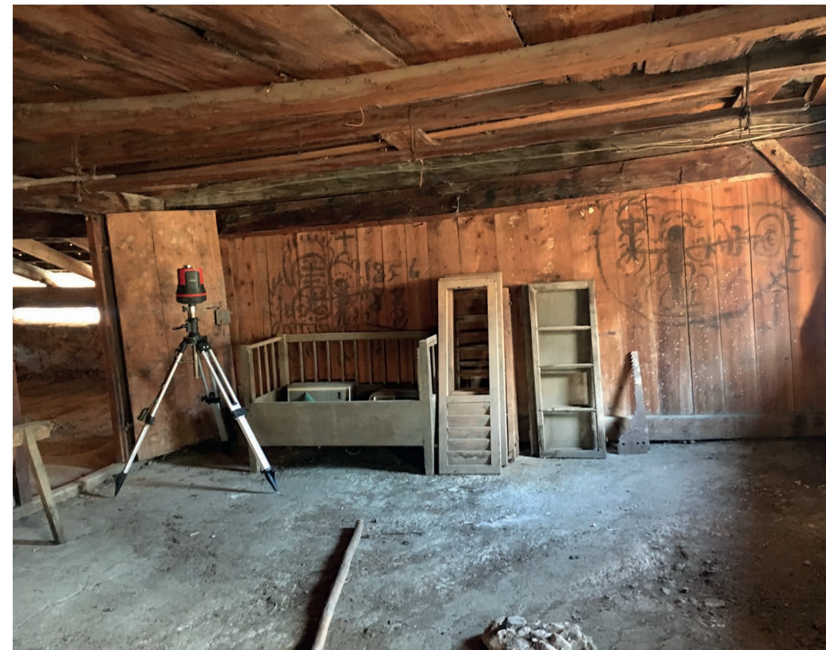
ABB. 137 ◀ Messung des Dachbodens mit dem 3D-Disto.
