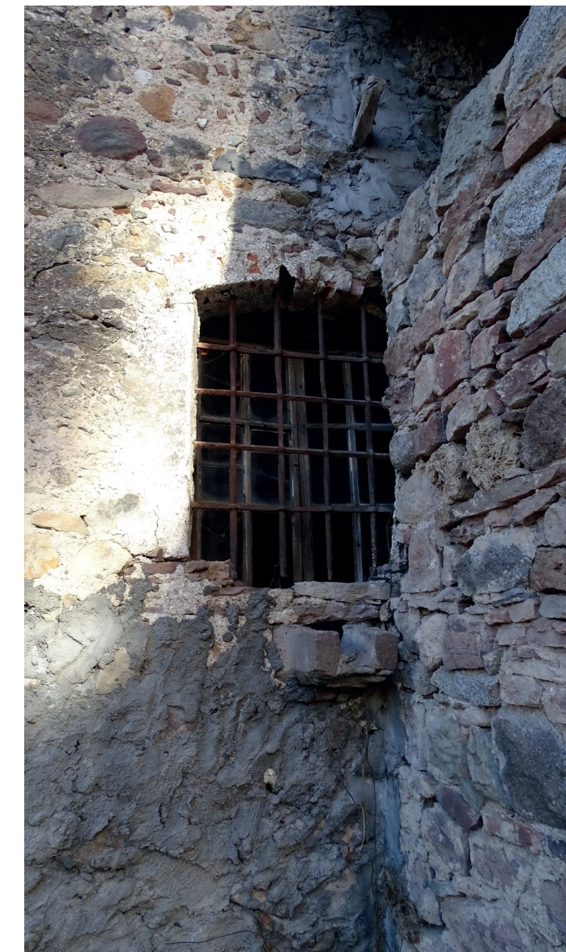
ABB. 115 ▲ Ehemalige zugemauerte Öffnung des Backofens an der Ostwand der Backstube. ( Siehe Raumbuch - EG.05 )
