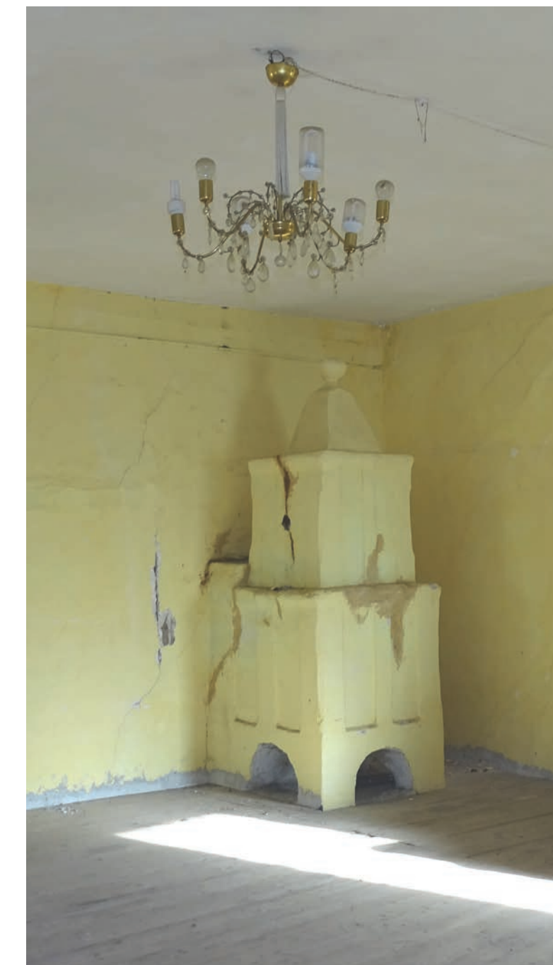
ABB. 77 ◀◀ Turmförmiger gemauerter Ofen mit gemauertem, geschlossenem Unterbau.
