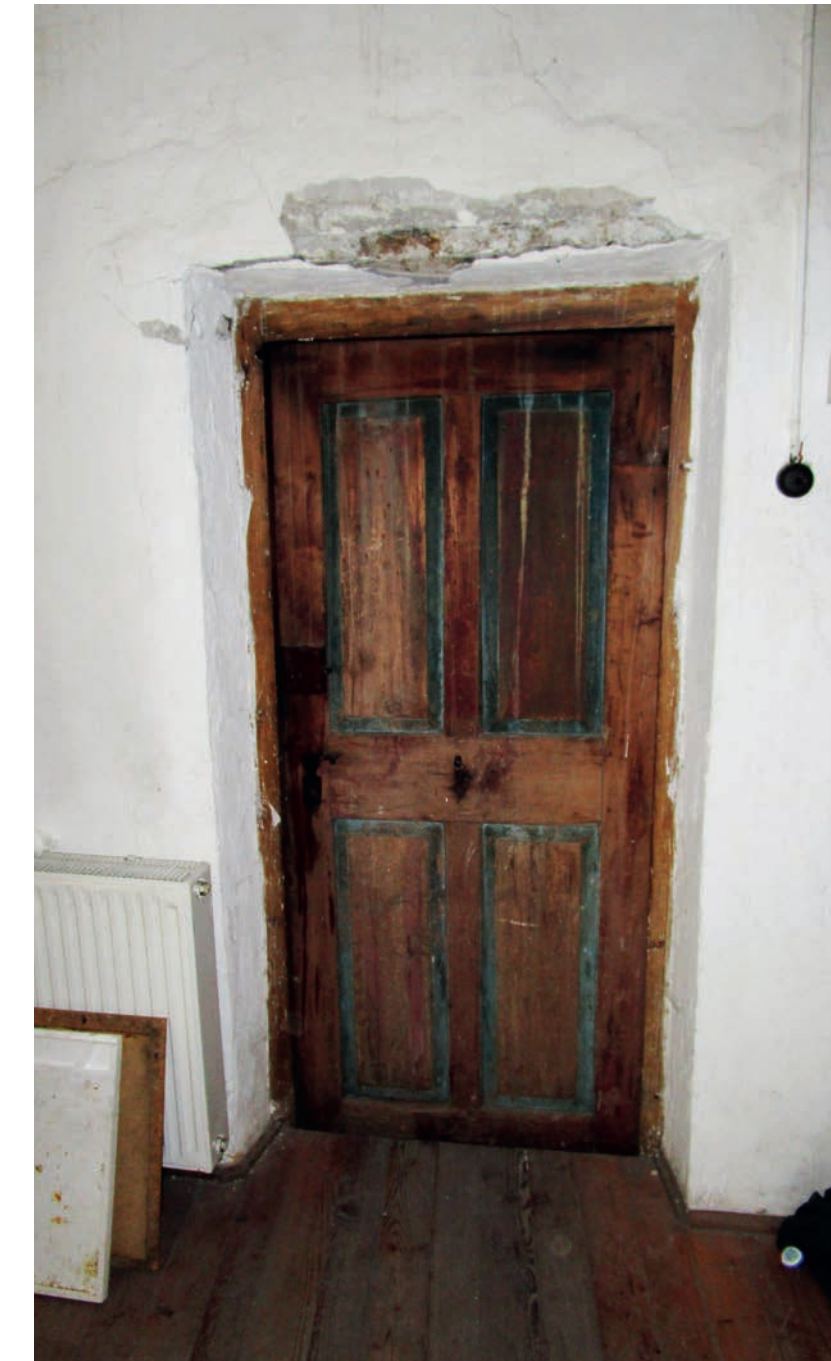
ABB. 230 ▲ Nördliche Raumwand mit eingebauter Nische, Gipskartonplatten des Badezimmers.
