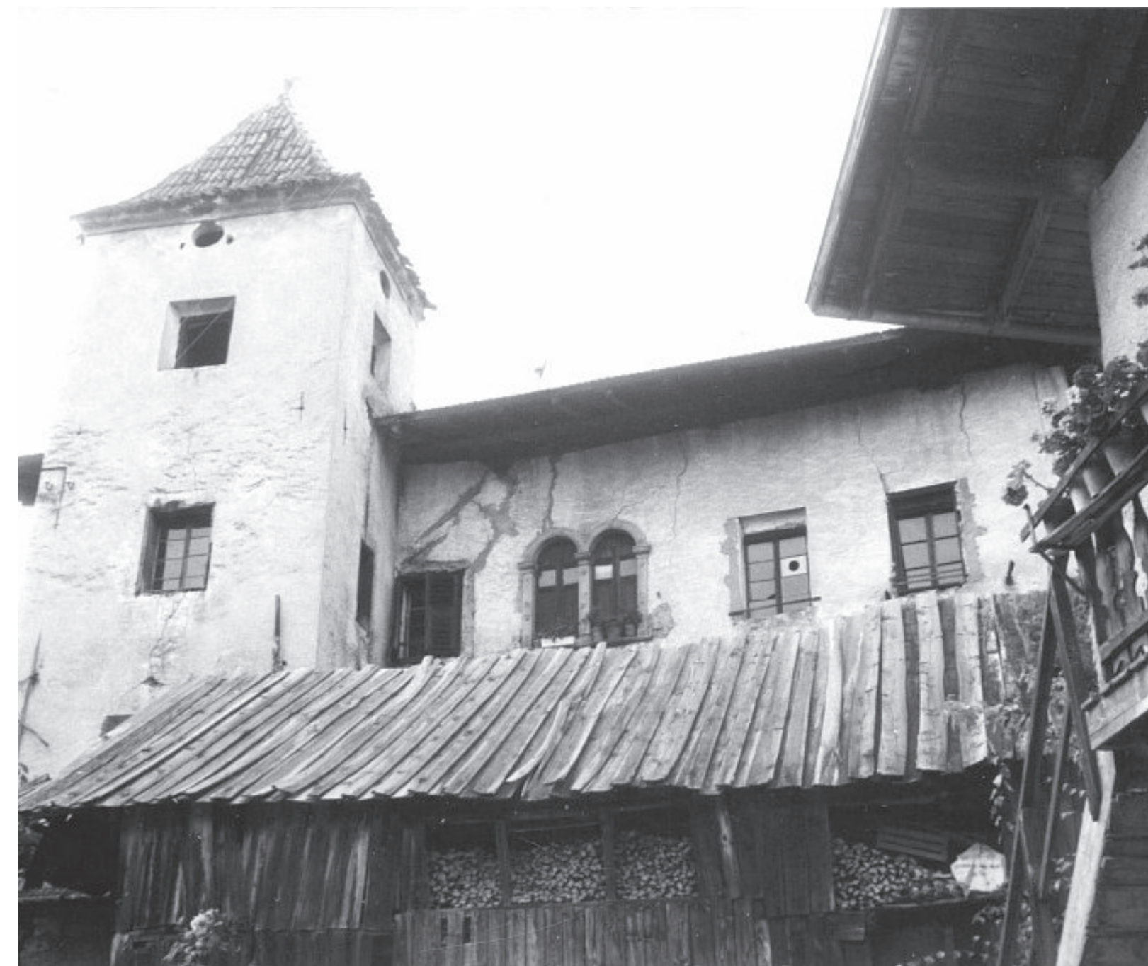
ABB. 90 ◀ Südansicht der ehemaligen Sägemühle des Unterbäcks , aufgenommen im Jahre 1940.
