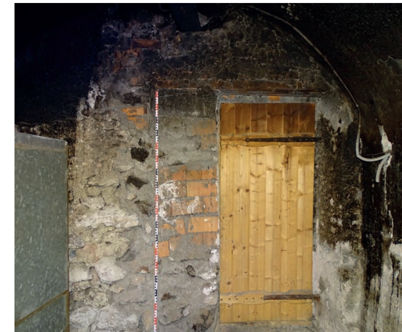
ABB. 223 ◀◀ Ehemalige Öffnung des Backofens an der Ostwand.
