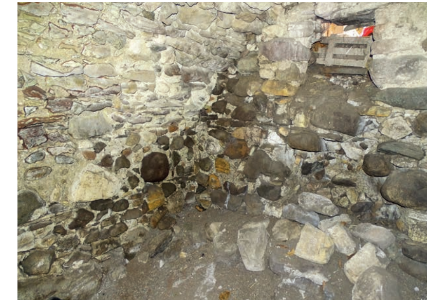
ABB. 301 ◀◀ Einflügelige Brettertür mit aufgedoppeltem Rahmen- fries, Ostwand.
