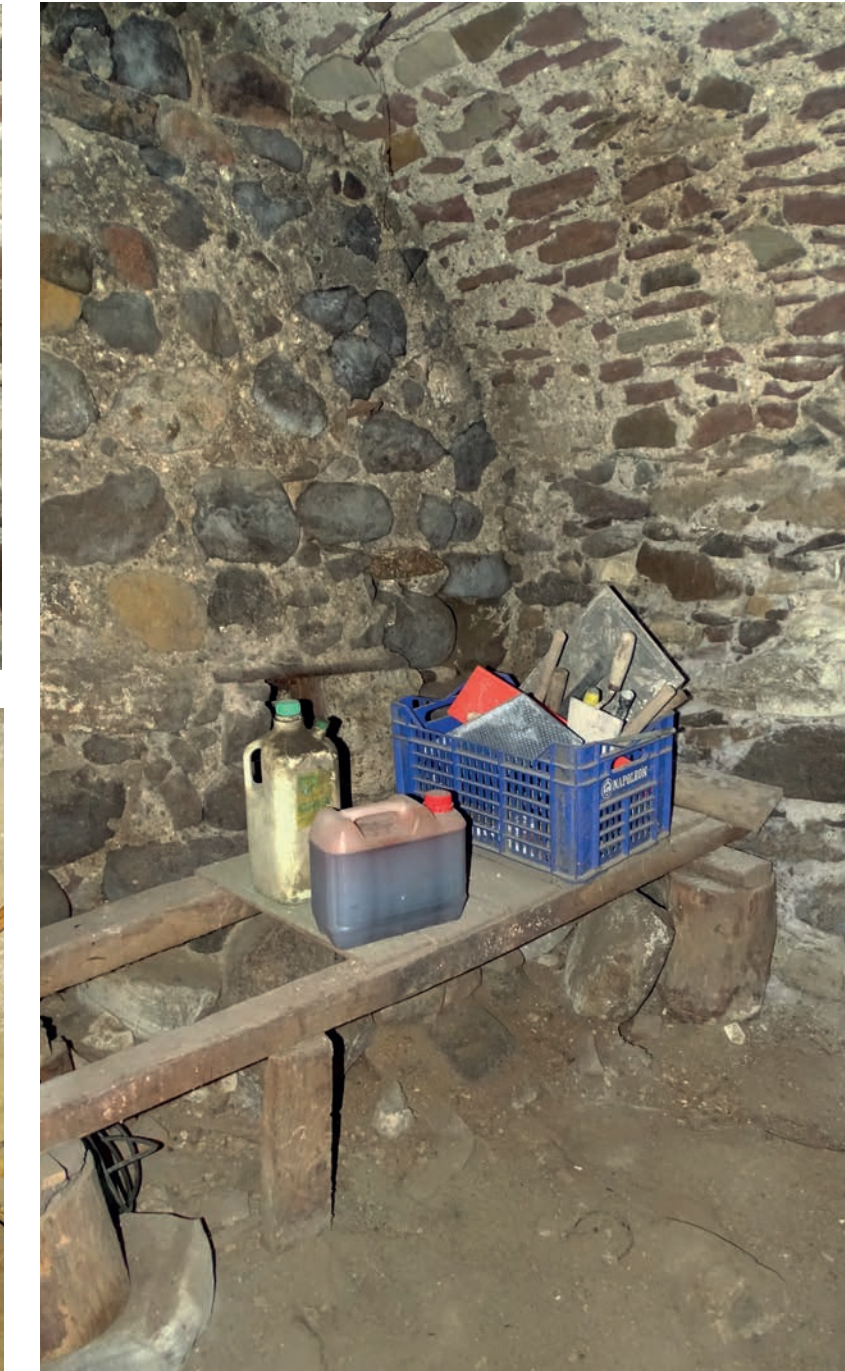
ABB. 108 ▲ Vergrößerung des südwestlichen Raumeckes. Baufuge zwischen der Außenwand des Kernbaus ( KG.07 ) und dem nachträglich geschlossenen Kellerraum ( KG.03 ).
