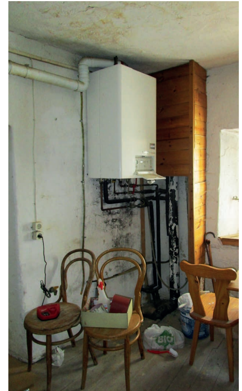
ABB. 227 ▲ Tür in den Hausgang, Abplatzungen des Anstriches oberhalb des Heizkörpers.
