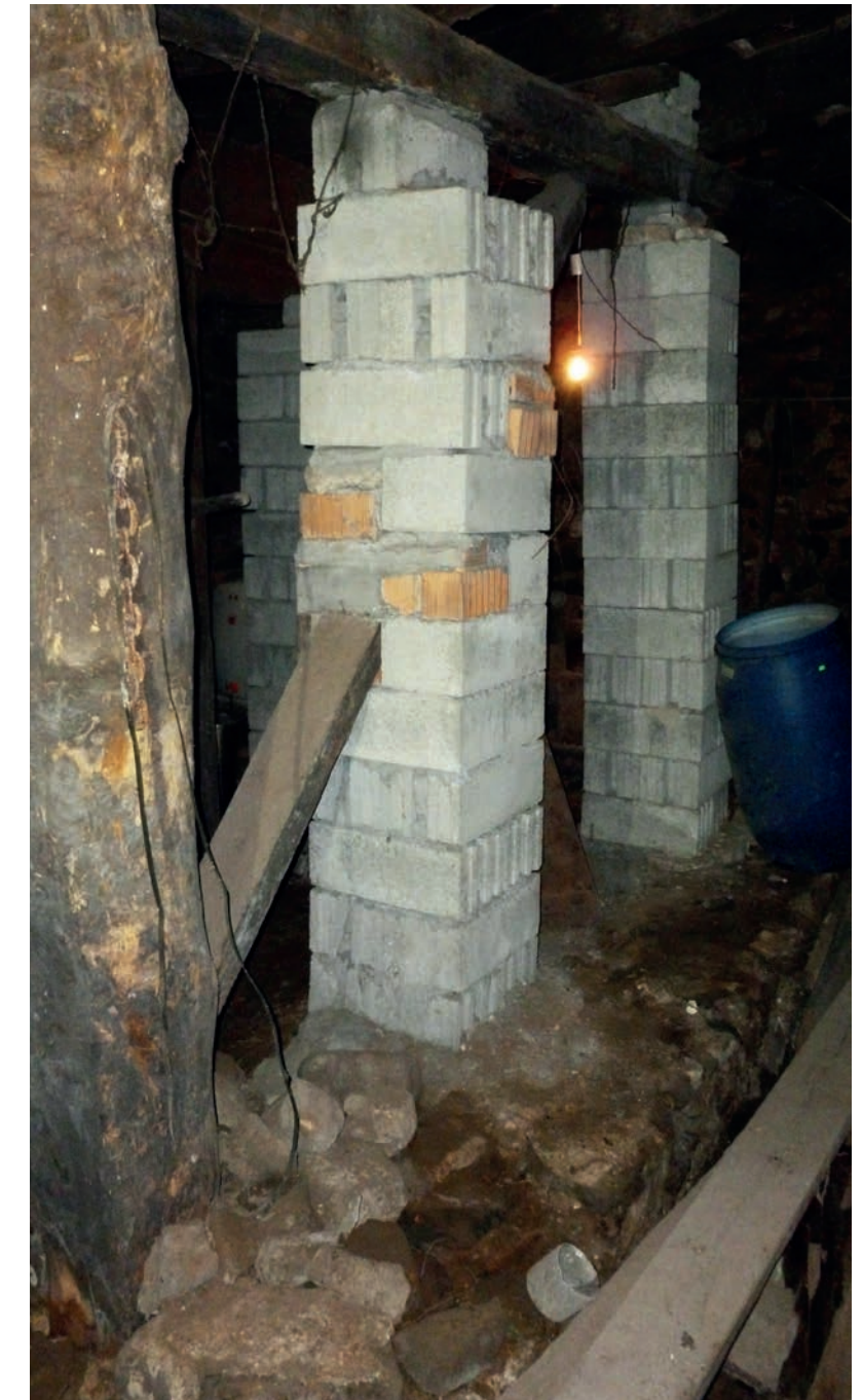
ABB. 202 ▲ Unterhalb der heutigen Decke ist noch ein abge- schnittener Holzbalken einer früheren Holzbalkendecke ersichtlich (Südwand).
