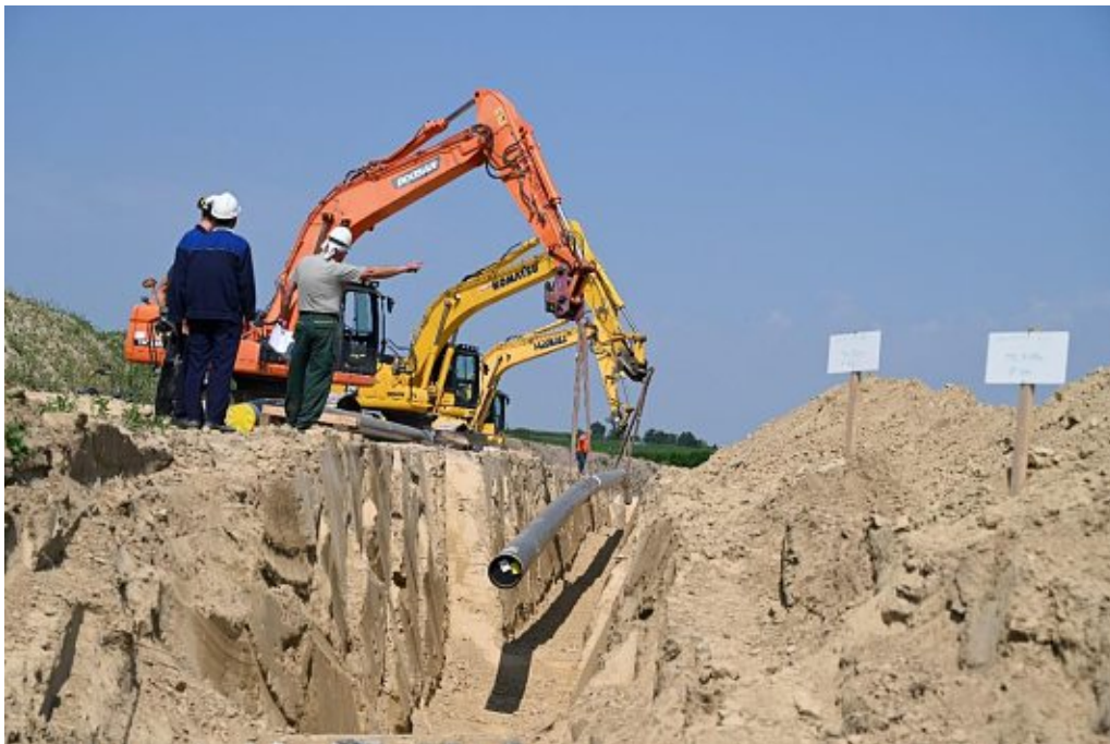
Abbildung 11 – Leitungsbau Leitung G-011 (Quelle: GCA o.J. d)
