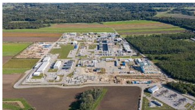
Abbildung 37 - Verdichterstation Baumgarten (Quelle: GCA 2019)
