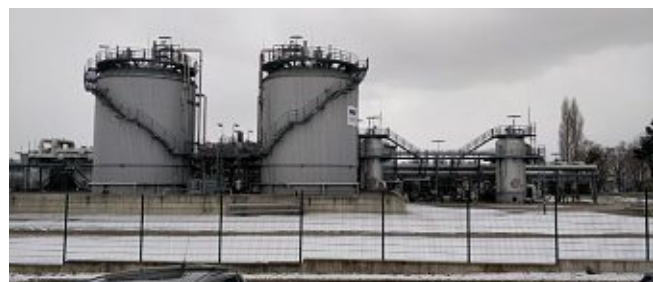
Abbildung 36 - Tanklager Auersthal (Quelle: eigene Aufnahme)
