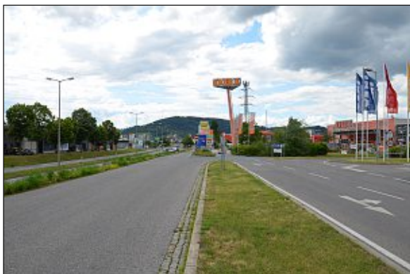
Abb. 11 | Nebenfahrbahnen Graz West
