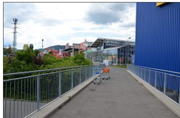
Abb. 14 | Ost-West Rad- und Fußverbindungsbrücke
