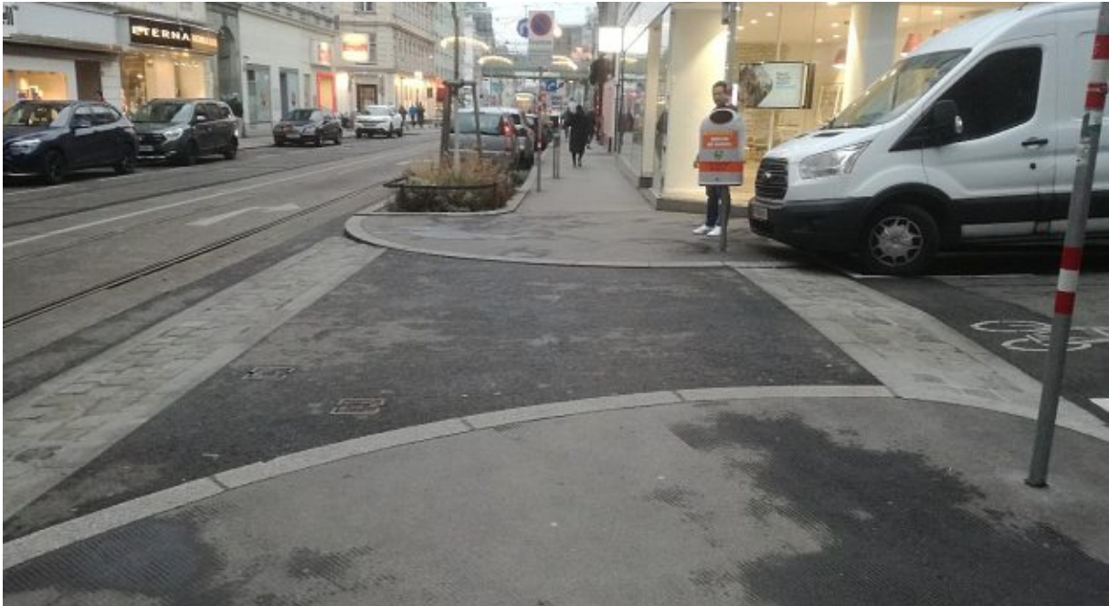
Abbildung 8: Fahrbahnanhebung im Mündungsbereich einer Nebenstraße (Wien, Währinger Straße)
