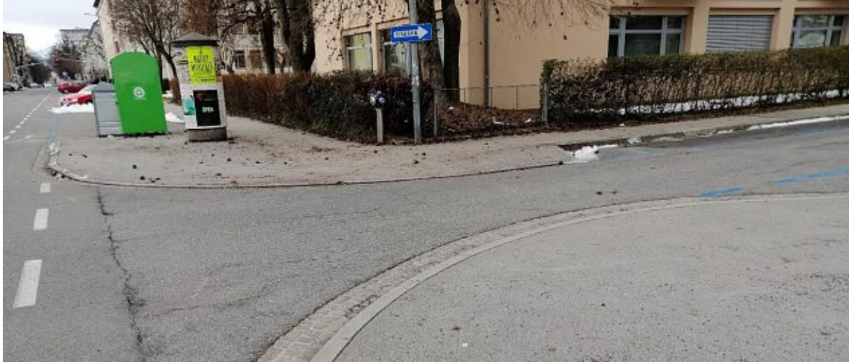
Abbildung 6: Gehsteigvorziehungen zur Reduktion der Querungslänge (Klagenfurt, Platzgasse)
