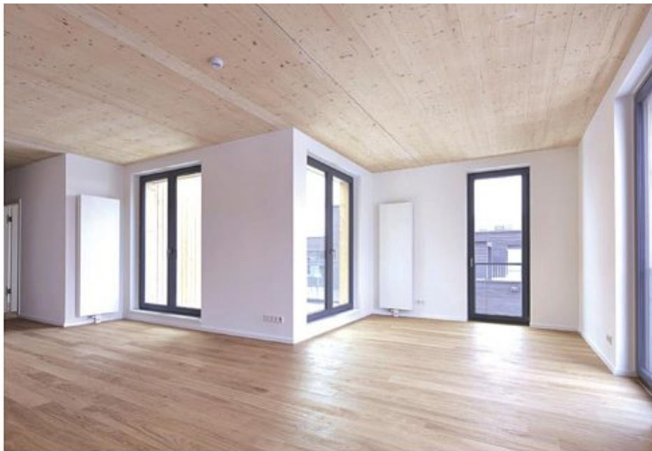
Abb. 2.5: Untersicht einer HBV-Decke [7]
