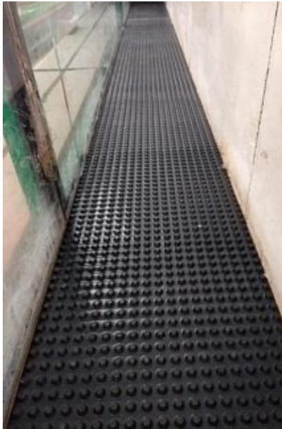
Abbildung 4: Noppenbahn zur Vergrößerung der Sohlrauheit.
