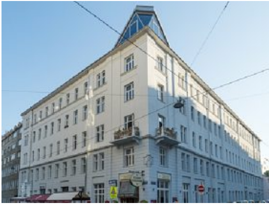
Abb. 24 Sockelsanierung Zieglergasse 25, Sanierung der Regelgeschosse, sowie Ausbau des Daches
