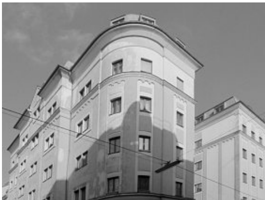
Abb. 26 Thewosansanierung Canisiusgasse 8 vorher
