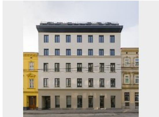
Abb. 23 Totalsanierung Thaliastraße 121 nachher
