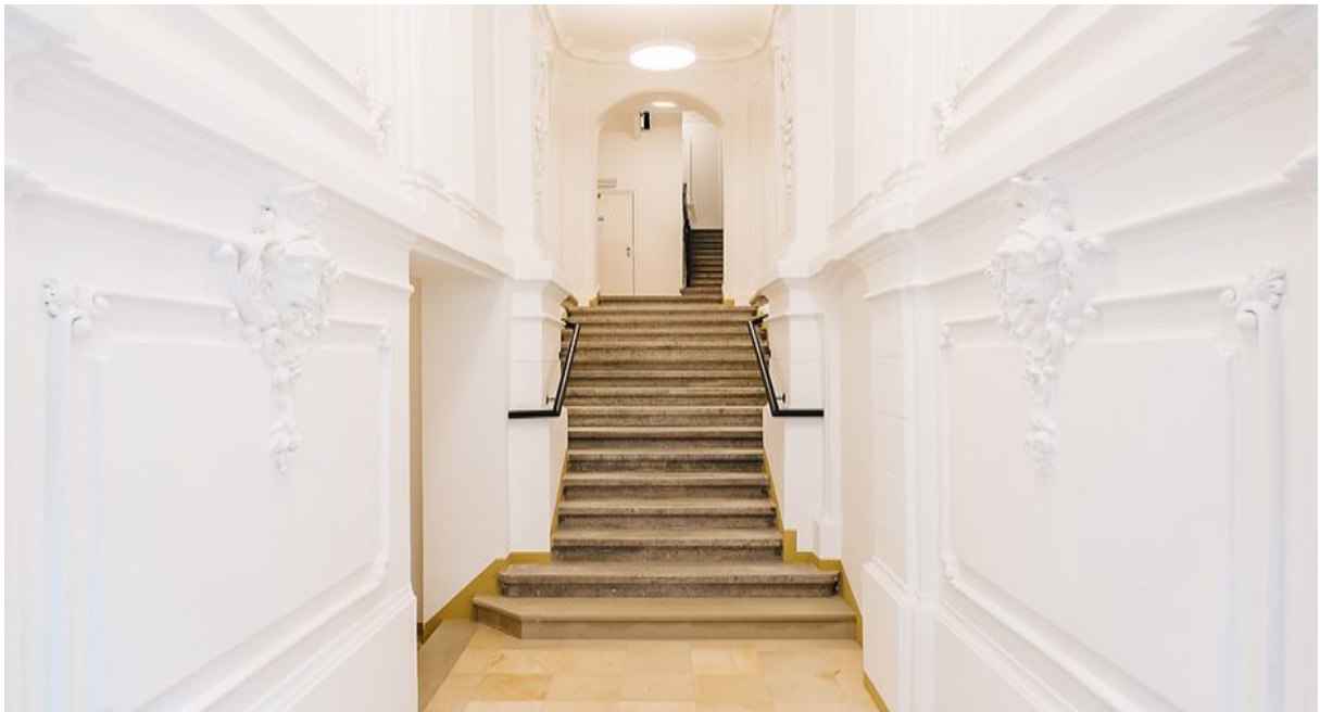
Abb. 9 Eingangsbereich nicht barrierefrei
