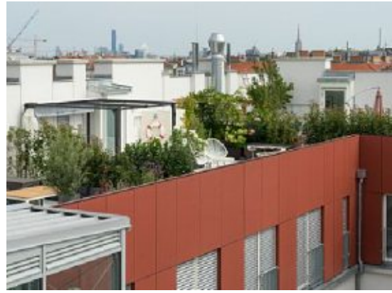
Abb. 25 Sockelsanierung Zieglergasse 25, Sanierung der Regegeschosse, sowie Ausbau des Daches
