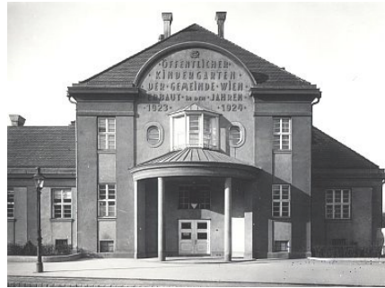
Abb. 2.1.2 Kindergarten der Stadt Wien, Fassade
