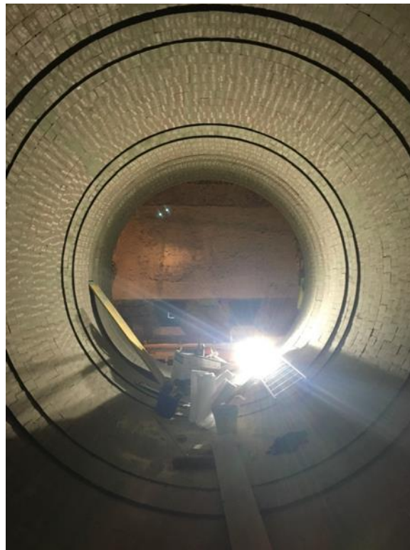
Abbildung 3: Innenraum des DRO 1 aus Sicht der Stirnwand
