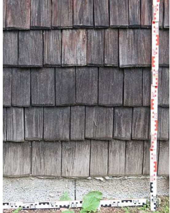
Abb. 52: Lärchenschindeln Westfassade, 2020
