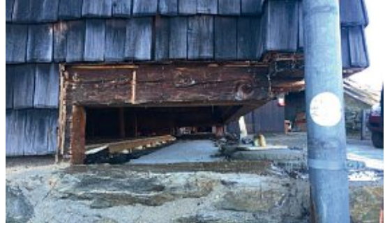
Abb. 90: Nord-Ost Kante der Grazer Hütte mit Überkämmung, 2015
