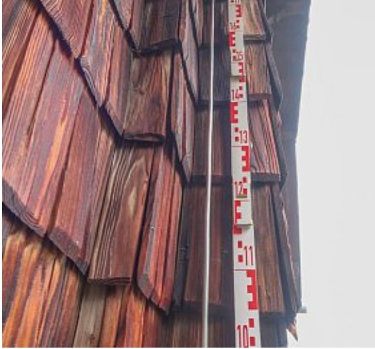
Abb. 46: „Herauskippen“ aus der Ebene der Außenschale, 2020
