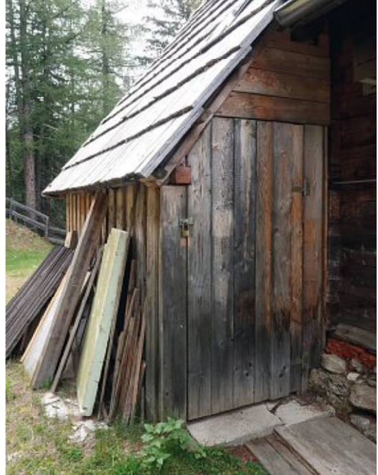
Abb. 97: Anbau Jagdhütte als Brettverschlag, 2020
