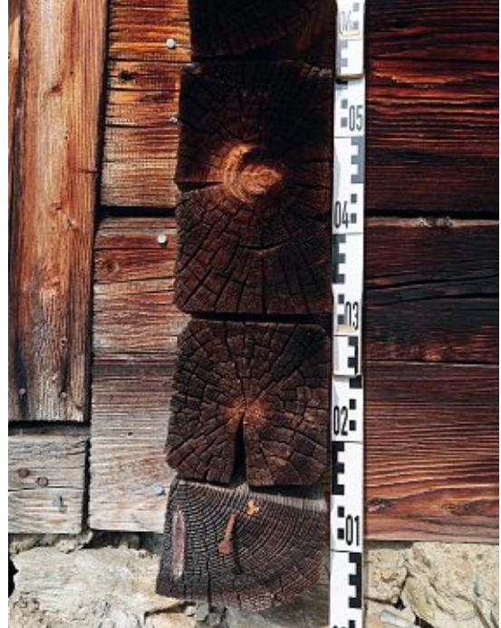
Abb. 102: Reiner Blockbau im Bereich des Stalls, 2020
