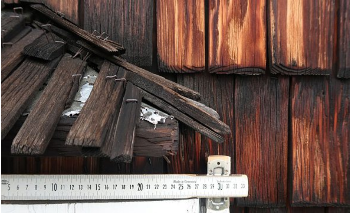
Abb. 47: Beispielhaftes Detail für die Schindeldeckung der Vordächer über den Sprossenfenstern und den beiden Türen, 2020
