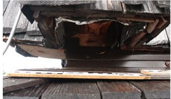
Abb. 36: Detail des Längsbalken mit dreilagiger Schindelverkleidung, 2020
