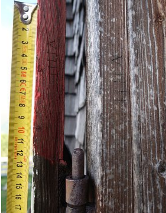
Abb. 38: Detail mit Feststellriegel der hölzernen Fensterläden, 2020
