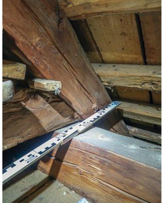
Abb. 71: Auflagerpunkt der Dachbalken mit Binder, 2020
