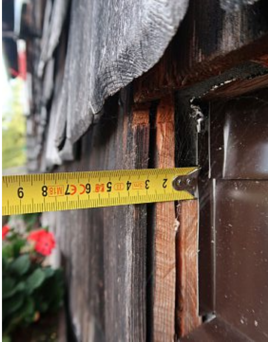
Abb. 42: Sägeraue Oberfläche der tragen Balkenunterseite, 2020
