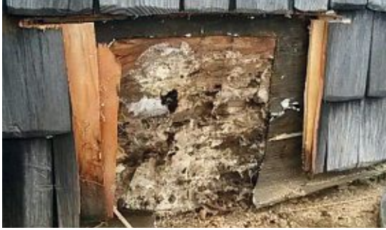
Abb. 91: Umfassender Eingriff in die Substanz zur Vorbeugung des weiteren Befalls, 2015
