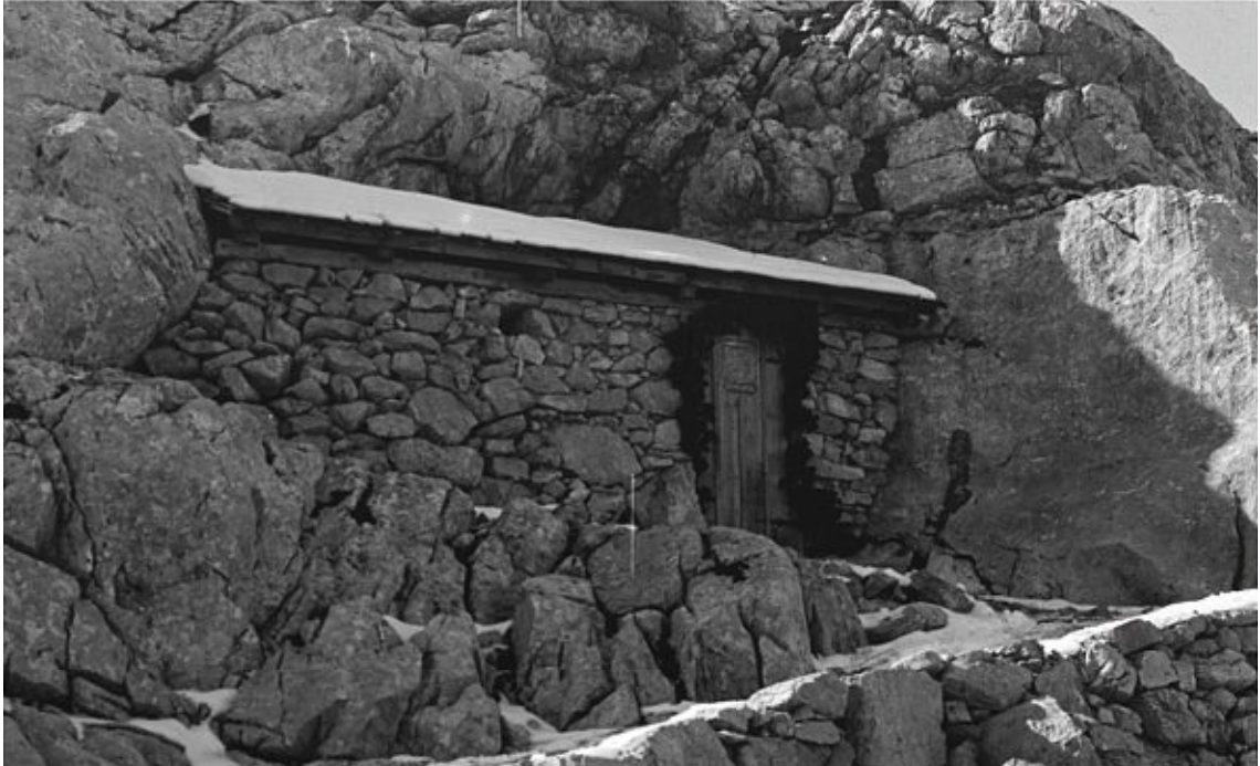
Abb. 18: Das ‚Hotel Simony‘ im Dachsteingebirge von 1843, in restauriertem Zustand um 1930
