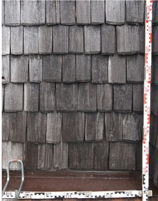
Abb. 49: Lärchenschindeln Nordfassade, 2020
