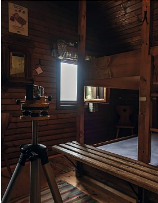
Abb. 9: Nivellierung der Meterlinie im Schlafsaal, 2020
