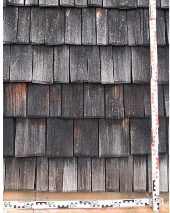
Abb. 50: Lärchenschindeln Ostfassade, 2020
