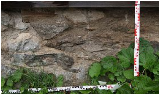
Abb. 34: Natursteinsockel unterhalb des Fassadenvorsprungs, 2020
