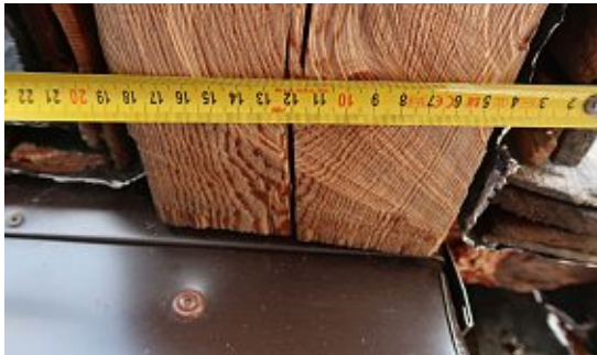
Abb. 42: Sägeraue Oberfläche der tragen Balkenunterseite, 2020
