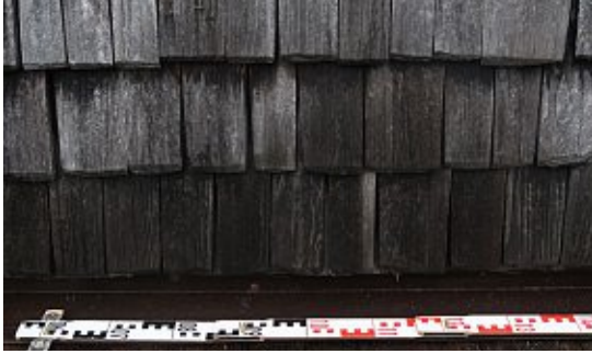
Abb. 33: Fassadenvorsprung mit neuen Lärchenschindeln gedeckt, 2020
