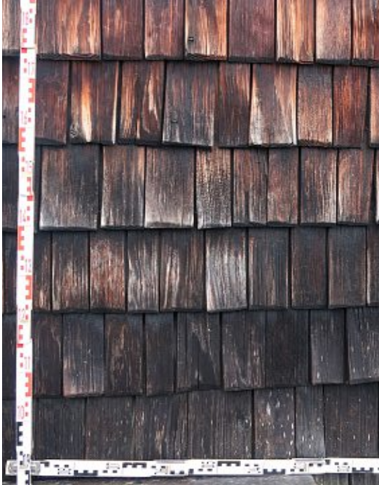
Abb. 51: Lärchenschindeln Südfassade, 2020
