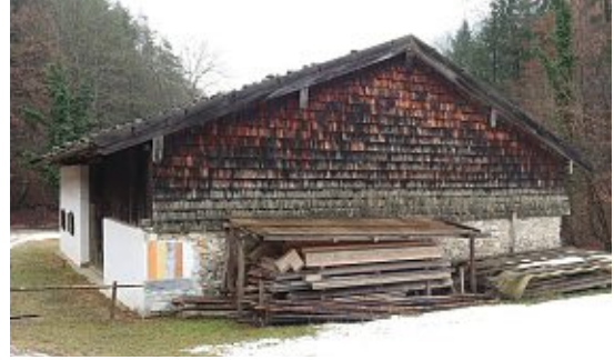
Abb. 118: Verschindelung der Rückseite eines Salzburger Stadels, 2021
