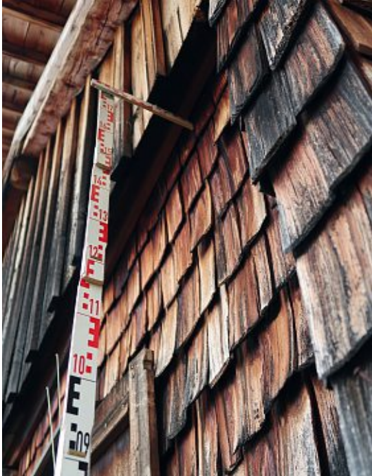
Abb. 101: Verschindelung im Bereich der Wohnräume, 2020
