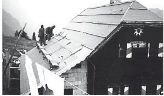
Abb. 87: Neueindeckung des gesamten Daches mit Eternitplatten, 1977
