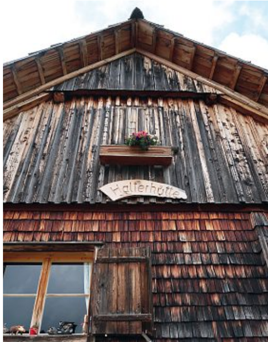
Abb. 100: Scharschindeln und Bretterschalung im Giebelbereich, 2020
