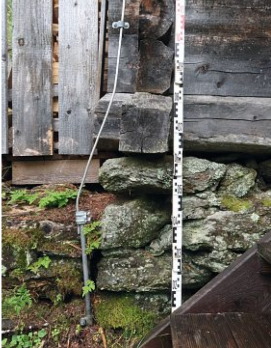
Abb. 96: Sockel aus Bruchstein mit aufgehendem Blockbau, 2020
