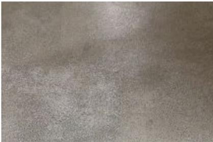
Abb.60. Boden - Monolithische Betonplatten geschliffen
