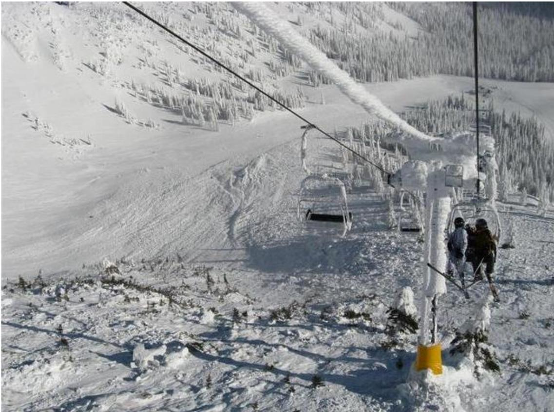
Abbildung 20: Eisbehang am Lufthängekabel und an den Stützen
