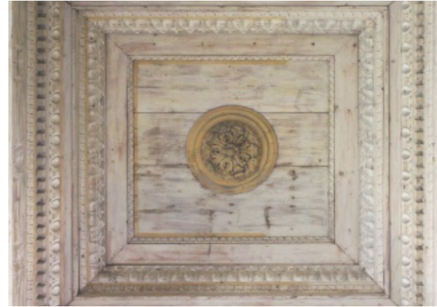
Abb. 52 Detail Decke der Halle
