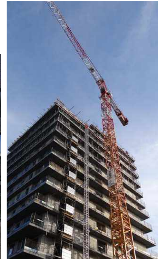
ABB. 71 Baustelle des Omnia-Towers
