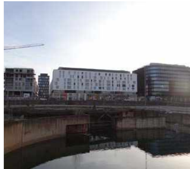
ABB. 67 Sinterbecken auf dem Parking Square Mile
