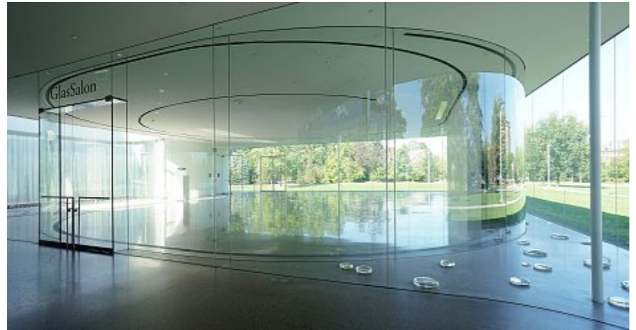
Abb. 22 Glaspavillon des Kunstmuseums, Sanaa: Fassade Abb. 23 Glaspavillon des Kunstmuseums, Sanaa: Innenraum
