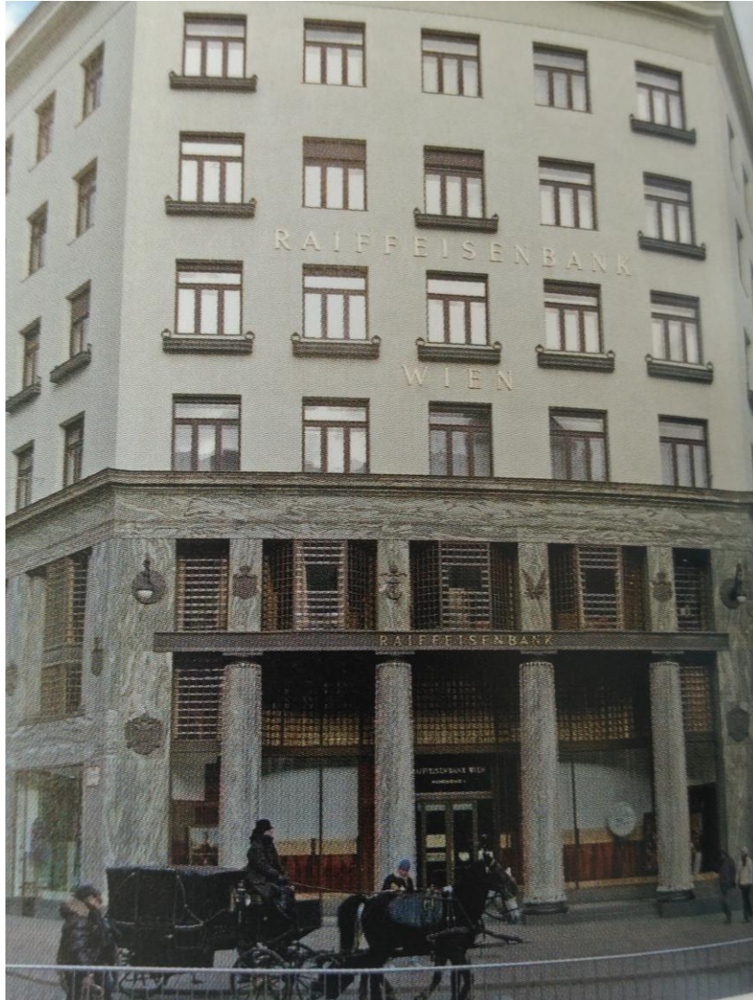
Abb. 73: Looshaus, Ansicht aktueller Zustand, Michaelerplatz, um 2010
