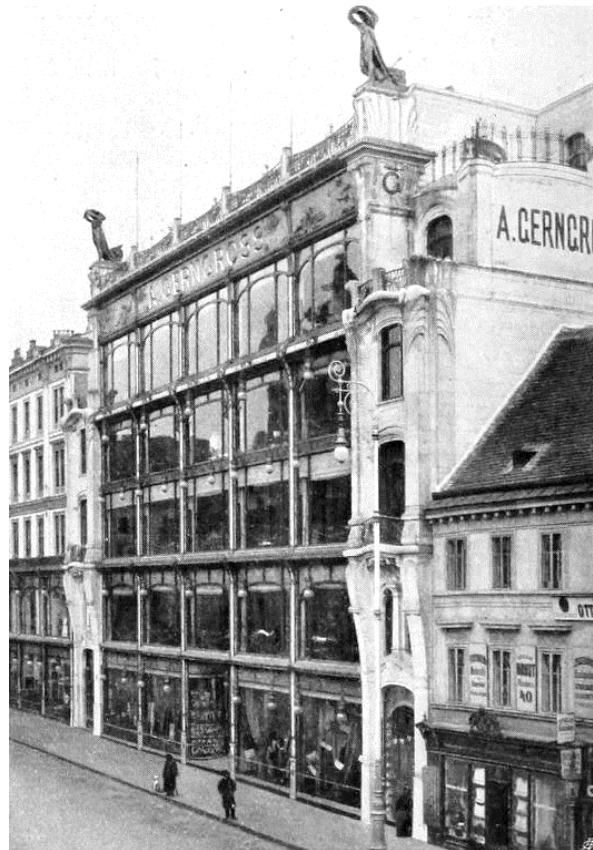
Abb. 6: Fellner & Helmer, Warenhaus Gerngross, Mariahilferstraße Wien, 1904
