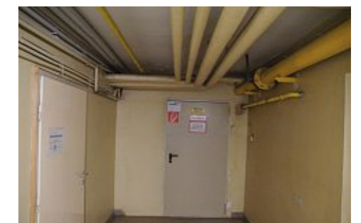
Abb.129: Tür am Ende des Ganges im Keller zum Heiz- und Technikraum
