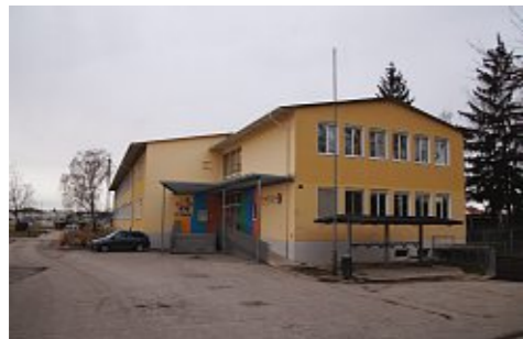
Abb.122: links der Haupteingang, rechts der Eingang der SchülerInnen im Untergeschoss
