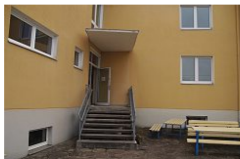
Abb.124: Ausgang vom Erdgeschoss (Eingangsbereich) in den Schulgarten
