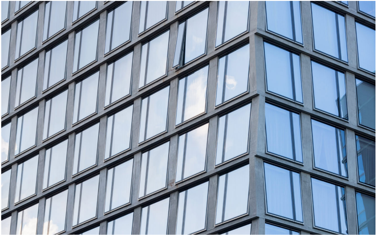
Abbildung 49: Fassade - The Public, www.herzogdemeuron.com , 2017
