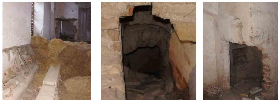
Abb.114-115: Reste des Heizungskanales im Mittelrisalit.
