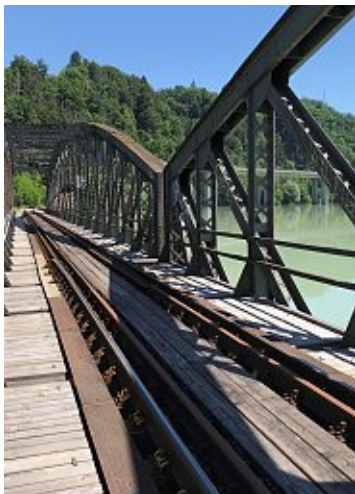
(a) Blick auf die offene Fahrbahn
