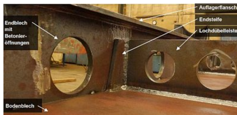
Abb. 4.17: Blick auf die Auflagerkonstruktion eines Versuchskörper aus [28]
