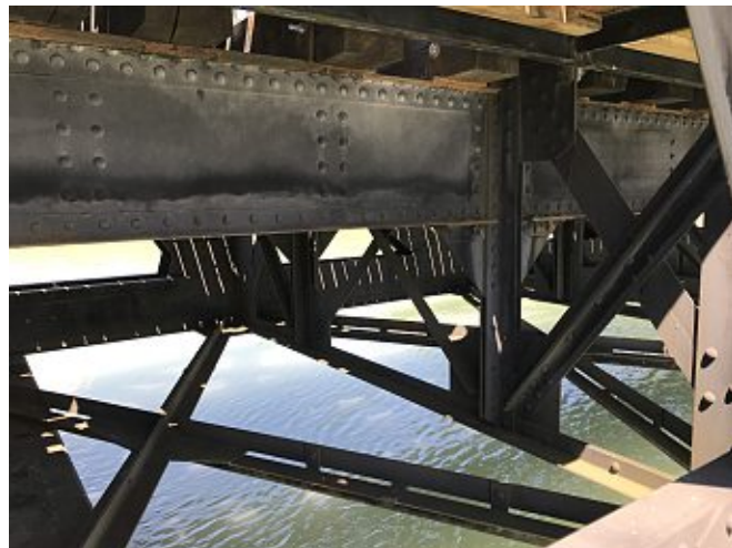
(b) Blick auf den Fahrbahnträger und die darauf liegenden Brückenhölzer
