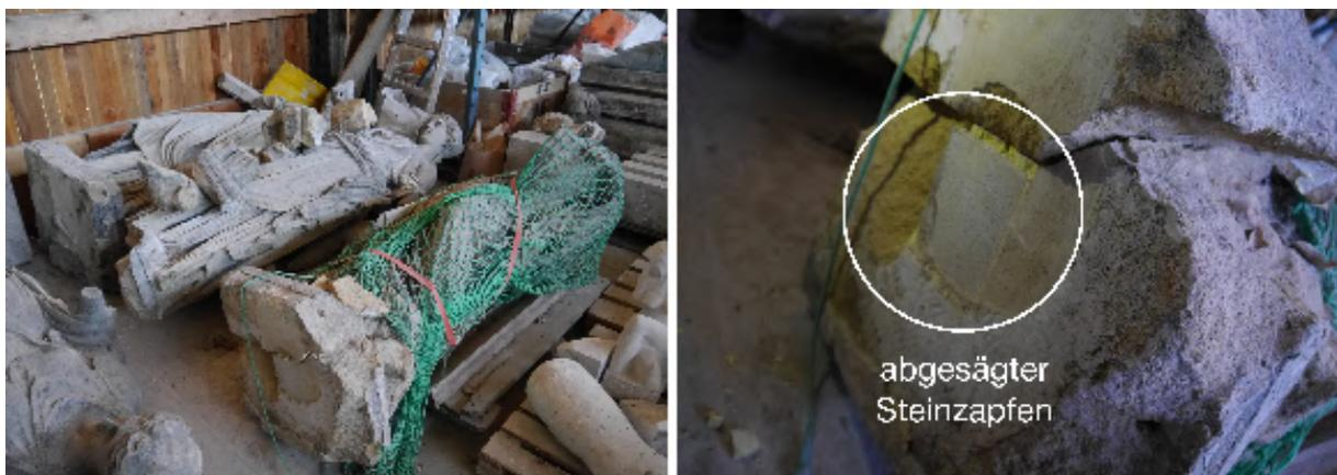
Abb. 1.4: (links) Demontierte Attikafiguren des Hauses der Ingenieure; (rechts) Sockeldetail der abgesägten Figur samt abgesägtem Steinzapfen (Autor, 2017)
