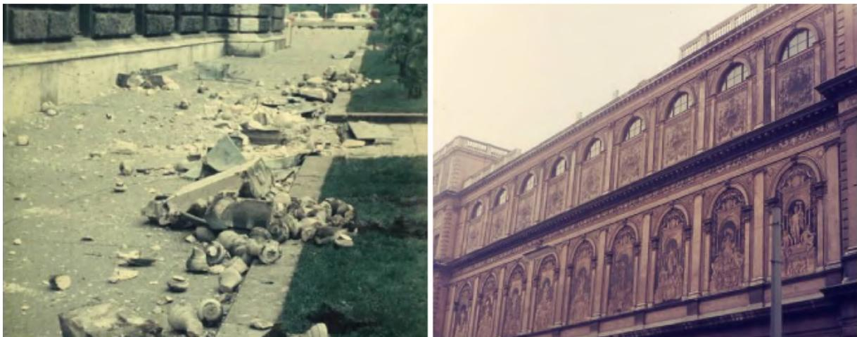
Abb. 1.5: Herabgefallene Teile der Balustrade des Hauptgebäudes der Universität Wien am 16.04.1972 (W. Eppensteiner, 1972; ZAMG, 1972)
