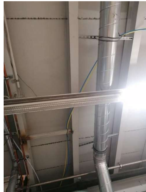
Unter-Boden-Verlegung (Leitungen zwischen PSA und Gasanalytik bzw. PSA und MFC-Steuerstand) → Keine Gefahr von Kontakt zu heißen Oberflächen bzw. mechanische Beschädigung
