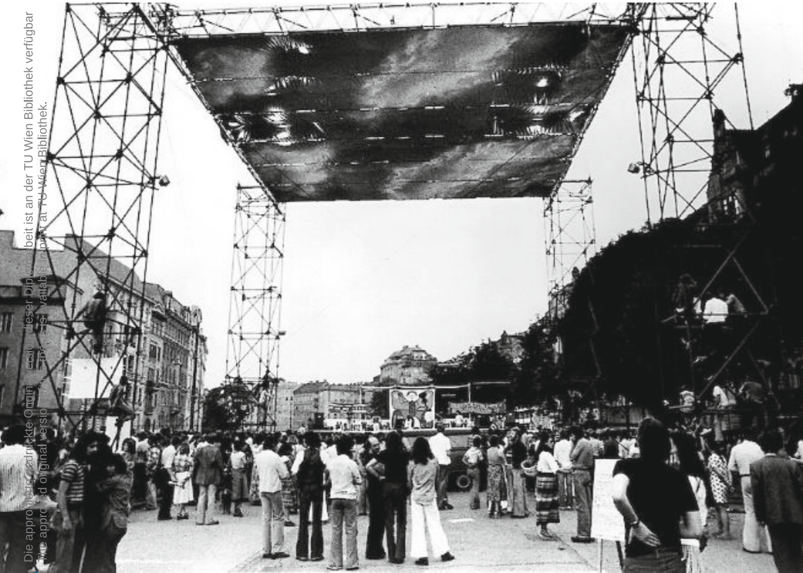
Abb. 19. Der Supersommer, 1976, Die Architektengruppe Coop Himmelb(l)au Bestehende Strukturen können zum Ausgangspunkt für viele Veränderungen werden.
