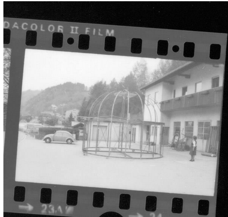
Abb. 21. Missing Link, Fotografie von der Metallkonstruktion, 1976
