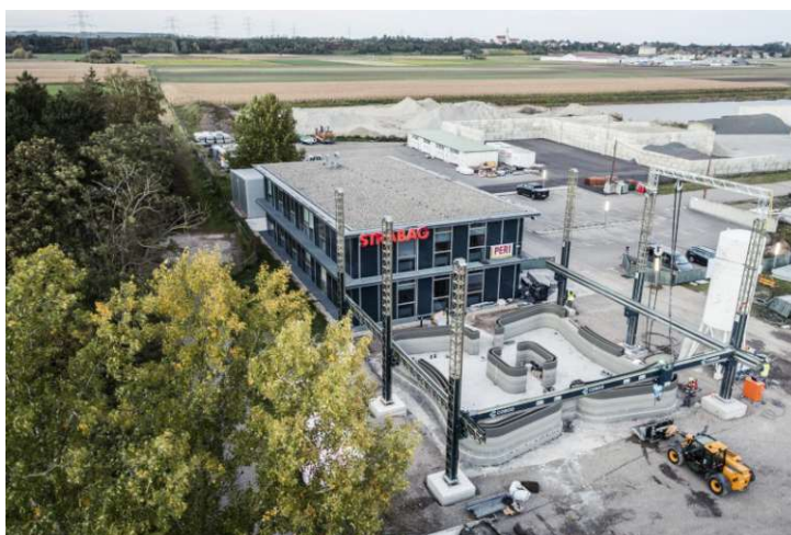
Abb. 3.31: 3D-Drucker bei der Errichtung eines Bürogebäudes [181]
