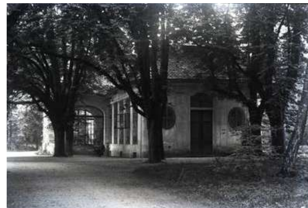
Abb.53: Alte Ansicht des Pavillons vom Schloss kommend, historische Aufnahme, Klunzinger
