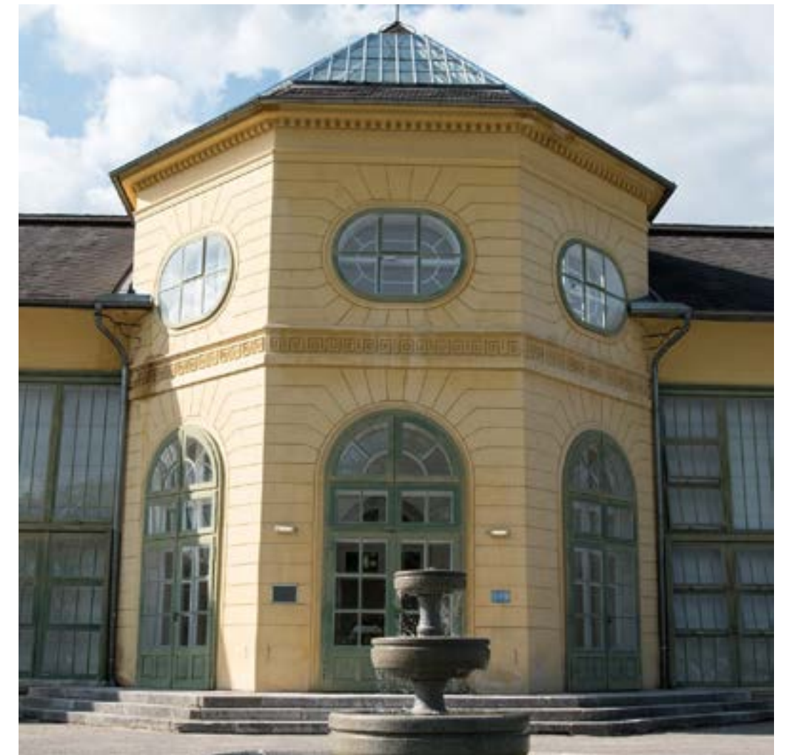
Abb.107: Mittelpavillon der Orangerie, Fotografie
