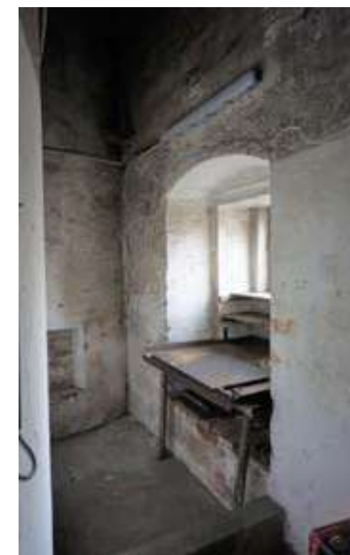
Abb.62: (links) "Zusatzraum an der Nordfassade, Fotografie, 2022
