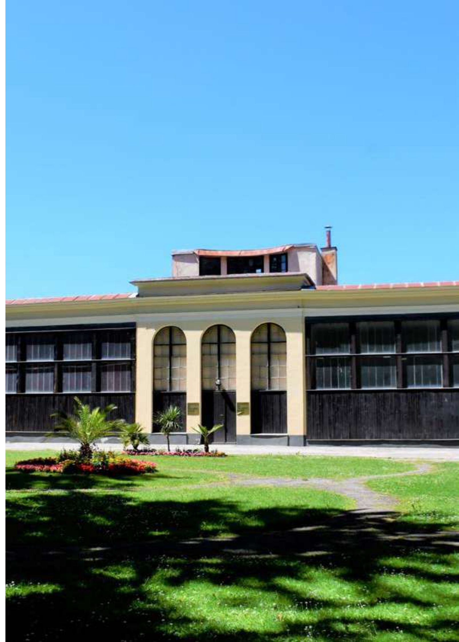
Abb.1: (rechte Seite) Südfassade der Orangerie im Schlosspark Steyr, Fotografie, 2021
