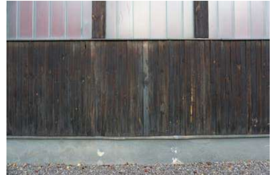
Abb.58: Detail der Verglasung an der Südfassade, Fotografie, 2022
