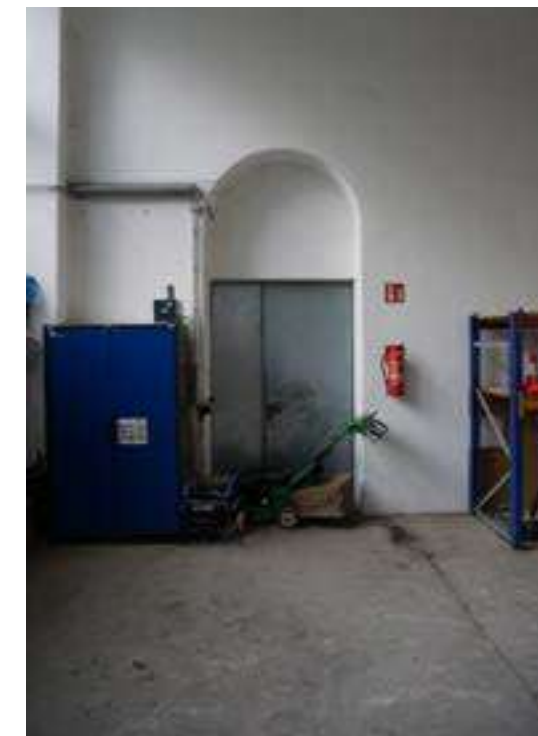
Abb.66: (links) Zugang aus dem rechten Orangerieflügel zum "Verteilerraum", Fotografie, 2022
