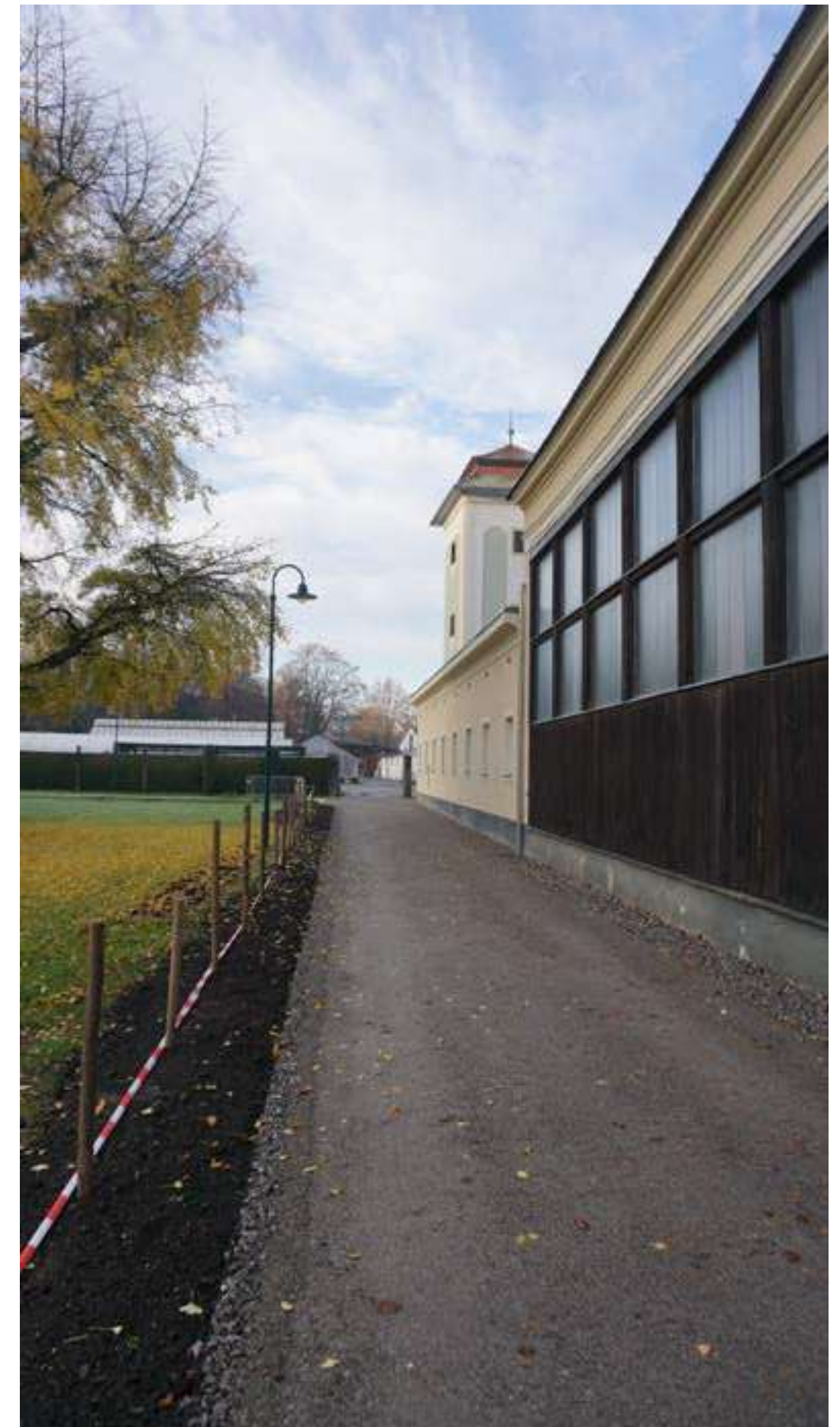
Abb.54: Südfassade des Palmen- hauses mit Blick Rich- tung Gärtnerei, Fotogra- fie, 2022
