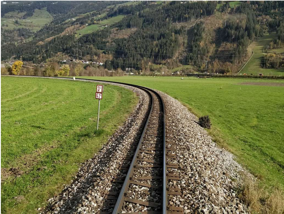
Abb. 3.5: Enger Bogen der Zillertalbahn mit Y-Schwellen und einer Geschwindigkeitsbegrenzung auf 35 km/h für Personenzüge und 25 km/h für Güterzüge (7.11.2022)
